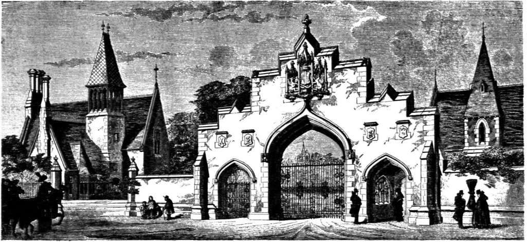
Eingangsportal des City of London Cemetery bei Ilford 97) .
