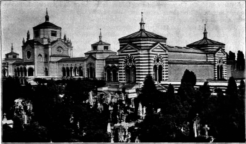
Teilansicht der Hallenbauten.
