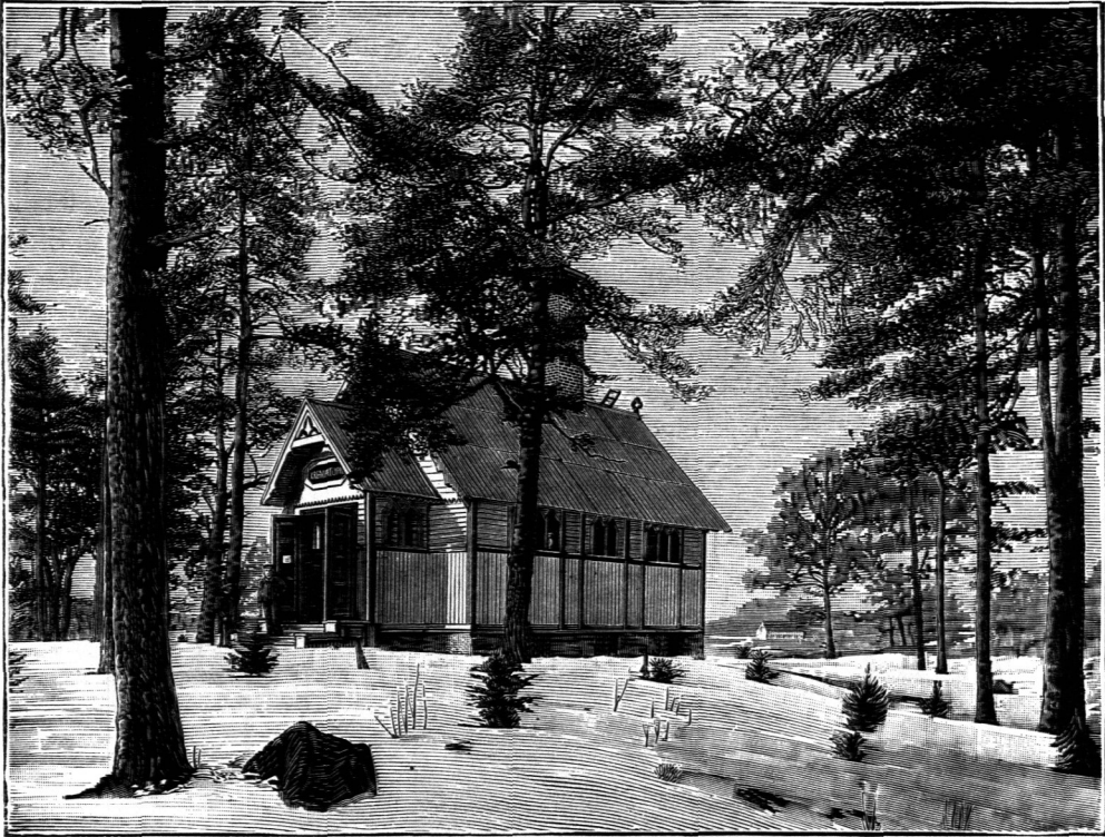
Provisorisches Leichenverbrennungshaus zu Stockholm 150 ).
