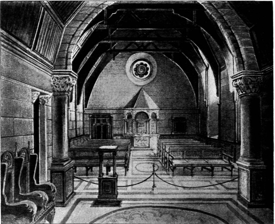
Innenansicht der Halle.
