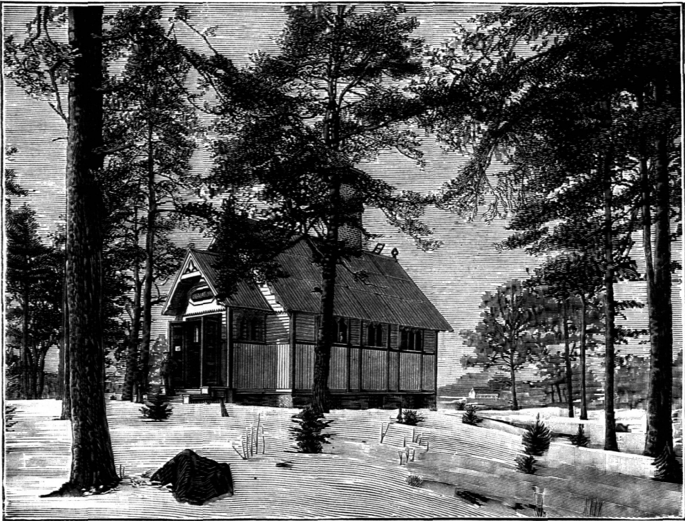
Provisorisches Leichenverbrennungshaus zu Stockholm 150 ).
