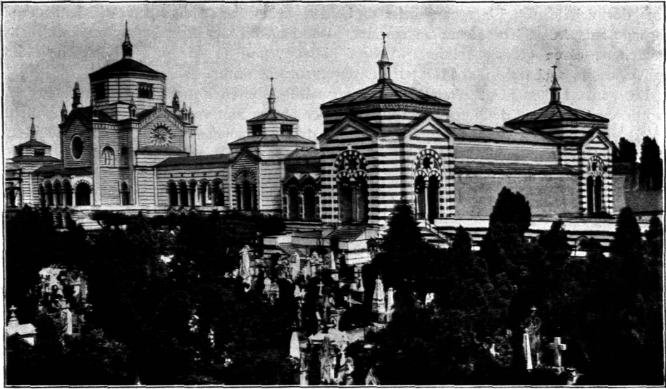
Teilansicht der Hallenbauten.
