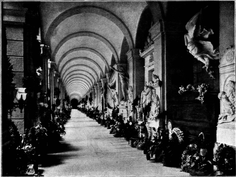
Innenansicht der Hallenbauten.
