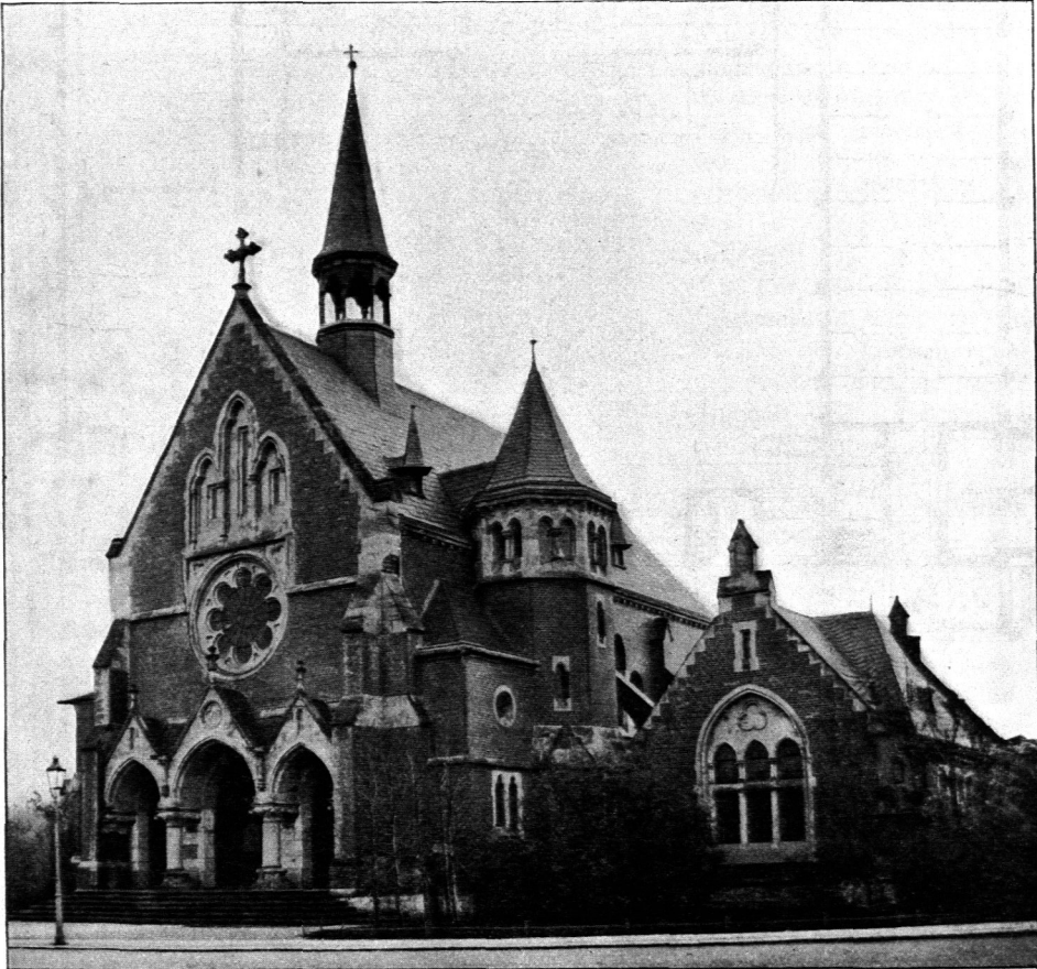
Neuer Westfriedhof zu Magdeburg. Nordwestansicht der Kapelle mit den Leichenhallen.
