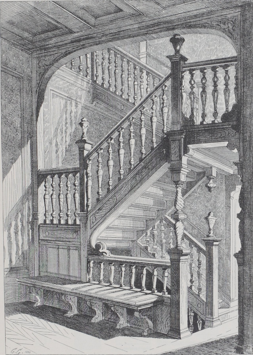
Treppe im Altersverforgungshaus zu Villemonble 14) .
