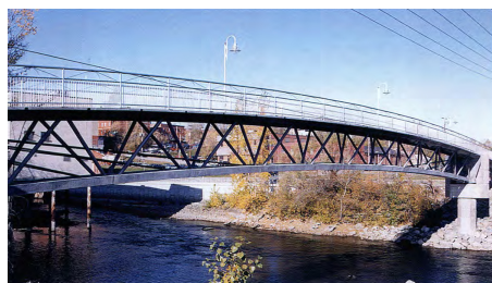
a) Sherbrooke-Brücke, Kanada [12]
