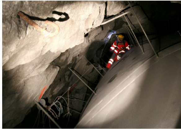
Abbildung 2.2: Untersuchung des Raumes zwischen Tübbing und Gebirge (Crocco, 2010).
