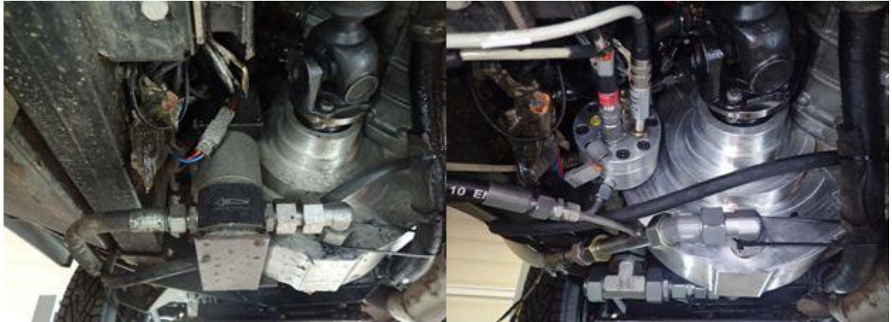
Abbildung 62: Umbau elektrische Absaugpumpe zu Strahlpumpe
