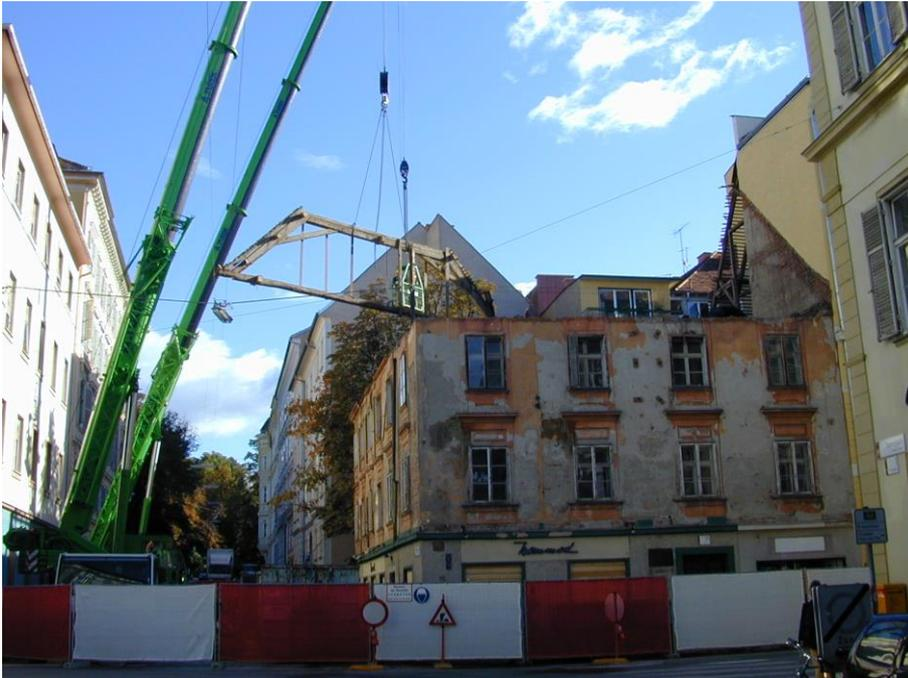
Abbildung 10: Abbruch des Dachstuhles am 06. Oktober 2003<sup>302</sup>
