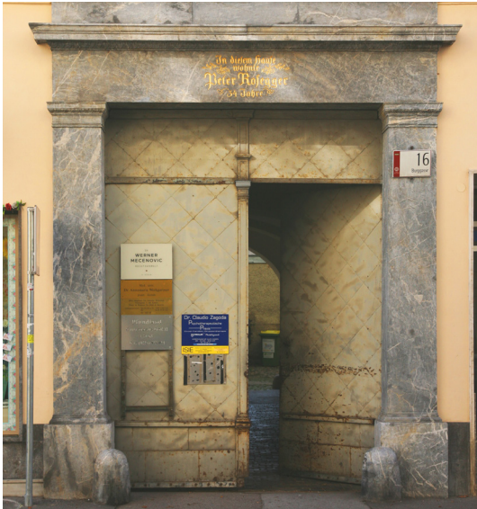
Eingangsportal Burggasse 16/Operring 10
