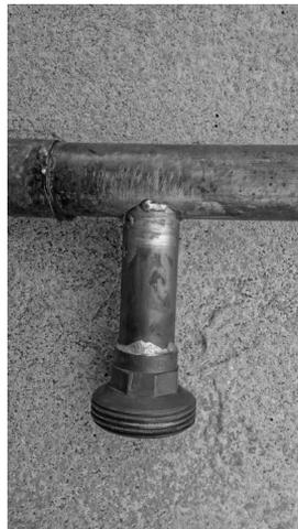
Mit einem Putzschwamm für Kupfer werden die Rohre jetzt gereinigt und poliert. Die Ecken werden händisch bearbeitet und die gerade Stücke mit der Schleifmaschine.
