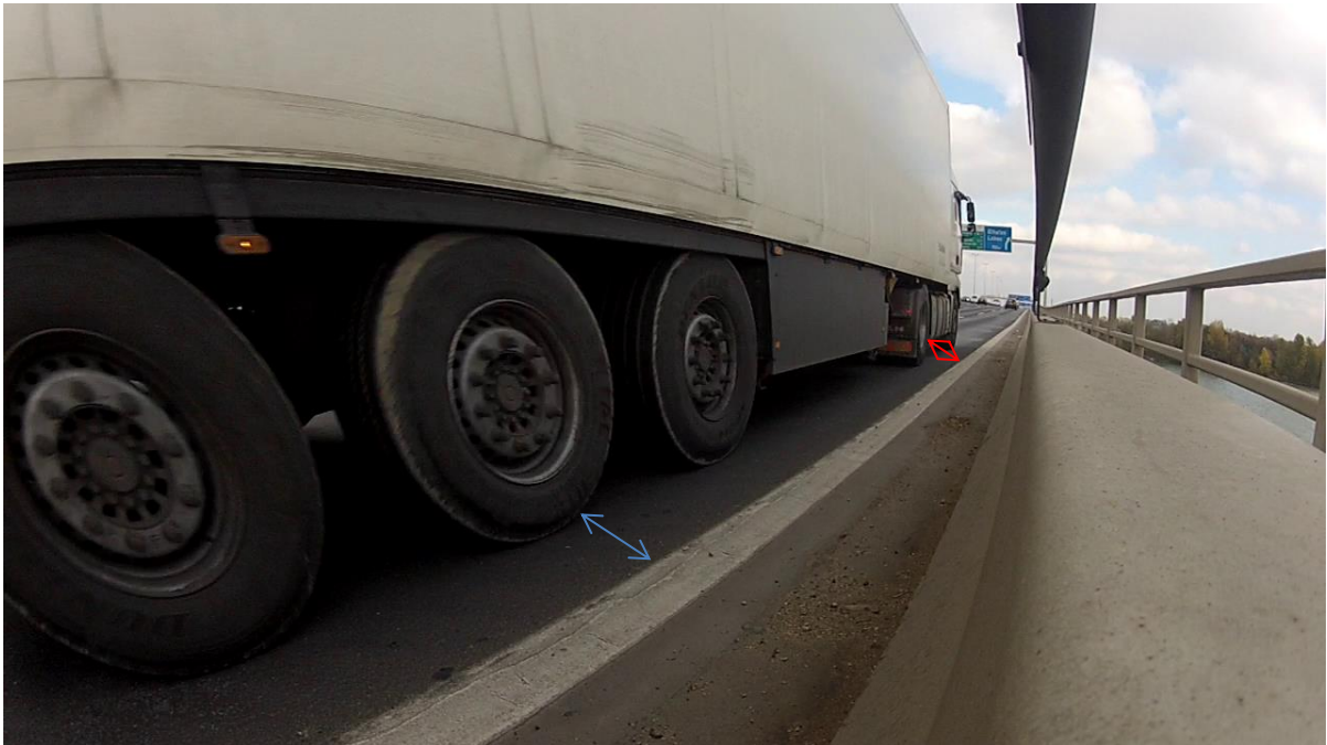
Abbildung 13: Schwerfahrzeug an einer Straßenbrücke
