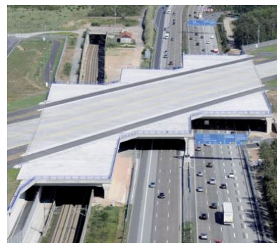
Rollbrücke Flughafen Frankfurt Steiger, H. et al. [2012, S.181]
