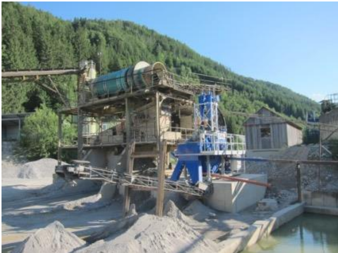
Abb. 5: Anlage zur Kiesproduktion am Standort mit Waschtrommel, Sieben und Zyklonen
