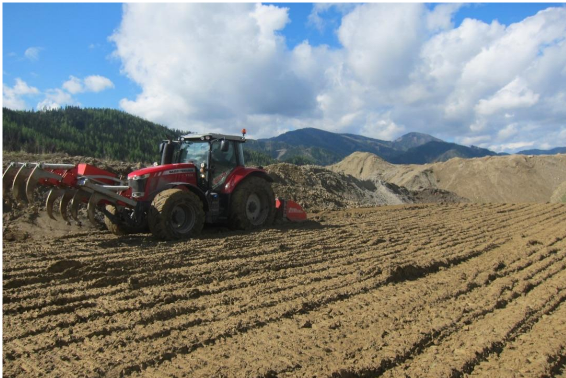
Abb. 51: Homogenisierung der Materialien mittels Bodenfräse
