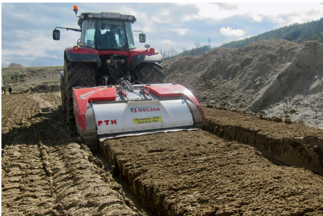
Abb. 52: Material nach erfolgter Fräsung
