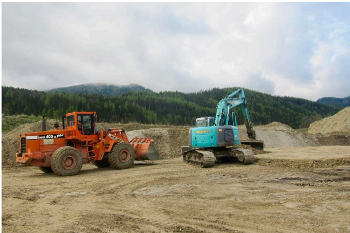
Abb. 50: Herstellung der Grobplanie mittels Kettenbagger und Radlader
