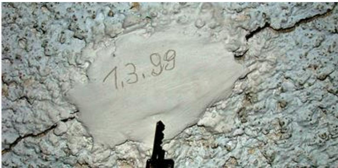
Abb. 124 Gipsmarker mit Datum (Meichsner & Rohr-Suchalla, 2011)
