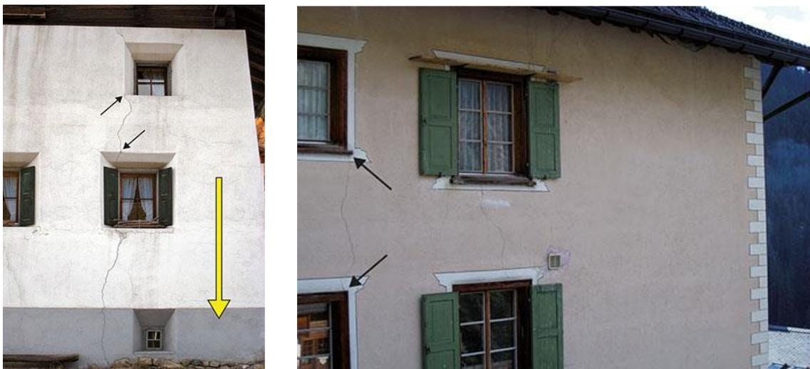
Abb. 53 Linkes Bild: Vertikale Setzungsrisschäden an Wänden parallel zur Hanglage; Rechtes Bild: Kerbrisse an Fensteröffnungen (Dialer, 2016)
