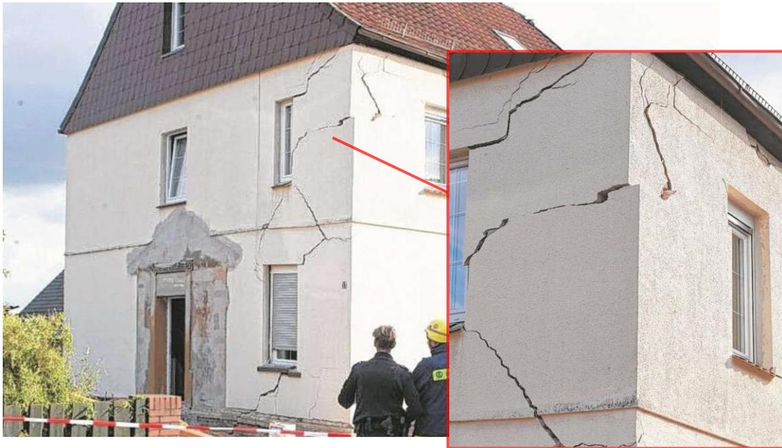
Abb. 52 Linkes Bild: Schwere Schäden an einem Wohngebäude; Rechtes Bild: Detailaufnahme der Risschäden<sup>19</sup>
