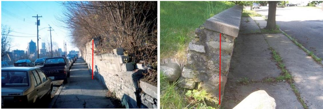
Abb. 110 Linkes Bild: Verformung einer Mauerwerkswand unter einem Kriechhang<sup>65</sup>; Rechtes Bild: Kippen einer niedrigen Stützmauer<sup>66</sup>
