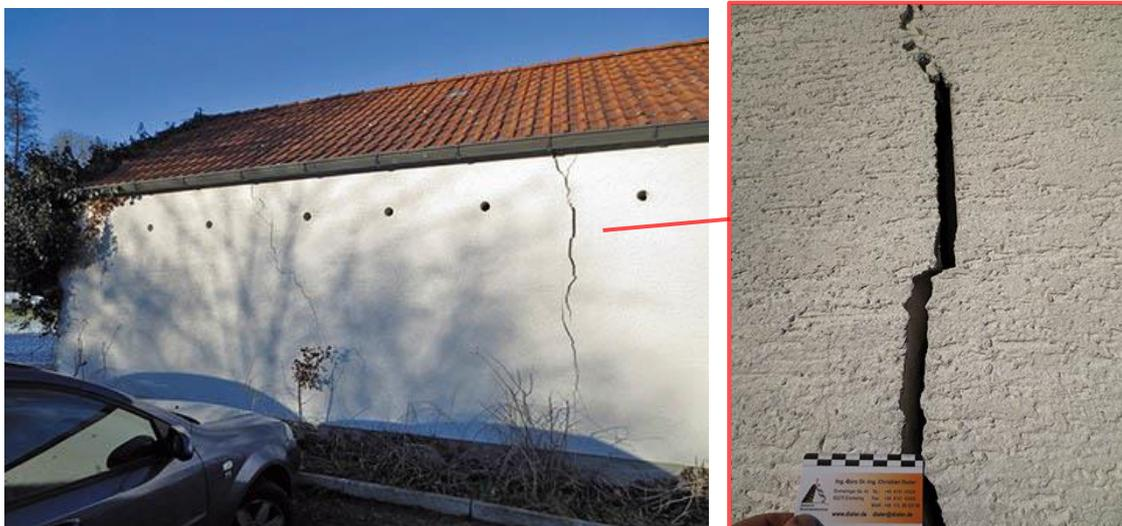
Abb. 47 Linkes Bild: Mauerwerkswand mit vertikalem Rißverlauf, Rechtes Bild: Große Rissbreite bei vertikalem Rißverlauf im Detail (Dialer, 2016)
