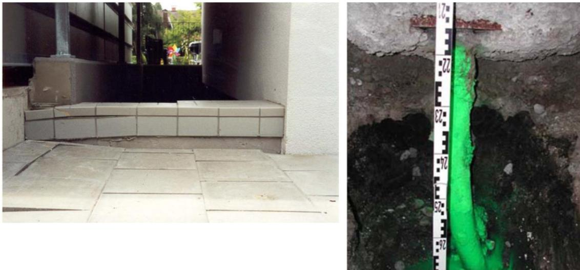
Abb. 78 Linkes Bild: Schwere Schäden an einer Wohnanlage; Rechtes Bild: Versagen einer Micro-Pfahlgründung (Wohnanlage)
