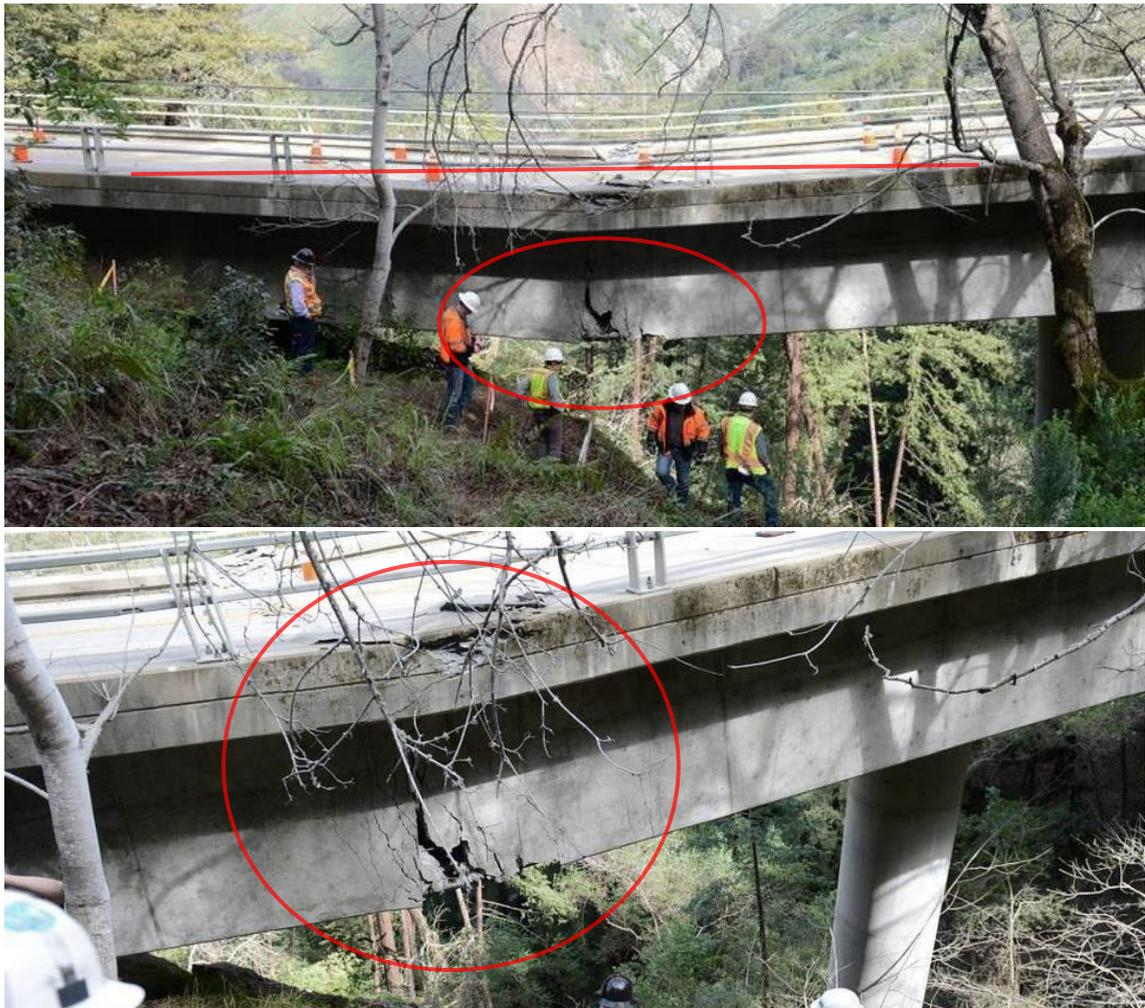
Abb. 174 Schwerer Schaden an einem Brückentragwerk<sup>107</sup>
