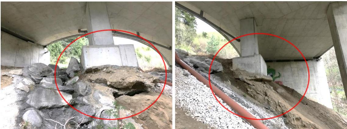
Abb. 171 Ein unterspültes Brückenpfeilerfundament (Ramsauer Straße, Schladming, 2017)
