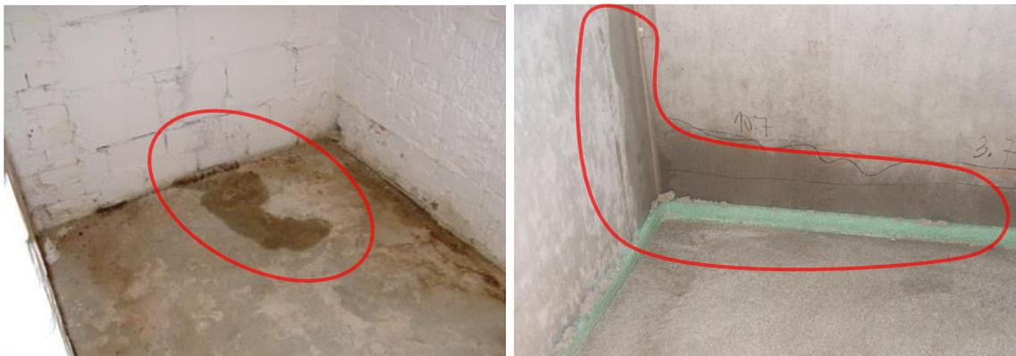
Abb. 64 Linkes Bild: Eindringen von Feuchtigkeit durch Bodenplatte<sup>27</sup>; Rechtes Bild: Feuchte Wände im Untergeschoss<sup>28</sup>
