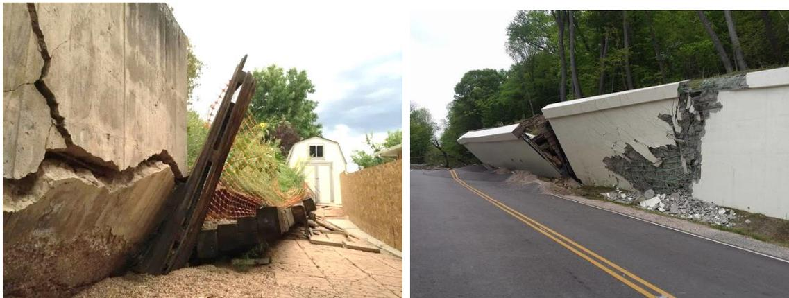
Abb. 113 Linkes Bild: Bruch einer Stützmauer zufolge einer Hangdeformation<sup>67</sup>; Rechtes Bild: Versagen einer Stützmauer mit starken Verformungen der Fahrbahn<sup>68</sup>
