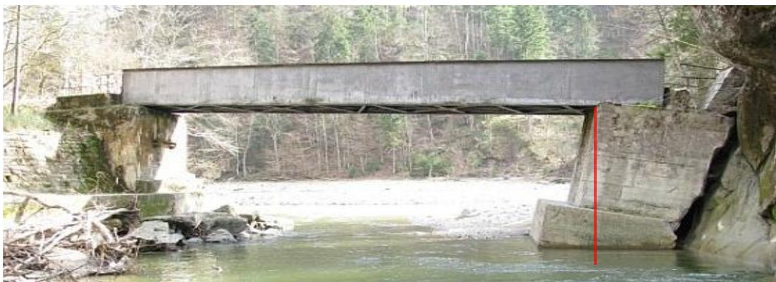
Abb. 172 Schiefstellung eines unterspülten Widerlagers aufgrund von Hochwässern<sup>105</sup>
