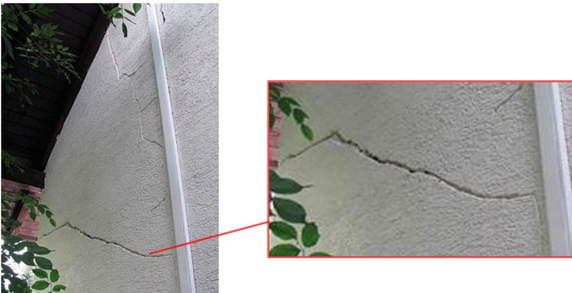
Abb. 51 Linkes Bild: Rissverlauf in Giebelwand aufgrund von Setzungsschäden; Rechtes Bild: Detailansicht des Risschadens (Dialer, 2016)
