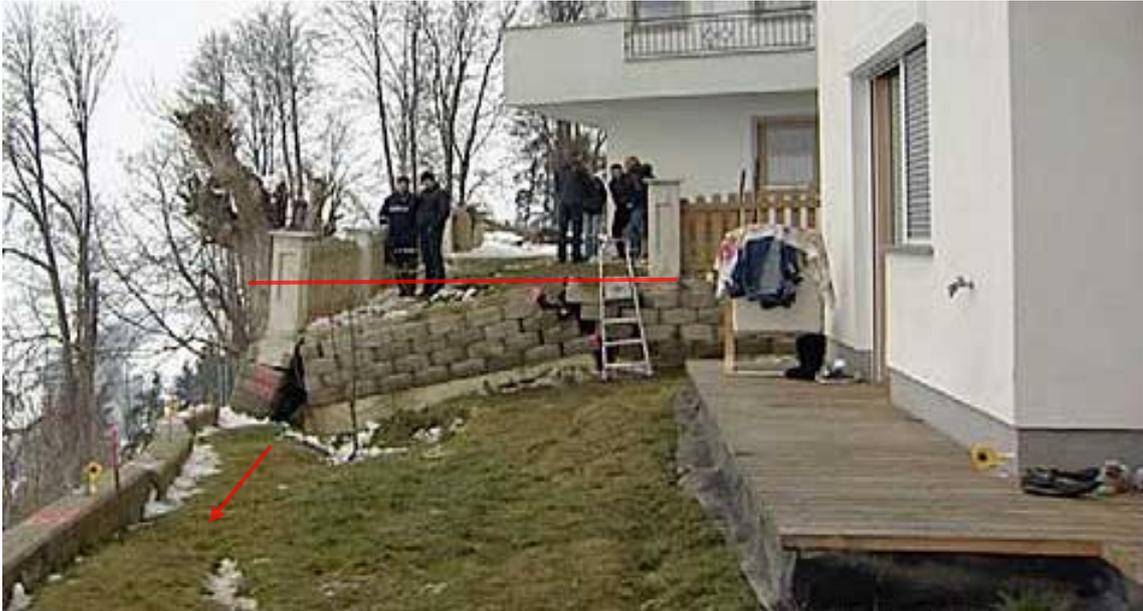
Abb. 24 Verformungen einer Mauer infolge einer Hangverformung<sup>10</sup>
