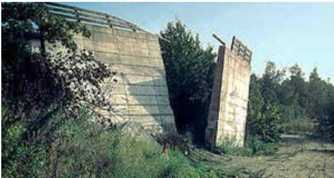
Abb. 168 Rutschversagen einer Winkelstützmauer (Hilmer, 2006)
