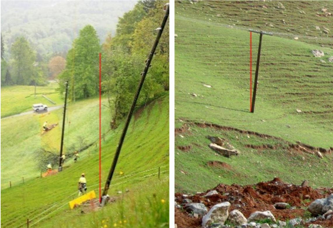
Abb. 179 Verdrehung von Strommasten<sup>110</sup>
