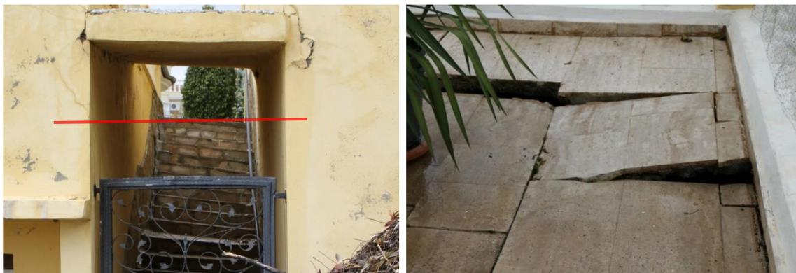
Abb. 32 Linkes Bild: Verformungsschäden bei einem Stiegdurchgang; Rechtes Bild: Terrassenschäden (tuerkei-zeitung.de, 2017)
