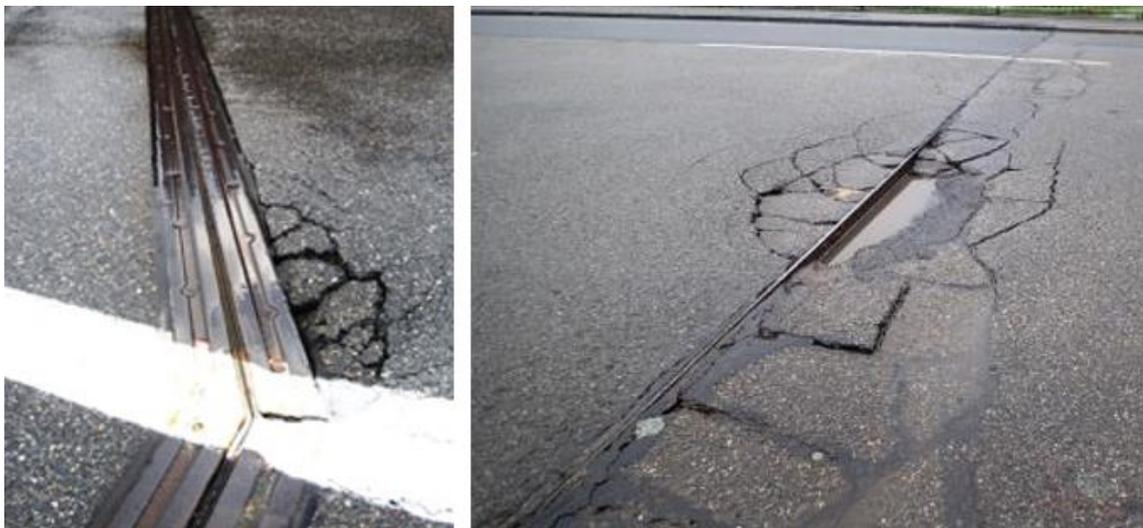
Abb. 200 Asphaltbrüche bzw. -risse an einer Fahrbahnübergangskonstruktion<sup>122123</sup>
