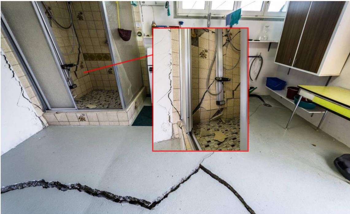
Abb. 43 Schwere Setzungsrissschäden im Untergeschoss eines Wohnhauses, Bild Mitte: Detail der Verformungen und Abplatzungen in der Duschkabine (Aargauer Zeitung, 2015)
