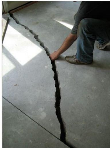
Abb. 57 Riss in einer Bodenplatte aufgrund von Setzungen<sup>20</sup>
