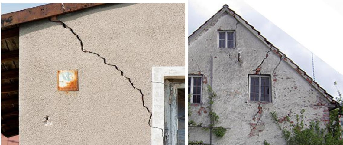
Abb. 49 Linkes Bild: Diagonales Rissbild mit großer Rissbreite an einer Giebelwand<sup>18</sup>; Rechtes Bild: Setzungsrisse an Giebelwand mit Abplatzungen (Dialer, 2016)
