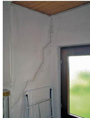
Abb. 59 Linkes Bild: Schwere Risschäden in einem Treppenhaus<sup>21</sup>; Rechtes Bild: Diagonaler Riss ausgehend von der Bauwerksecke (Dialer, 2016)
