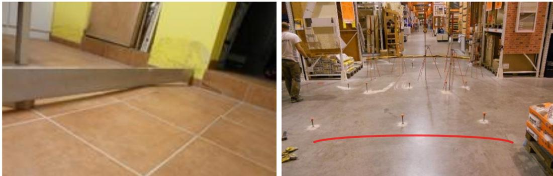
Abb. 61 Linkes Bild: Verformung eines Fließbodens<sup>23</sup>; Rechtes Bild: Anhebung einer Verkaufsfläche<sup>24</sup>
