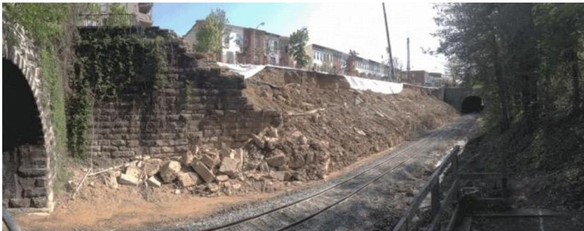
Abb. 166 Blick von der Zugtrasse aus, Stützmauerversagen in Baltimore<sup>103</sup>
