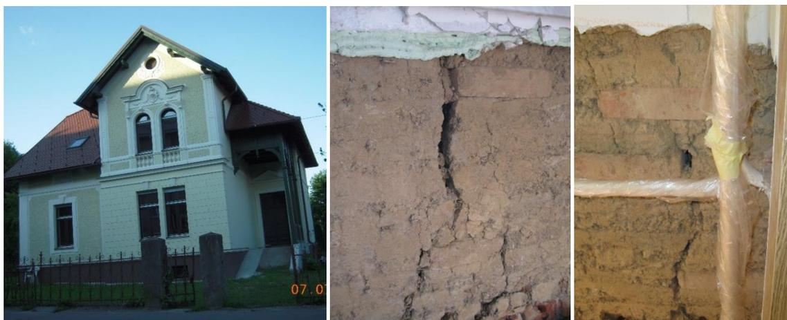
Abb. 62 Linkes Bild: Von Setzungsschäden betroffenes Objekt, Bild in der Mitte und rechts: Darstellung der Setzungsriss im Mauerwerk am freigestellten Untergeschoss<sup>25</sup>
