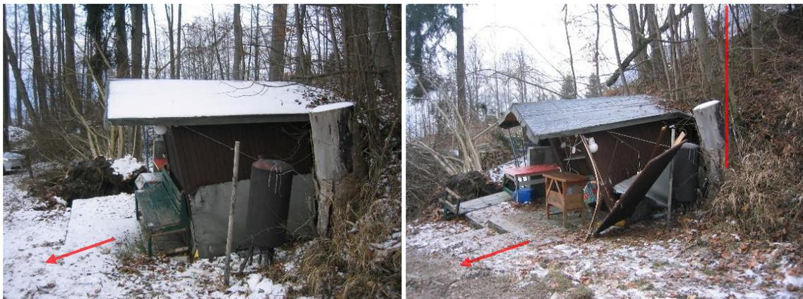
Abb. 36 Deutlich sichtbare Verformungen an Holzhütten im Einflussbereich der Rutschung (Gschlifgraben, 2008)
