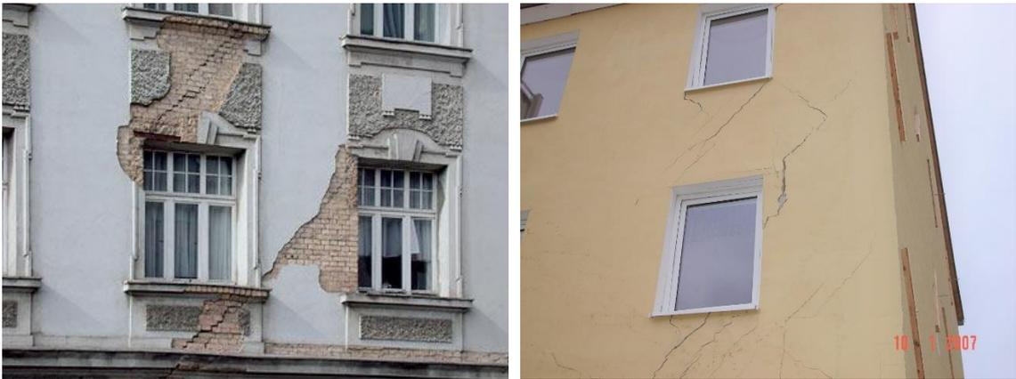
Abb. 46 Linkes Bild: Diagonaler Setzungsriß an Verwaltungsgebäude (Meichsner & Rohr-Suchalla, 2011); Rechtes Bild: Setzungsrisse mit großer Rissbreite und Verformungen an den Fensteröffnungen<sup>17</sup>
