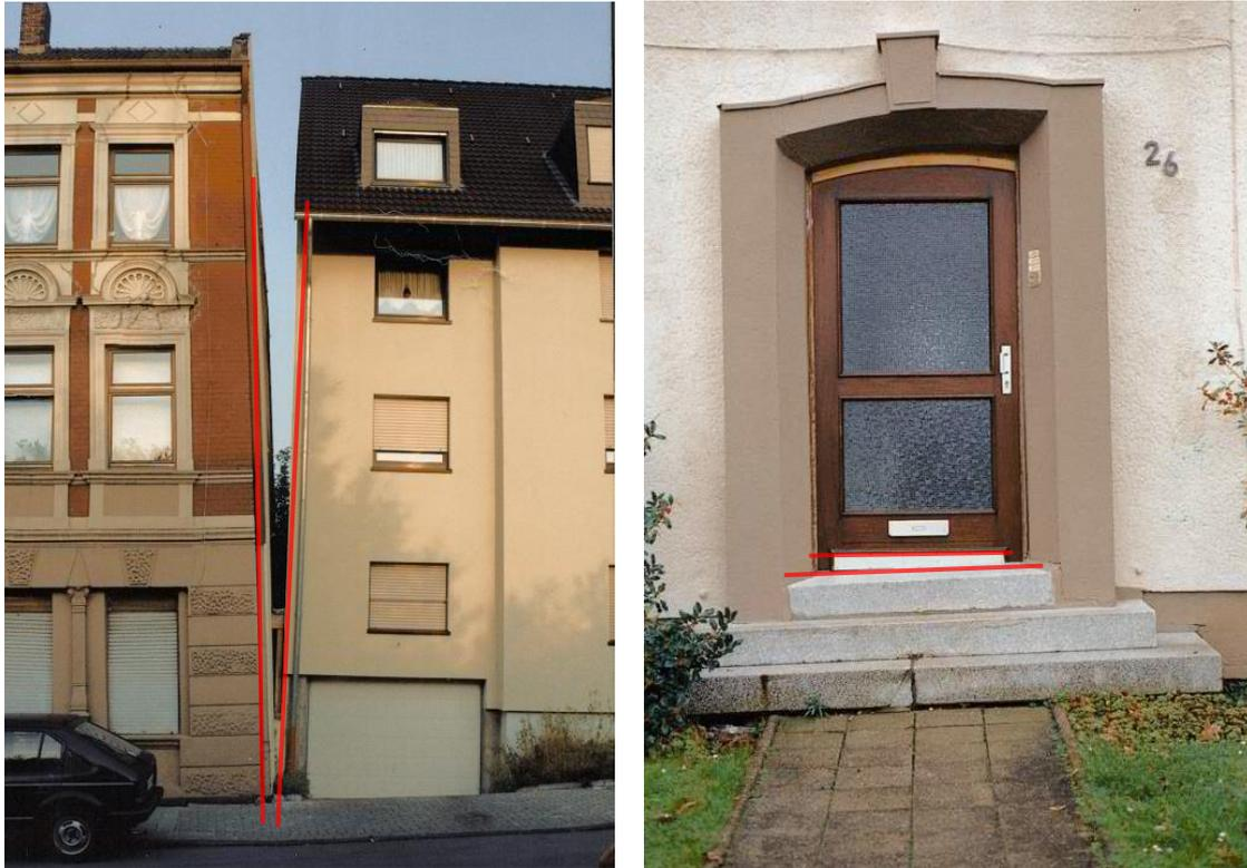
Abb. 72 Linkes Bild: Starke Schiefstellung eines Gebäudes mit Einschränkung der Gebrauchstauglichkeit; Rechtes Bild: Durch die starke Schiefelage schliften die Türen am Boden bzw. konnten nicht mehr richtig verschlossen werden (VBHG, 2016)
