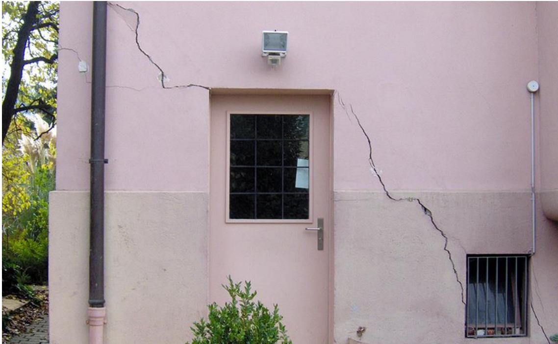
Abb. 177 Risschäden mit großer Rissbreite an einem Gebäude<sup>108</sup>
