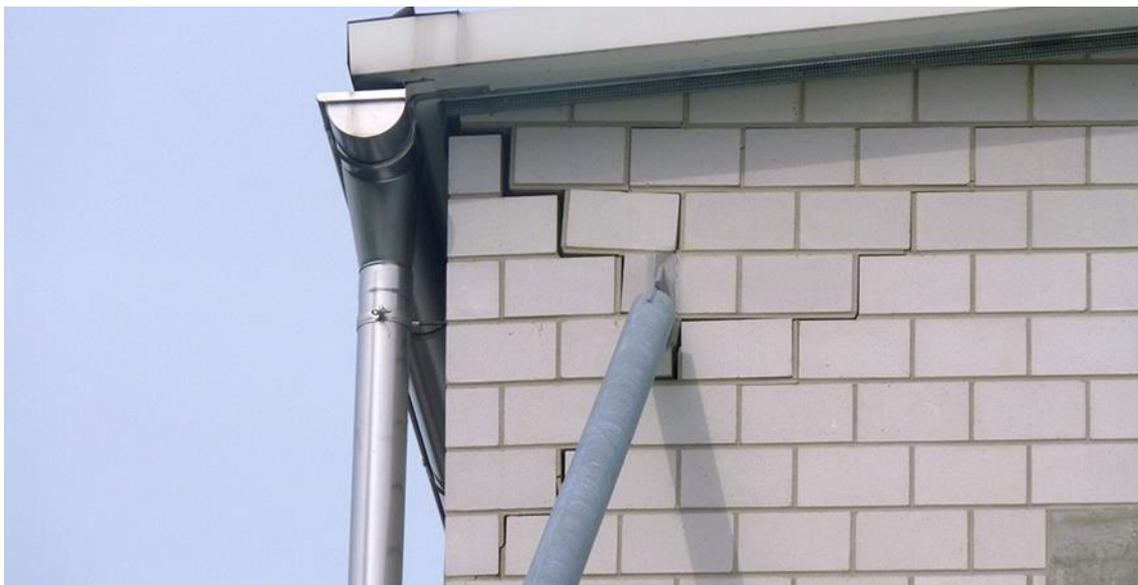
Abb. 178 Risschäden im Mauerwerk infolge von Verformungen<sup>109</sup>
