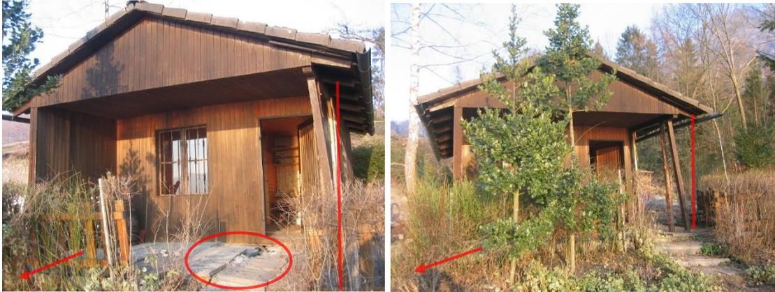
Abb. 37 Linkes Bild: Verwerfungen von Bodenplatten und Verformungen an einer Hütte;
