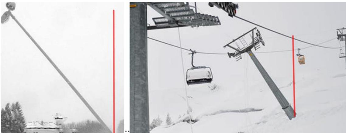
Abb. 206 Linkes Bild: Verdrehter Lichtmast<sup>126</sup>; Rechtes Bild: Neigungsänderung einer einzelnen Liftstütze<sup>127</sup>
