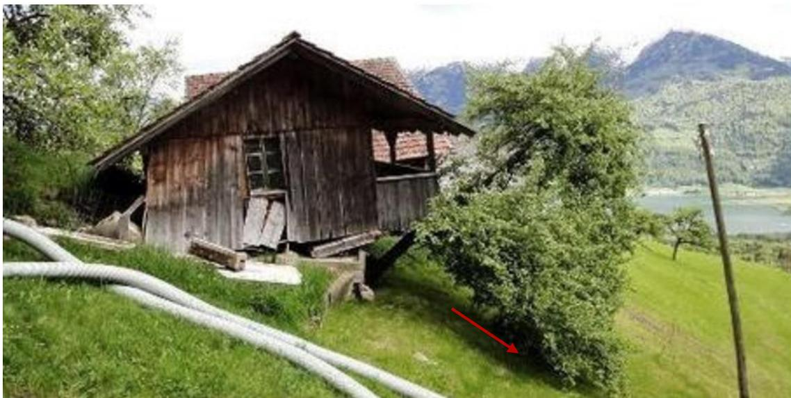
Abb. 34 Bauwerkversagen in einer großen Massenbewegung<sup>13</sup>
