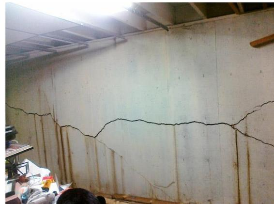
Abb. 75 Linkes Bild: Verformungen und Biegerisse an Mauerwerkswand<sup>37</sup>; Rechtes Bild: Risse in Betonwand<sup>38</sup>
