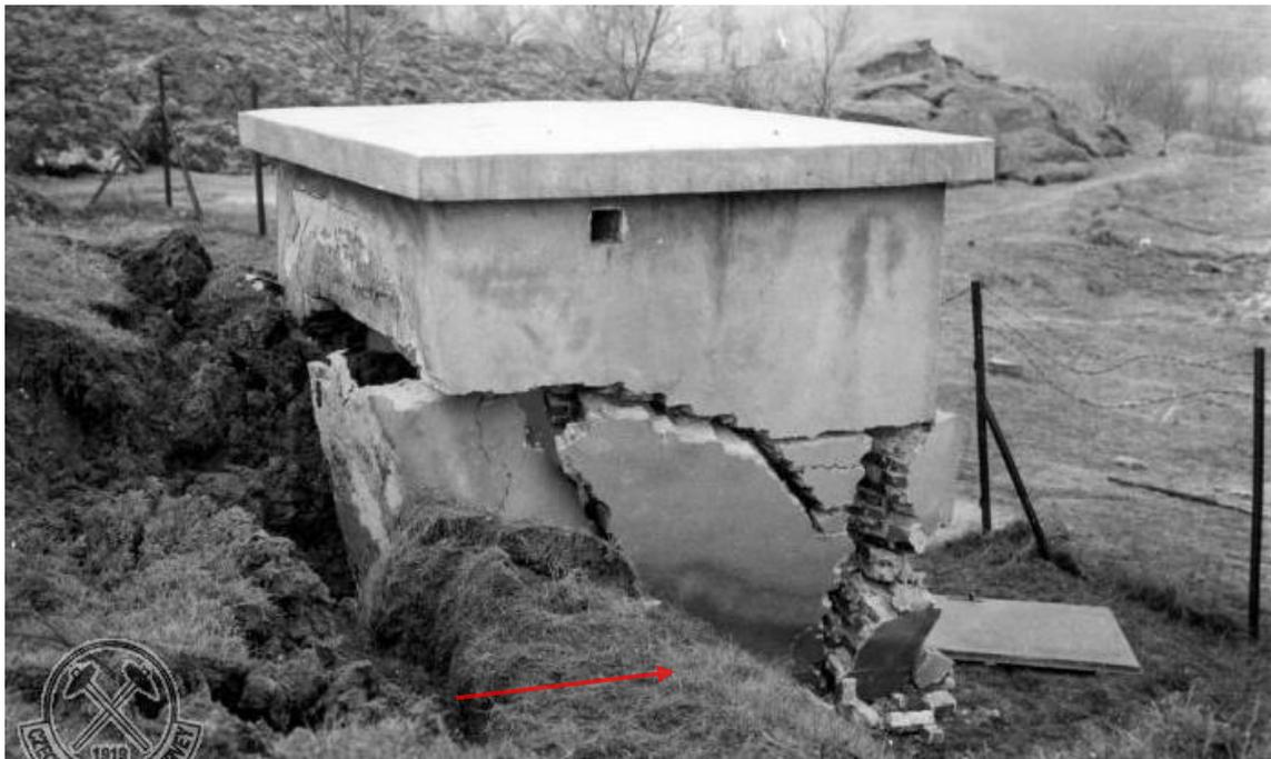
Abb. 40 Geschädigtes Bauwerk nach einer Rutschung im Bereich der Rutschstirn (fotoarchiv.geology.cz, 2017)
