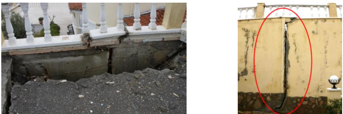
Abb. 33 Linkes Bild: Absacken einer 6 m hohen Mauer, Blick von der Stützmauer Richtung Tal; Rechtes Bild: Blick unterhalb der Stützmauer (tuerkei-zeitung.de, 2017)
