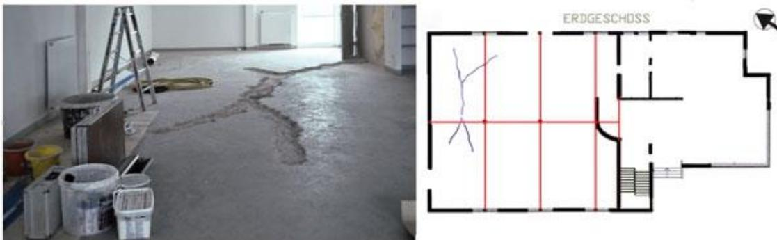
Abb. 56 Biegeriss in einer Bodenplatte im Inneren (Meichsner, 2015)
