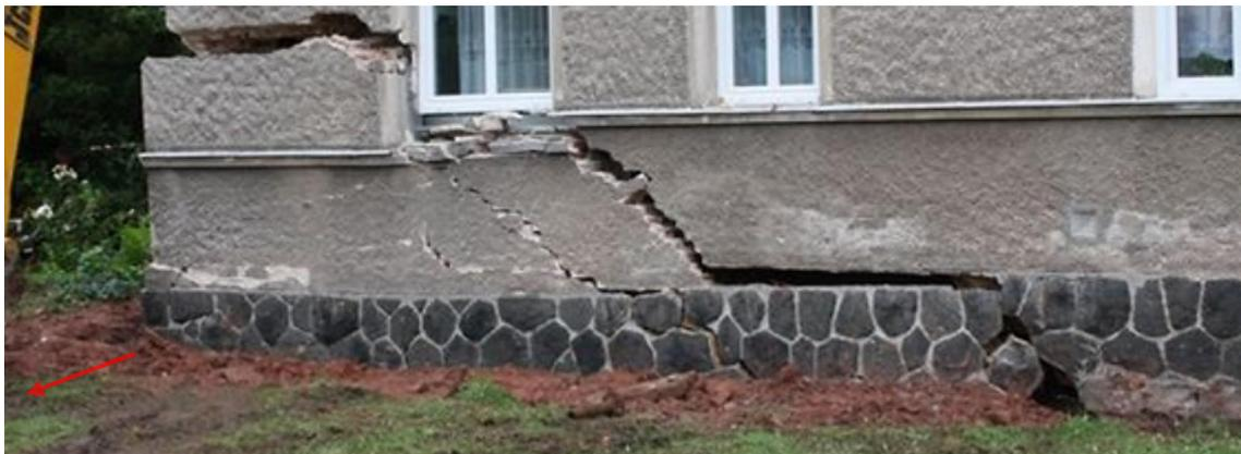
Abb. 23 Stark beschädigtes Gebäude zufolge einer Hangdeformation<sup>9</sup>
