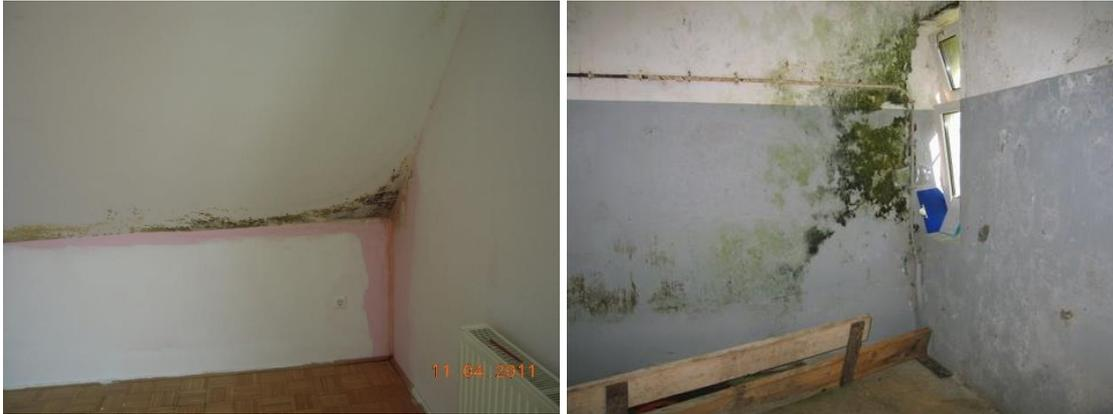
Abb. 65 Linkes Bild: Schimmelbefall aufgrund von Wassereintritt im Dachgeschoss<sup>29</sup>; Rechtes Bild: Feuchtigkeitseintritt und Schimmelbefall aufgrund von Setzungsschäden<sup>30</sup>
