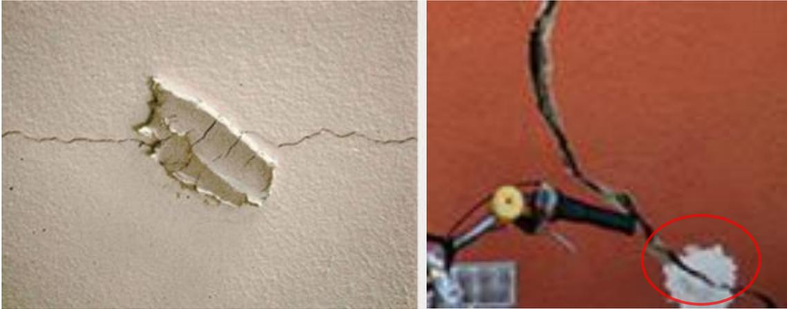
Abb. 123 Linkes Bild: Gipsmarker bei kleiner Rissbewegung; Rechtes Bild: Abplatzen eines Gipsmarkers aufgrund einer großen Rissbewegung (Dialer, 2016)
