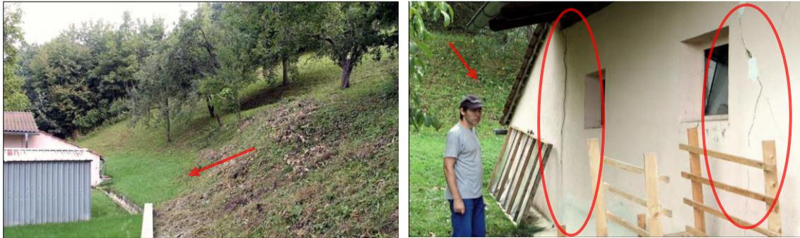
Abb. 39 Linkes Bild: Fußbereich eines Kriechhanges; Rechtes Bild: Risschäden am Gebäude unterhalb des Kriechhanges (Leopold, 2012)
