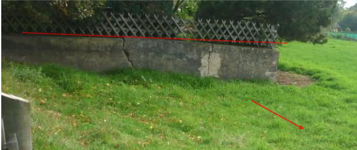
Abb. 69 Setzungsrisse mit sichtbarem Abfallen einer langen Wandkonstruktion (VBHG, 2016)
