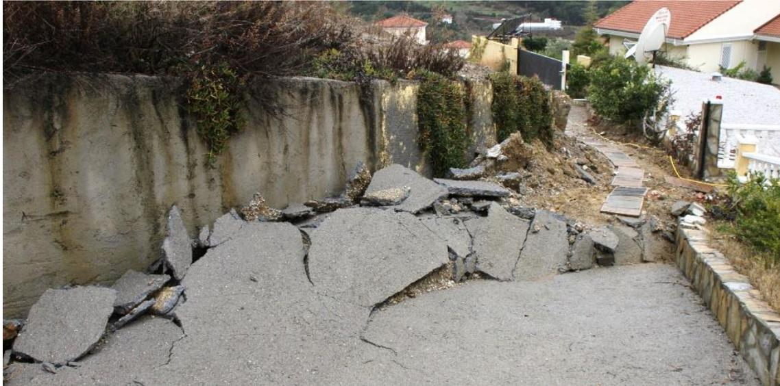
Abb. 112 Gleiten einer Stützmauer mit starken Verwerfungen im Asphalt (tuerkei-zeitung.de, 2017)
