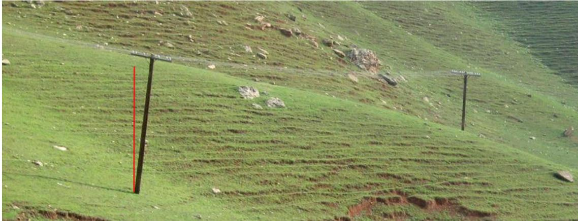
Abb. 192 Verdrehungen des Strommasten, sowie Bodenunebenheiten und erste Anrisskanten erkennbar <sup>118</sup>
