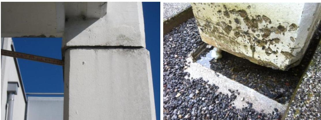
Abb. 66 Linkes Bild: Versatz einer Säule<sup>31</sup>; Rechtes Bild: Entkopplung einer Balkonsäule aufgrund von Kriechbewegungen<sup>32</sup>
