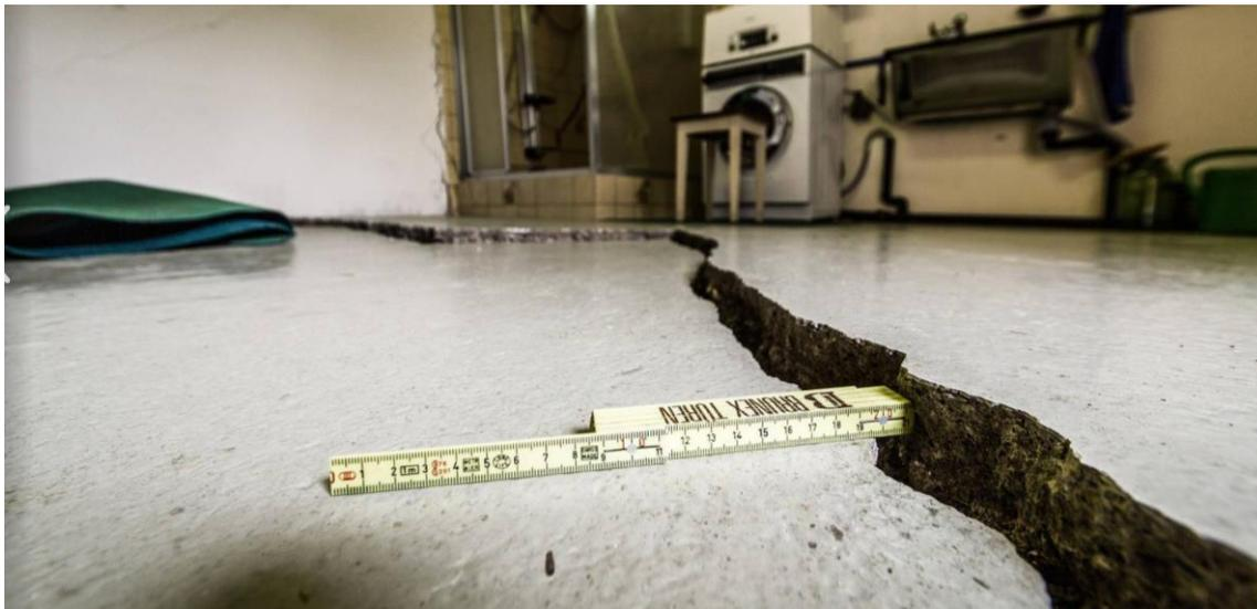
Abb. 42 Ein mehrere Zentimeter großer Bruch einer Bodenplatte mit Höhenversatz aufgrund einer Hangdeformation (Aargauer Zeitung, 2015)
