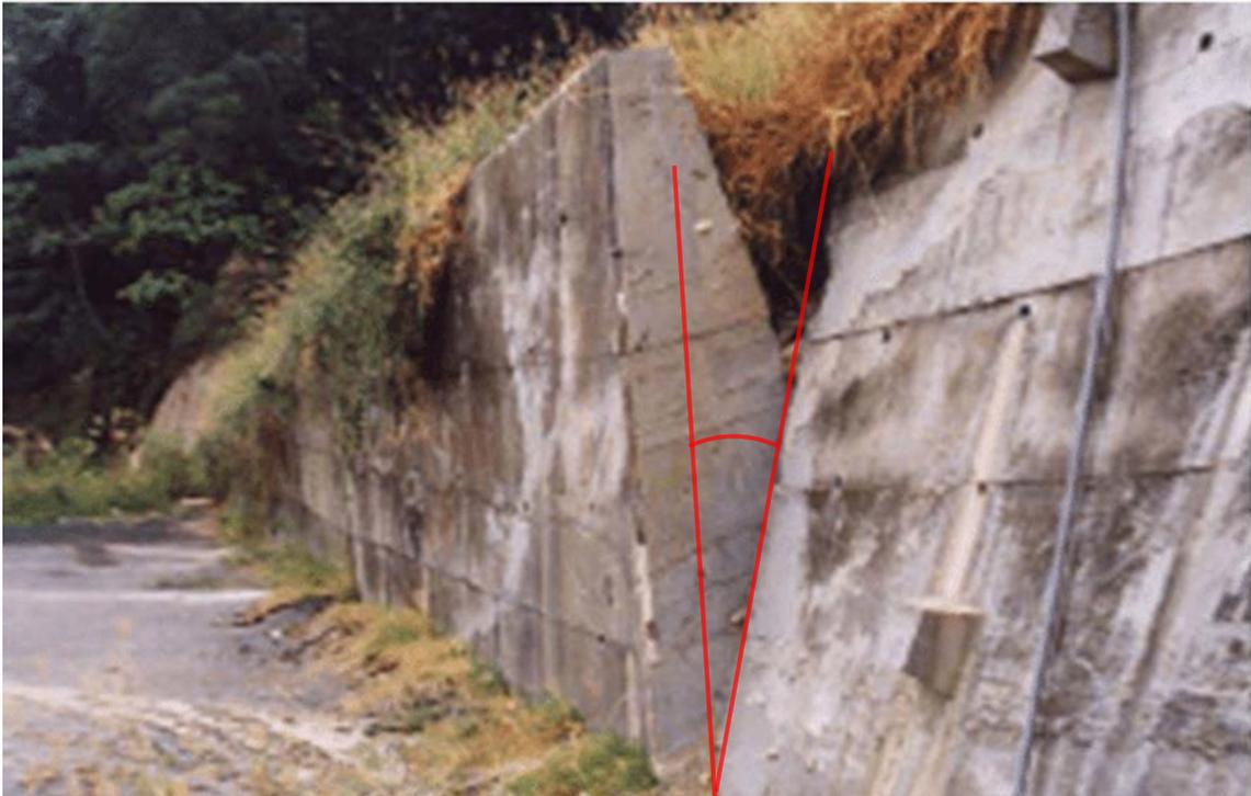
Abb. 183 Neigungsänderung einzelner Stützmauerblöcke<sup>112</sup>
