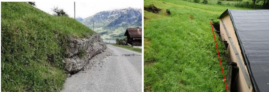
Abb. 108 Linkes Bild: Komplettversagen eines Stützbauwerkes aufgrund einer Massenbewegung<sup>62</sup>; Rechtes Bild: Verformung einer Holzstützwand zufolge einer Kriechbewegung<sup>63</sup>
