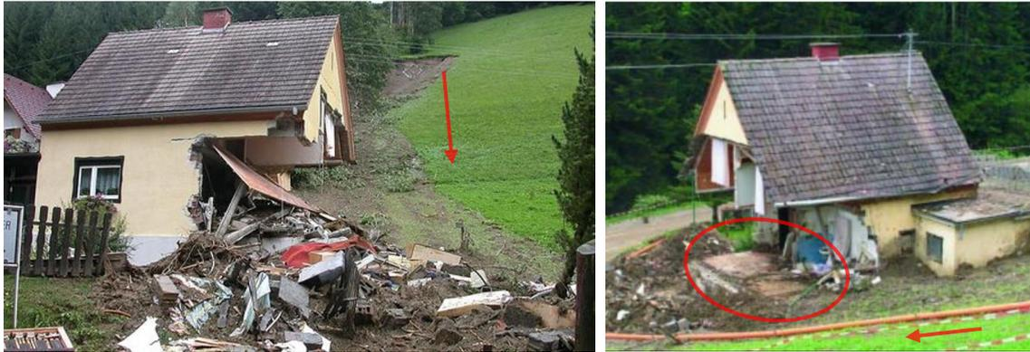
Abb. 41 Linkes Bild: Schwere Schäden an einem Gebäude nach einer Hangrutschung<sup>14</sup>; Rechtes Bild: Geschädigtes Objekt nach den Räumungsarbeiten, die Unterkonstruktion blieb stehen (roter Kreis)<sup>15</sup>
