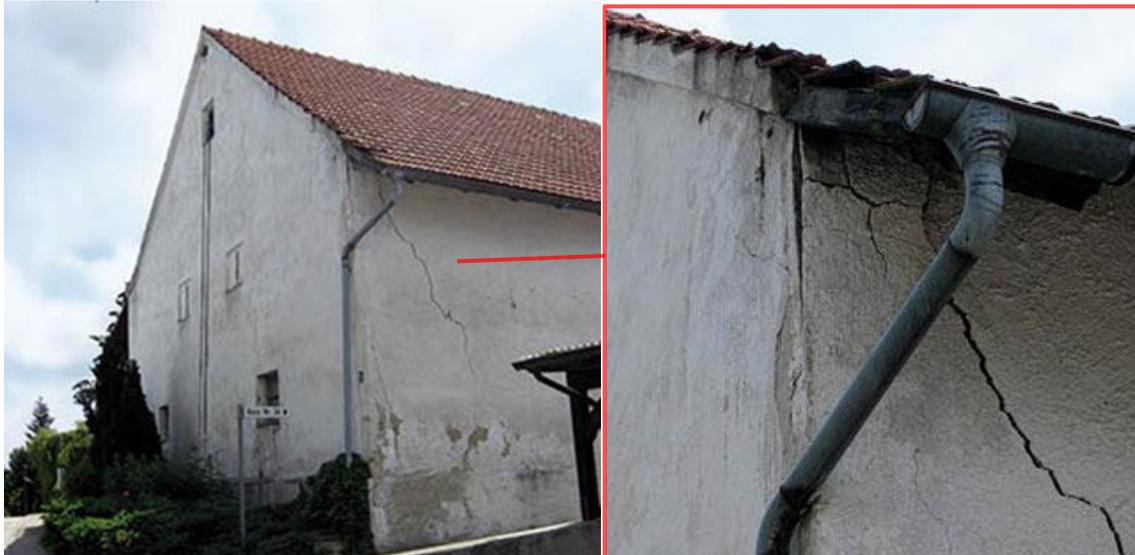
Abb. 48 Linkes Bild: Riss zufolge einer sich ablösenden Giebelwand; Rechtes Bild: Detailaufnahme des Risses (Dialer, 2016)
