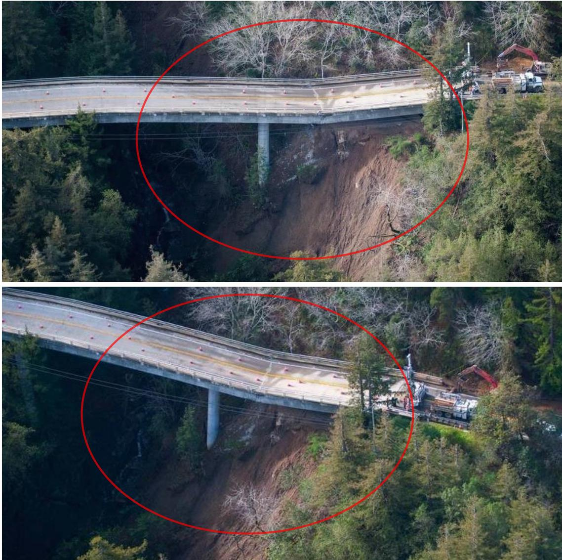
Abb. 173 Versagen einer Brückenkonstruktion durch Ausfall eines Pfeilers<sup>106</sup>
