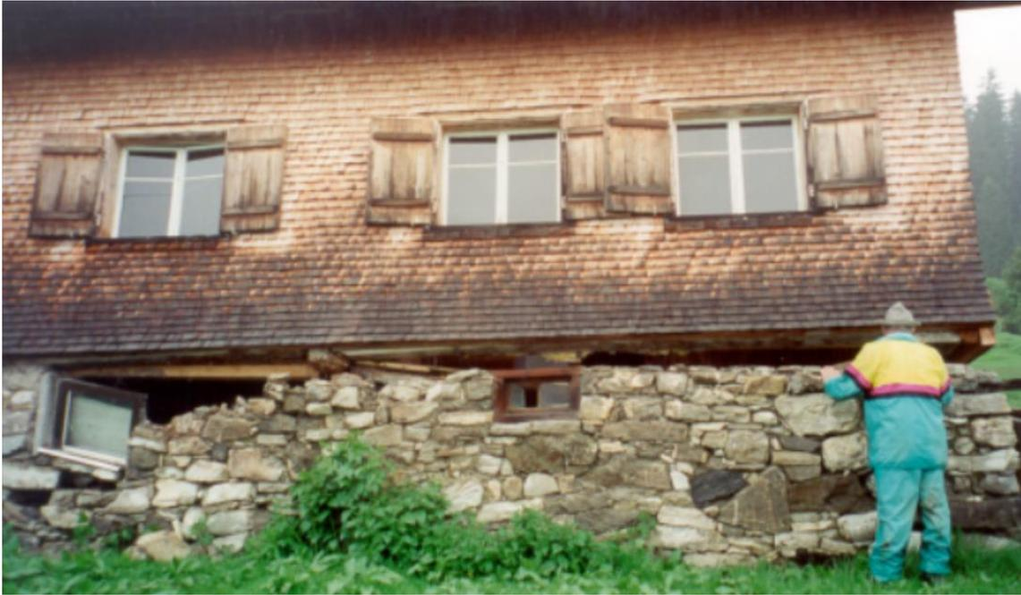
Abb. 35 Schwere Schäden an Unterkonstruktion einer Alp-Hütte infolge einer Großhangbewegung (Jaritz, 2001)
