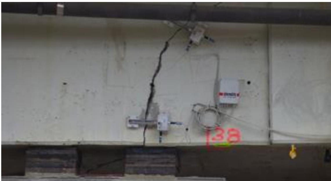
Abb. 128 Rissdokumentation einer aufgrund von Setzungen geschädigten Brücke mittels digitaler Rissbreitenmessung<sup>75</sup>
