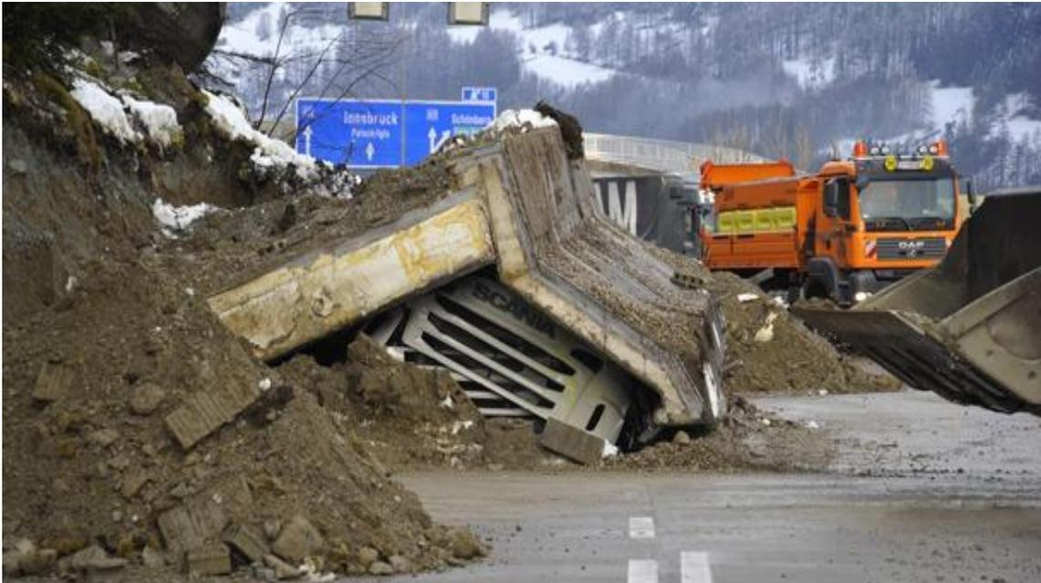
Abb. 114 Wandbruch einer Winkelstützmauer nach einer Schmelzphase mit starken Niederschlägen<sup>69</sup>
