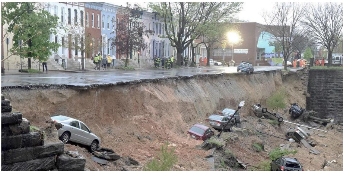
Abb. 165 Nach dem Einsturz, Stützmauerversagen in Baltimore<sup>102</sup>
