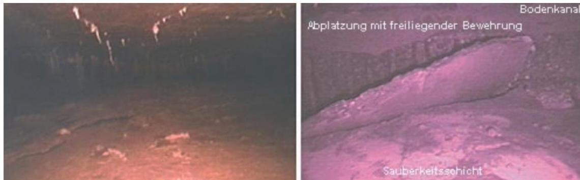
Abb. 160 Untersuchung der Bodenplatte via Videoendoskopie (Ruckenbrod & Schlüter, 2005)
