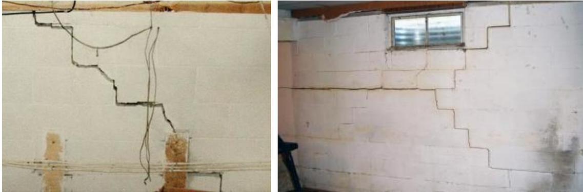
Abb. 76 Risse in Mauerwerkswänden aufgrund von Durchbiegung<sup>39</sup>
