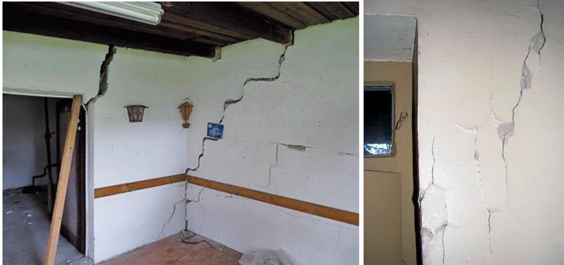
Abb. 163 Linkes Bild: Großer Risschaden an einem Türsturz; Rechtes Bild: Risse mit geringer Rissbreite an Innenwand (Dialer, 2016)
