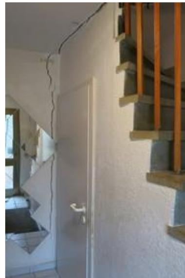
Abb. 60 Linkes Bild: Feiner Rissverlauf mit vertikalem Verlauf (Dialer, 2016); Bild in der Mitte und rechtes Bild: vertikale Setzungsrisse in Wänden welche in die Decke übergehen<sup>22</sup>
