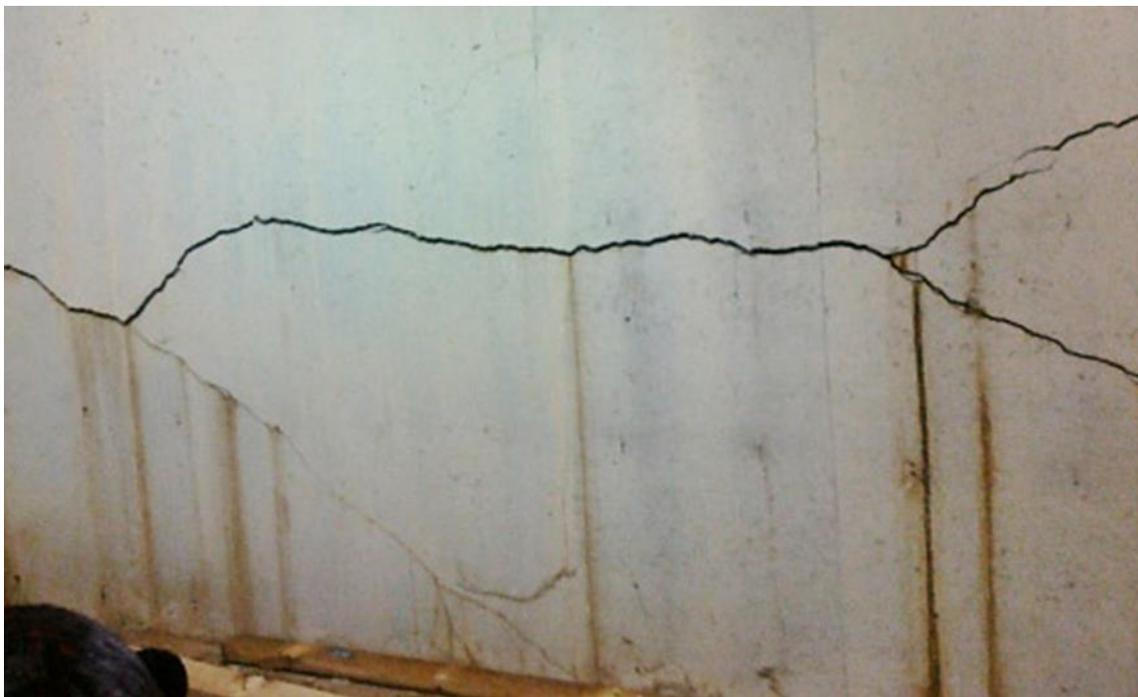
Abb. 208 Risse am Parkhaus ausgelöst durch den erhöhten Kriechdruck, der auf das Gebäude einwirkt <sup>128</sup>
