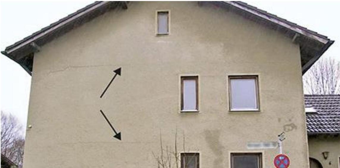
Abb. 50 Giebelwand mit horizontalem Setzungsrissverlauf (Dialer, 2016)
