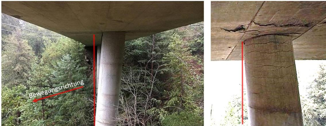
Abb. 195 Linkes Bild: Verschiebung eines Brückenpfeilers; Rechtes Bild: Risschäden im Stützbereich<sup>119</sup>
