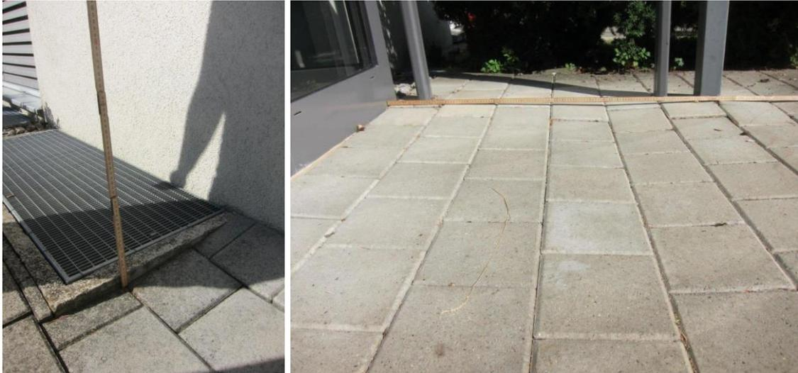
Abb. 67 Verformungen angrenzender Pflastersteinen an ein Gebäude, ausgelöst durch Hangbewegungen<sup>3334</sup>
