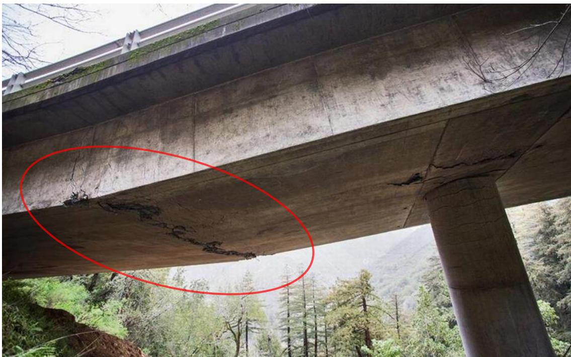
Abb. 196 Biegerisse am Tragwerk aufgrund des Ausfalls der Stützwirkung<sup>120</sup>
