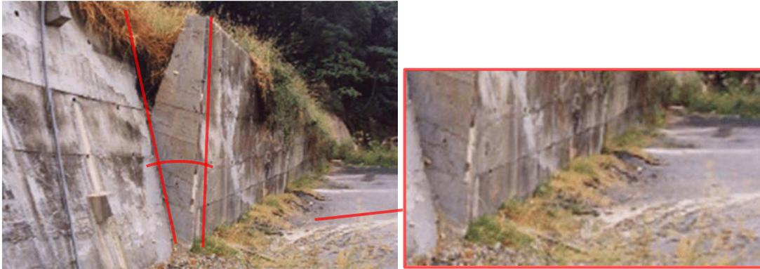
Abb. 109 Linkes Bild: Kippende Stützmauer unter einem Kriechhang; Rechtes Bild: Starke Verwerfungen im Asphalt<sup>64</sup>
