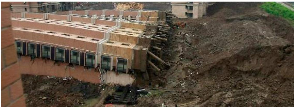
Abb. 77 Kippen eines 13. stöckigen Hochhauses aufgrund Versagen einer Pfahlgründung<sup>40</sup>
