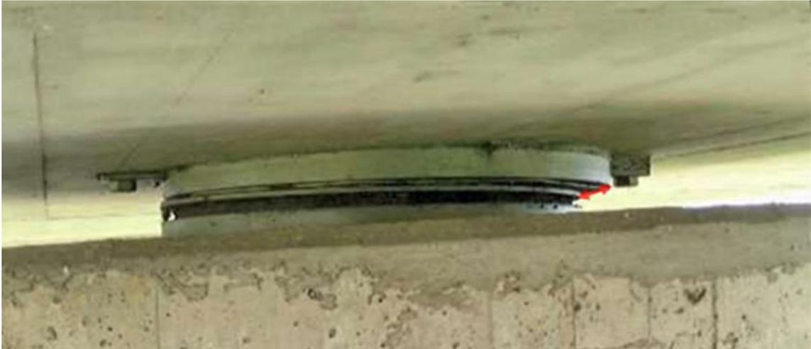
Abb. 197 Auflagerverschiebungen an den Stützen der Brücke zufolge möglicher Kriechbewegungen<sup>121</sup>
