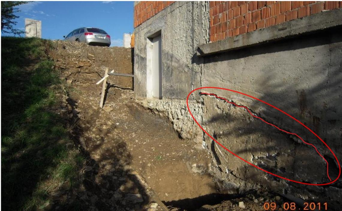
Abb. 63 Setzungsrisse an einer Untergeschosswand eines in Hanglage stehenden Hauses mit Folgeschäden durch Wassereintritt<sup>26</sup>
