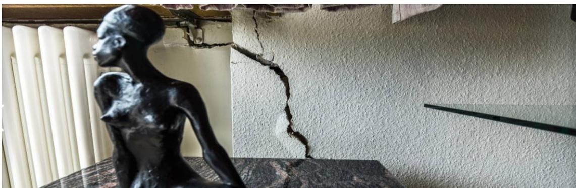
Abb. 44 Setzungsrissschaden im Innenbereich ausgehend vom Laibungseck des Fensters (Aargauer Zeitung, 2015)
