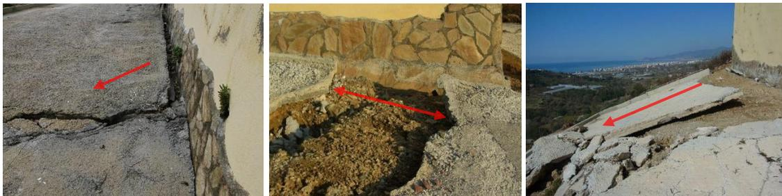
Abb. 30 Linkes Bild: Erste Risse in der Straße; Bild in der Mitte: Riss breitete sich aus; Rechtes Bild: Straße brach weg (tuerkei-zeitung.de, 2017)
