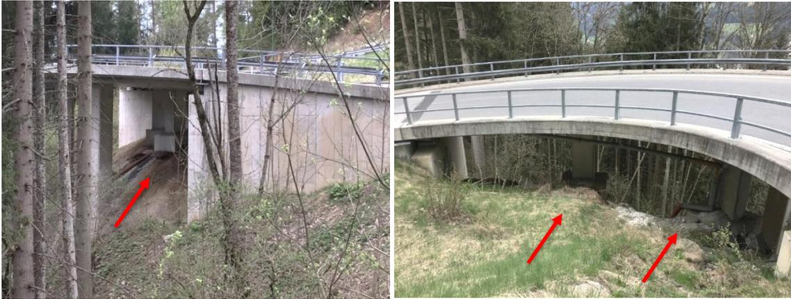
Abb. 170 Von Bodenerosion betroffene Brückenkehre, rote Pfeile zeigen die Position der Pfeiler an (Ramsauer Straße, Schladming, 2017)
