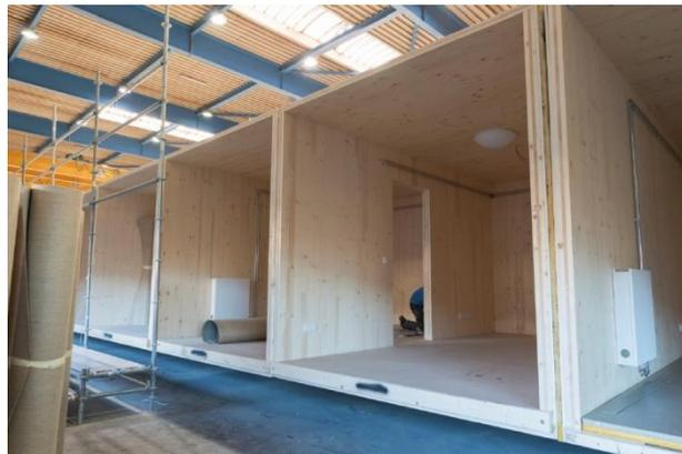
**Abbildung 2.23:** links: Punkt 2: Fixierung der Wände auf der Bodenplatte [144], rechts: Punkt 3: Die Dachplatte wurde bereits versetzt und fixiert, Kaufmann Bausysteme [144]
