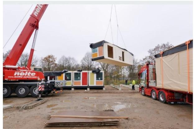
Abbildung 2.25: links: Punkt 8: Eingepackte Raumzellen werden mittels LKW zur Baustelle transportiert [144], rechts: Punkt 9: Montage der Raumzellen, Kaufmann Bausysteme [144]
