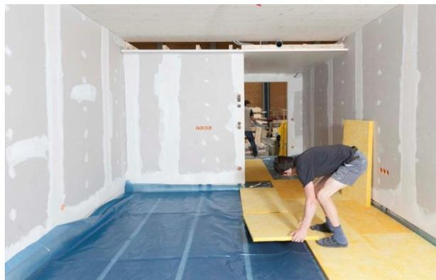
**Abbildung 2.24:** links: Punkt 5: Einbau der Fenster und Türen [144], rechts: Punkt 6: Einbau von Verkleidungen und Fußbodenaufbauten, Kaufmann Bausysteme [144]
