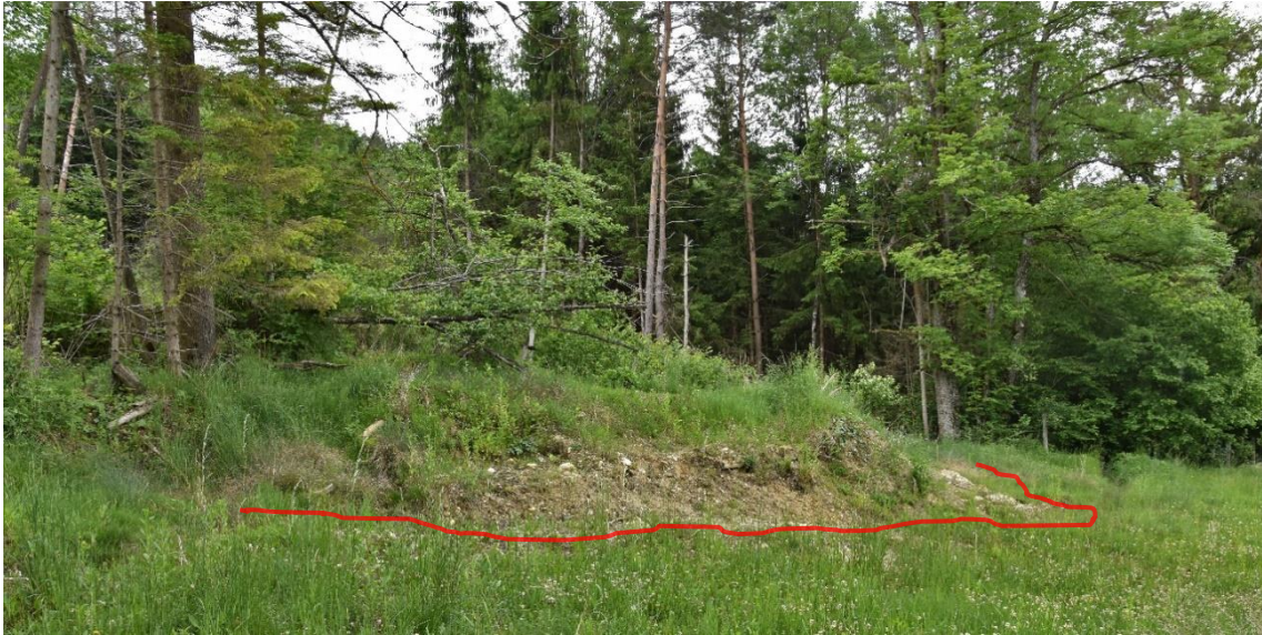
Abb. 155: Unteres Ende der Rutschung im östlichen Bereich. Die aufgeschobene Rutschzunge bildet den Übergang zur unbewegten Zone.
