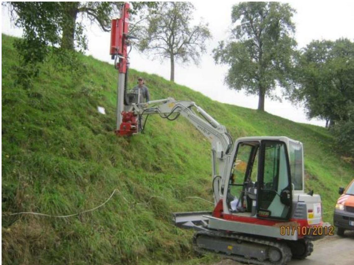
Abb. 54: Entnahme von Schürfen und Bohrungen an einem Hang mit unruhiger Oberfläche (Steinbacher, 2014)
