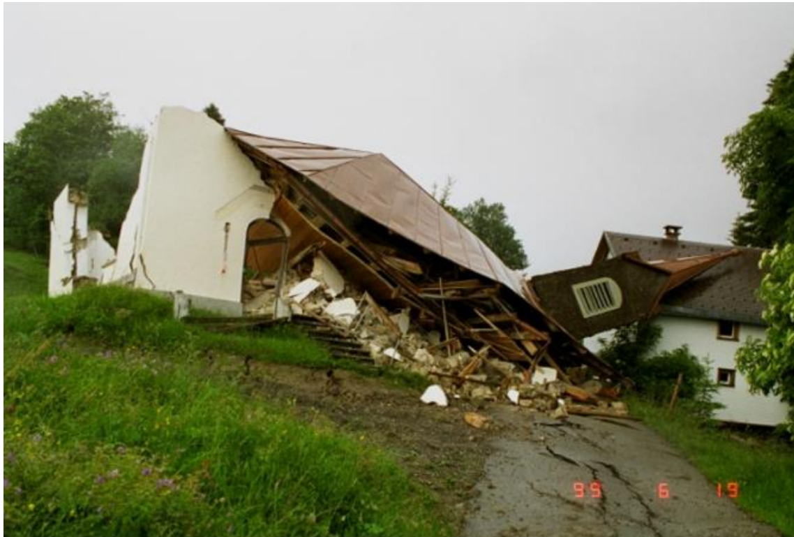
Abb. 61: Einsturz einer Kirche sowie Risse im Boden und der Straße ausgelöst durch Bewegungen im Hang (Hofmann, Jaritz, 2005)
