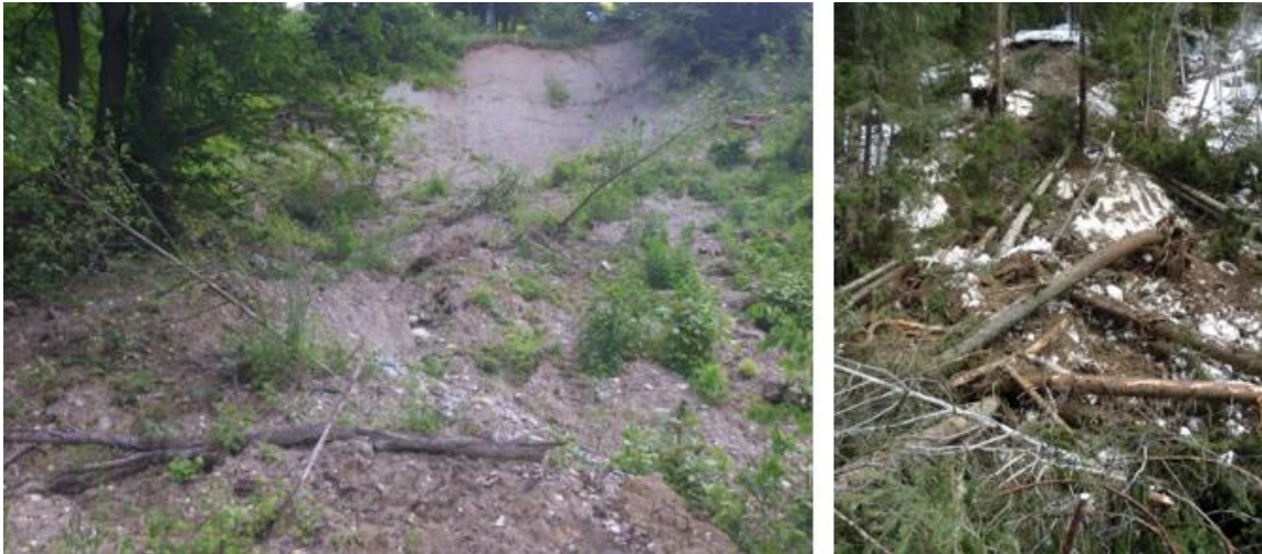
Abb. 45: Aufschiebungen und verlagertes Material im unteren Rutschungsbereich. (WLV Kärnten)
