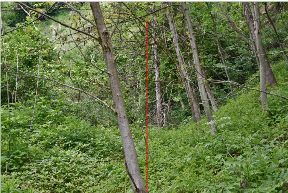
Abb. 148: Schrägstellung der Bäume durch die Verschiebungen der Bodenmasse
