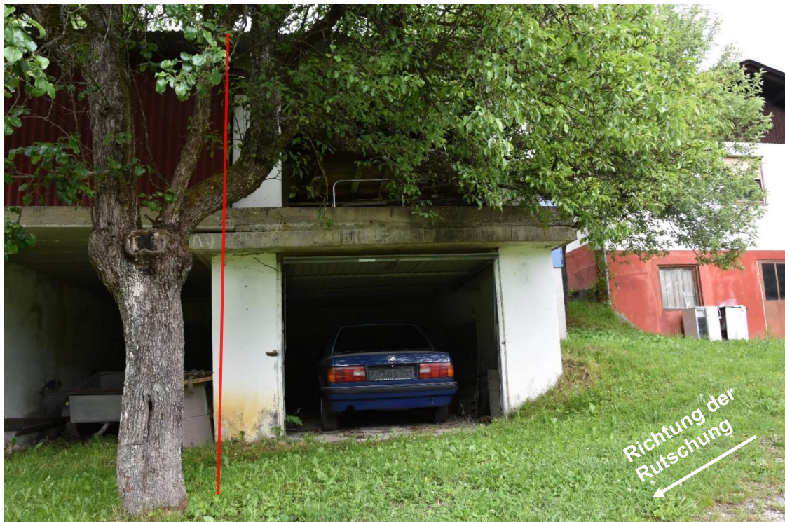
Abb. 170: Frontalansicht der Garage Blick Richtung Norden
