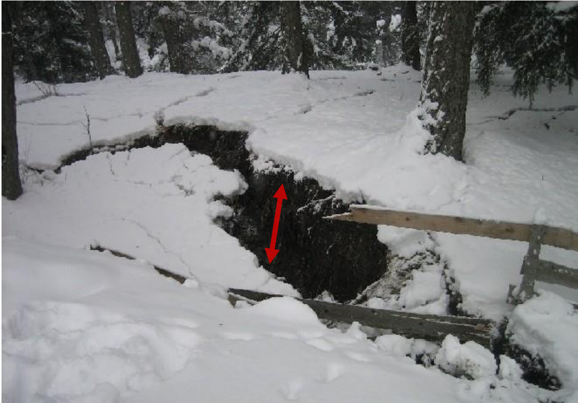
Abb. 126: Anrisskante mit erkennbarem Geländeversatz 60
