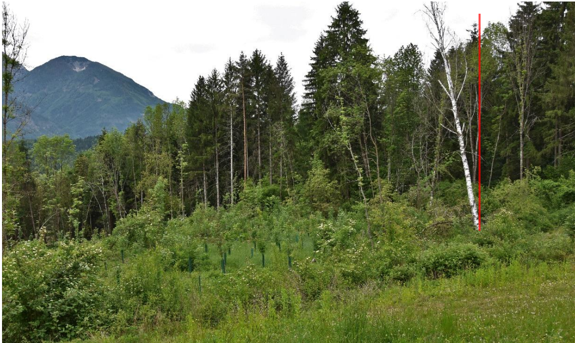
Abb. 153: Blickrichtung Süden auf den unteren Rutschungsbereich. An den schiefen Bäumen ist erkennbar, welcher Bereich von der Bewegung betroffen ist.
