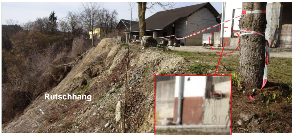
Abb. 166: Aufnahme des nördlichen Bauernhofes in der Nähe des Hanges nach der Rutschung im Jahr 2014 (WLV Kärnten, 2014)
