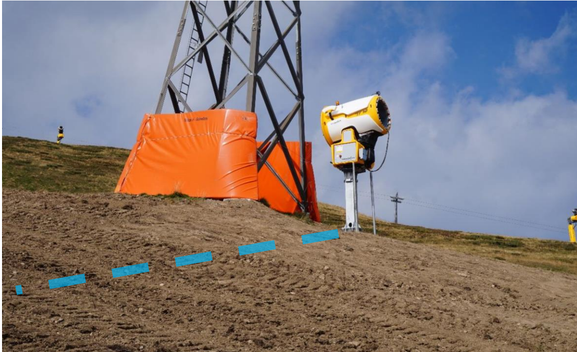
Abb. 133: Wasserleitung (in blau eingezeichnet) zur Versorgung der Beschneiungsanlage. Durch die Kriechbewegung kommt es zur Entstehung undichter Stellen im Rohr 66
