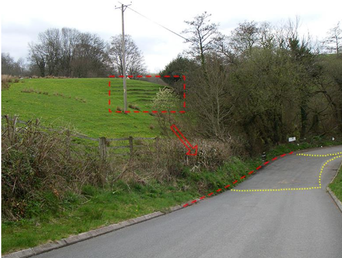
Abb. 71: Kriechhang mit unterschiedlichen Schadensbildern an Oberfläche, Zaun und Straße 33
