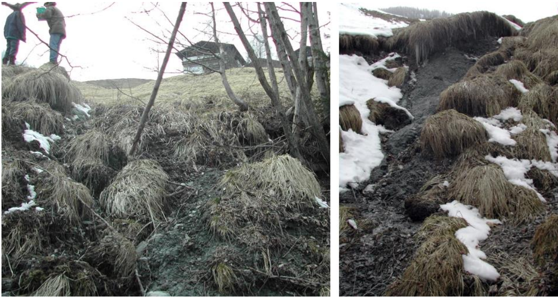
Abb. 44: Rutschung Letten-Obergail: Bucklige Aufschiebungen mit Wasseraustritt im Fußbereich. (WLV Kärnten)
