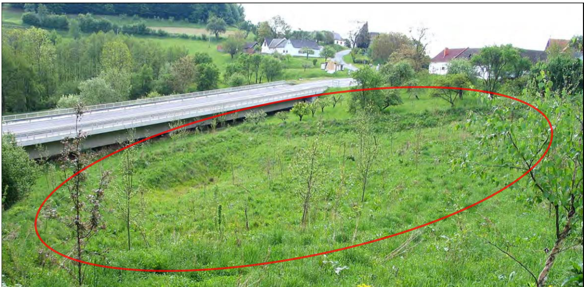
Abb. 120: Unebene Hangmorphologie verursacht durch mögliche Kriechbewegungen im Untergrund (Leopold, 2012)
