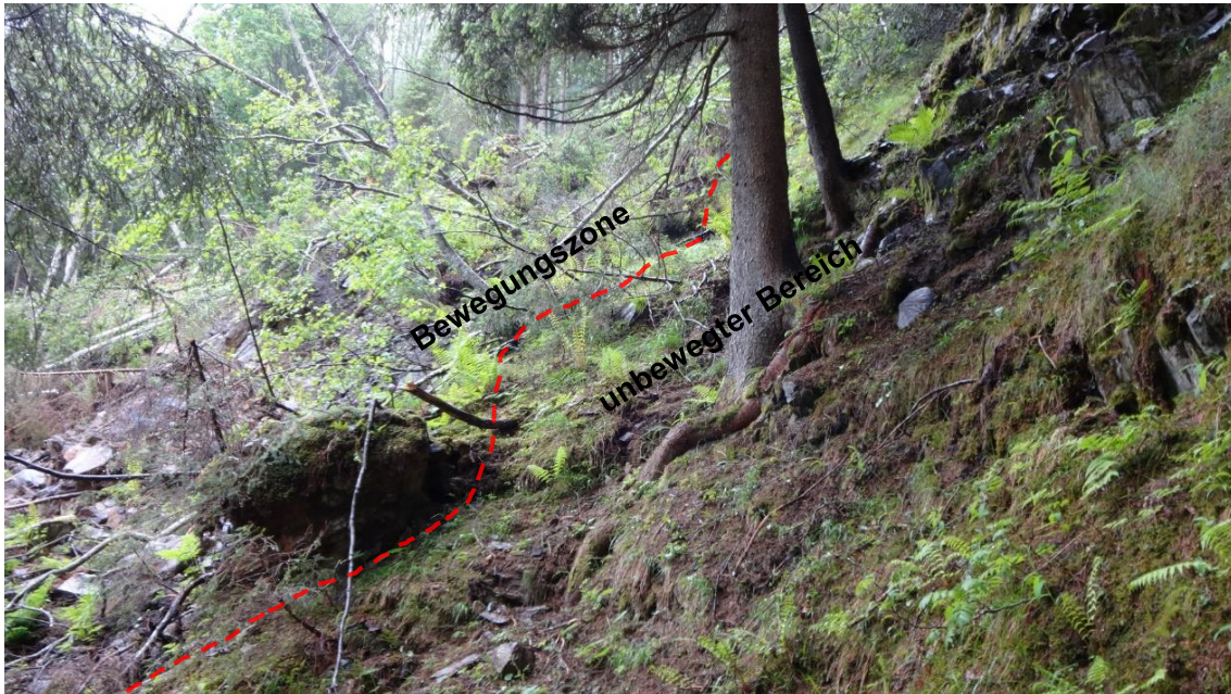
Abb. 35: Rutschung Radegundergraben: Das Foto zeigt einen Blick von oben auf den abgerutschten Bereich. Durch die bestehenden und umgekippten Bäume wird der Verlauf der Anrisskante verdeutlicht. (WLV Kärnten)
