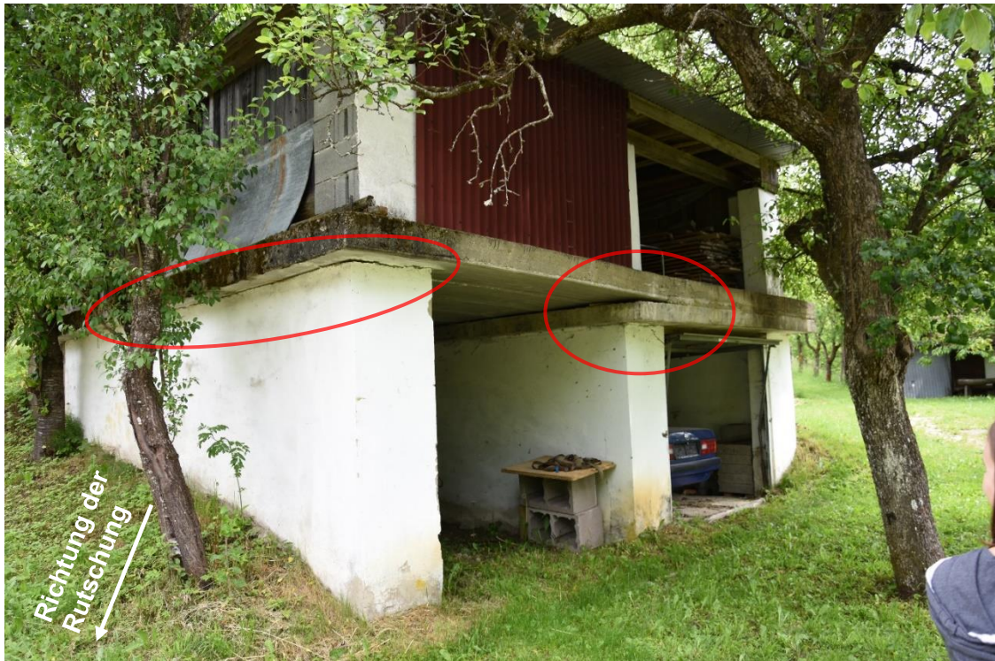
Abb. 169: Zweigeschossige Garage südlich vom Rutschhang; Blick Richtung Nordosten
