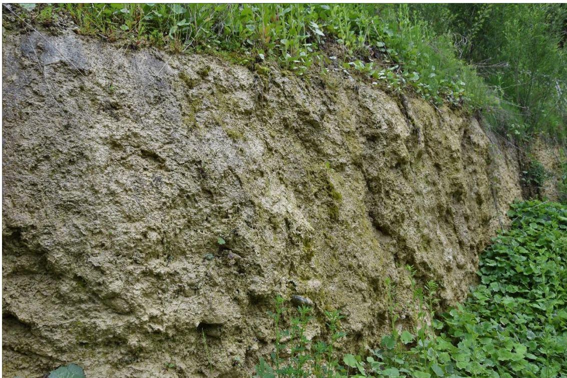
Abb. 145: Geringe Wasseraustritte aus der Neogenschicht erkennbar
