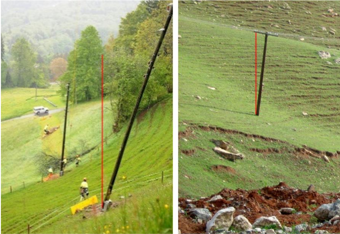
Abb. 101: Verdrehung von Strommasten 47
