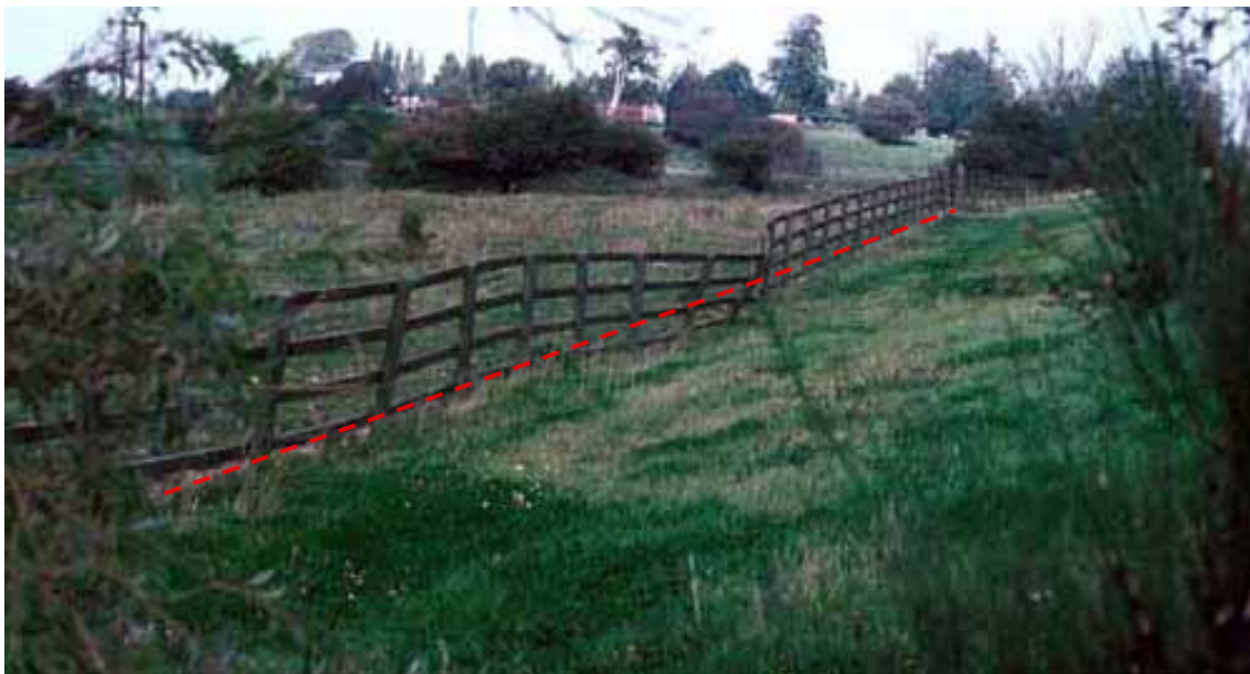
Abb. 69: Verschobene Zaunelemente verursacht durch Hangkriechen 31
