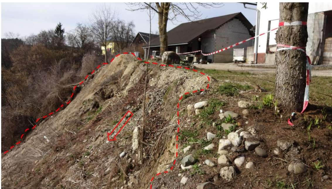
Abb. 40: Rutschung Pogerschitzen: Krone der Rutschung mit Blick von der seitlichen Flanke (WLV Kärnten)
