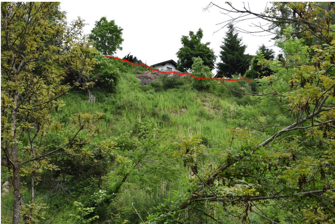
Abb. 143: Obere Steilstufe mit Blick auf die Anrisskante zum Zeitpunkt der Begehung, drei Jahre nach dem Rutschereignis
