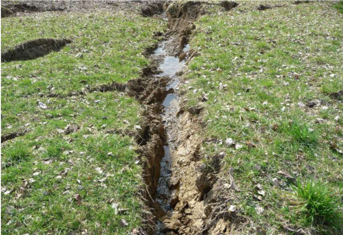
Abb. 152: Durch die starke Durchfeuchtung des Hangs sind die Risse teilweise mit Wasser gefüllt; Aufnahme direkt nach dem Rutschungsereignis (WLV Kärnten, 2014)
