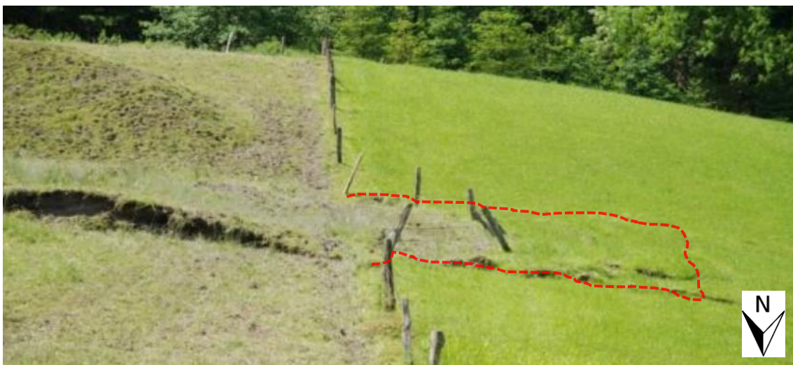
Abb. 87: Ausdehnung der Rutschung an verschobenen Zaunstempeln erkennbar (Gasperl, Tartarotti, 2014)
