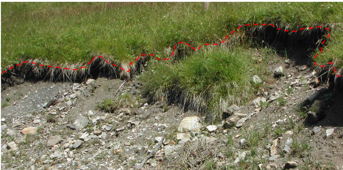
Abb. 30: Rutschung Guggenberg-Süd: Deutlich erkennbare Anrisskante durch Höhenversatz des Geländes. (WLV Kärnten)
