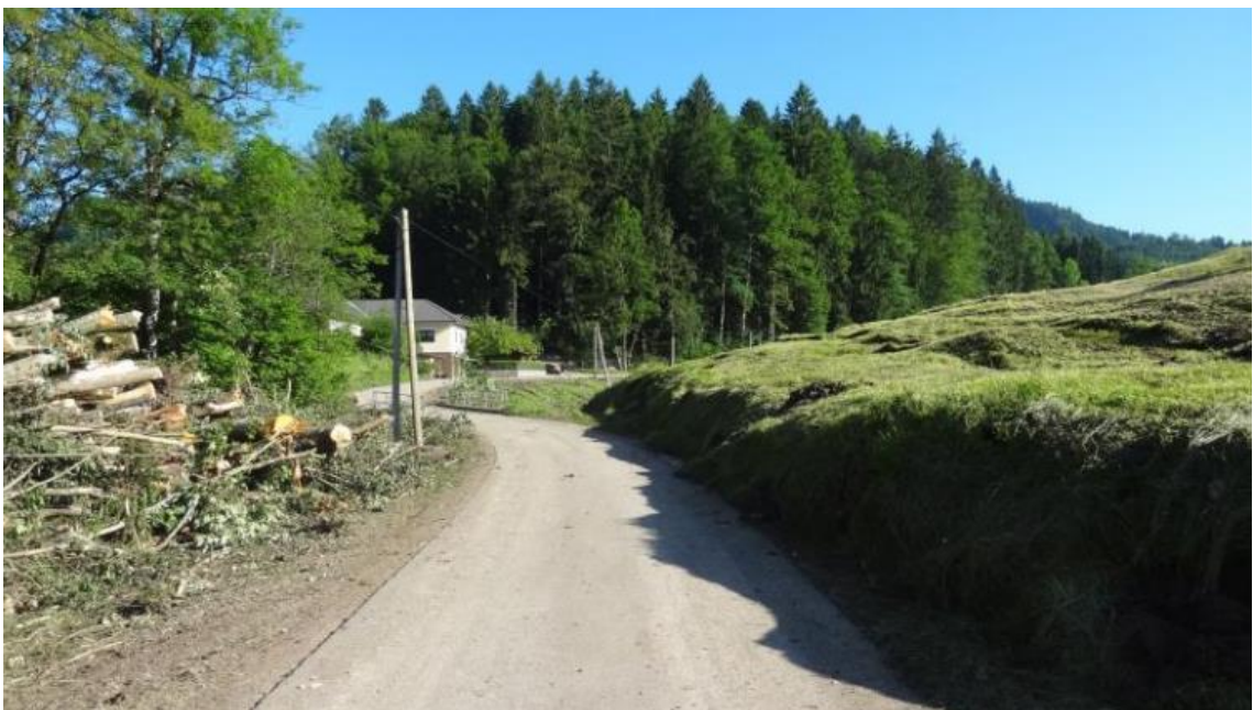
Abb. 49: Rutschung Höhenberg: Abbildung der Rutschungsstirn mit Stirnwulst und Aufschiebungen (Gasperl, Tartarotti, 2014)
