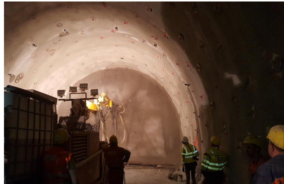
(d) Spraying of second layer shotcrete.
