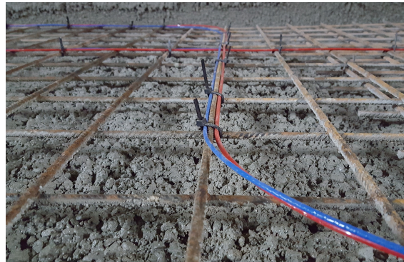
(d) Installed top layer of fibre-optic cables.
