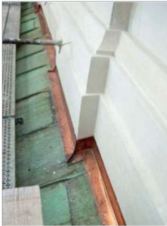
Bild 3.19 Nachträglich erstellter Blechhochzug 217
