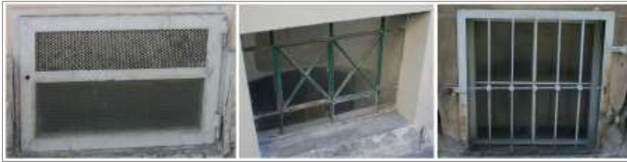
Bild 2.17 Ausführungsvarianten Sockelbereich 43
