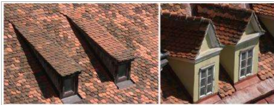
Bild 2.55 Schleppgaube (links) und Satteldachgaube (rechts) 106
