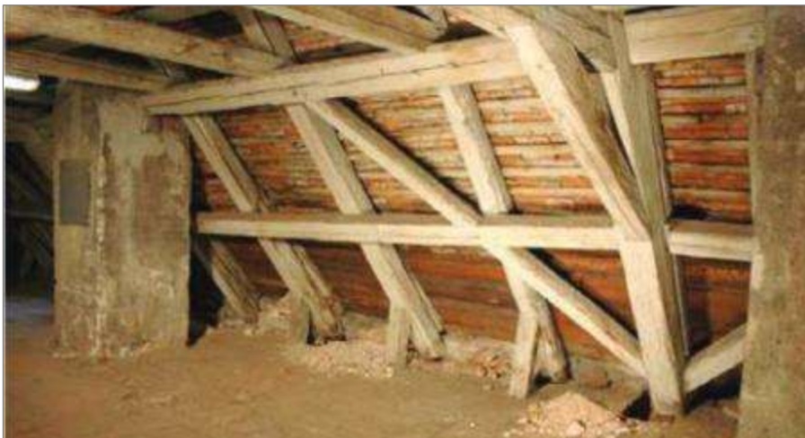
Bild 2.46 Dachgeschoss (Sparrendach mit liegendem Stuhl) 97
