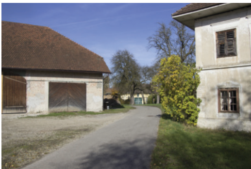
10 Foto von Südwesten nach Nordosten
