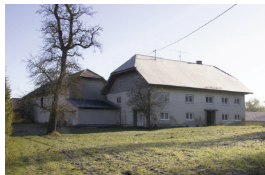
Abb. Ansicht Nordosten
