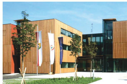
Abb. 66 Vorplatz mit Haupteingang
