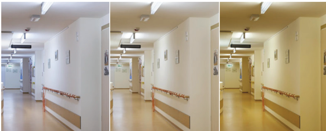
Abb. 24 Melanopisch wirksame Beleuchtung: wie das Tageslicht verändern sich Beleuchtungsstärke, Farbtemperatur und die Dynamik im Laufe des Tages. Kühlweiße Lichtfarben und hohe Beleuchtungsstärken unterstützen die Aktivität am Morgen. Tagsüber verändert sich das Licht dynamisch. Abends wirkt es durch warme Lichtfarben und reduzierter Helligkeit entspannend.
