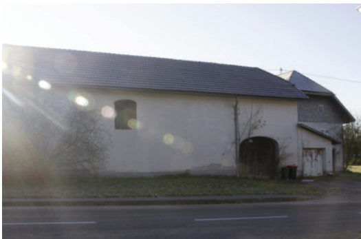
Abb. Ansicht Norden
