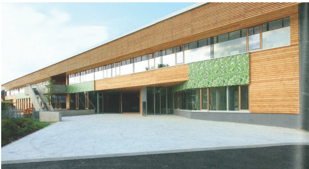
Abb. 58 Vorplatz mit Haupteingang
