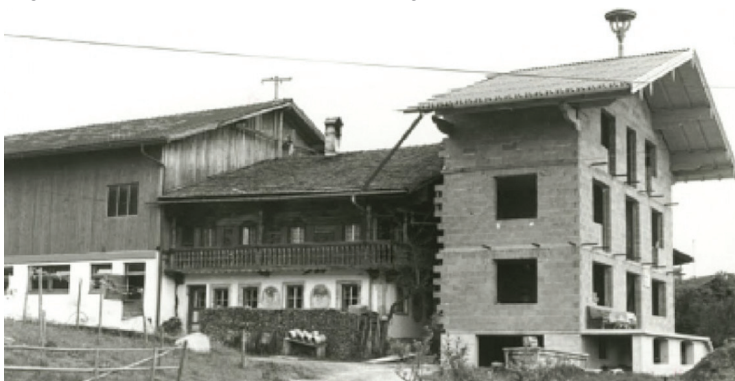
Abb. 90 Bauernhof in Breitenbach während eines Umbaus 1979: Verlust bäuerlicher Kultur.
