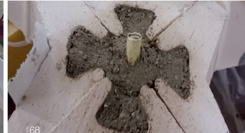
Ausgemörtelte Verbindungsstelle mit Bewehrung
