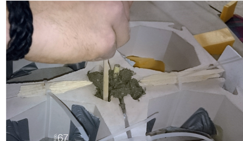
Händisches Verteilen des Mörtels
