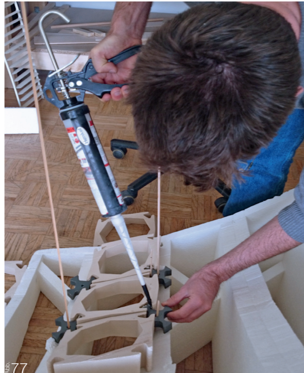
Einbringen von Injektionsmörtel
