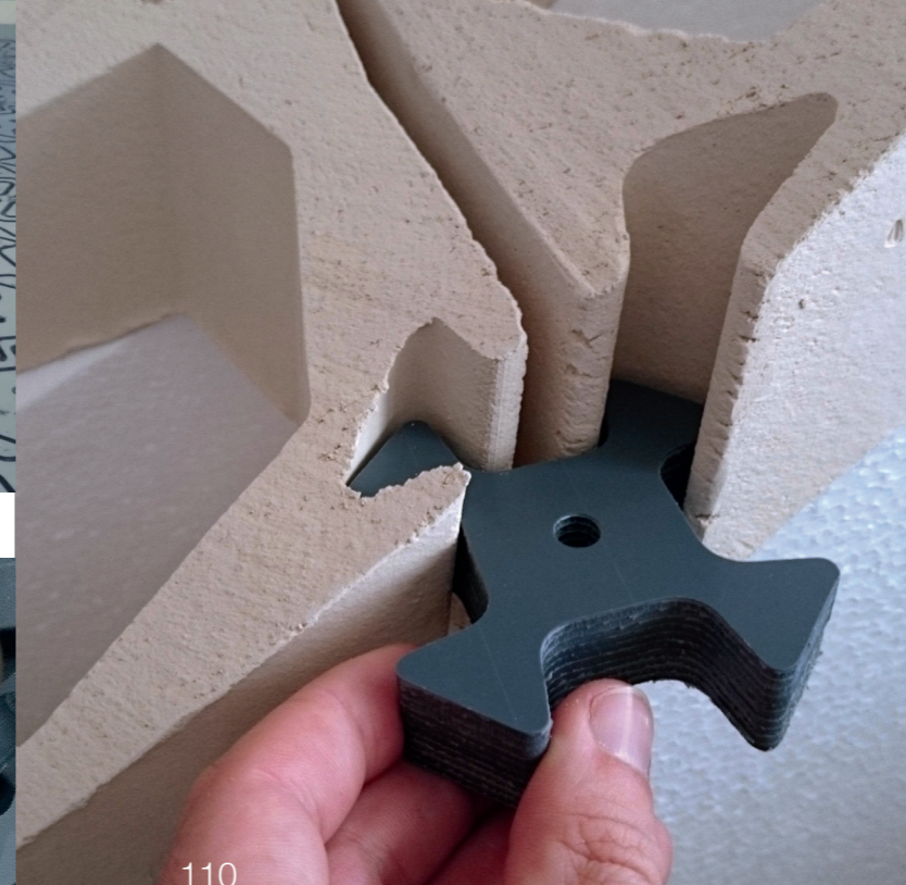
110 Eingesetzter PVC-Verbinder
