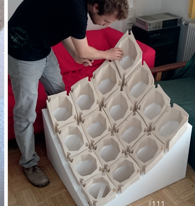
111 Anordnung auf der Montage-Unterkonstruktion
