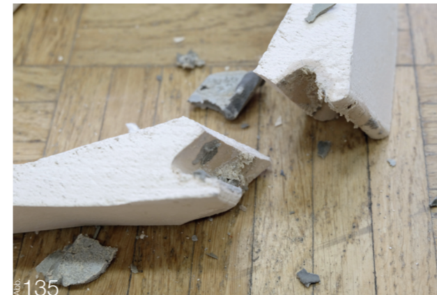
135 Bruchstelle im Eck des Moduls
