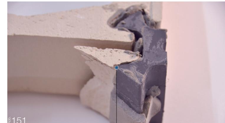
Abb. 151 Bruchstelle #2 - Injektionsmörtelkörper trägt zum Tragverhalten bei
