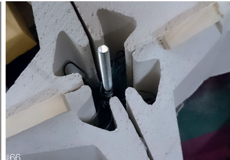
Verbindungsstelle mit Bewehrung
