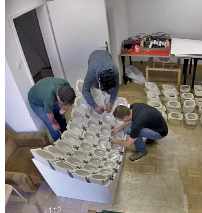
Abb. 112 Plazieren der Module und Verbinder
