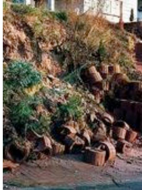
Abb. 56: Versagensfall Stützmauer aus Betonformsteinen (Ruhnau, 2004)
