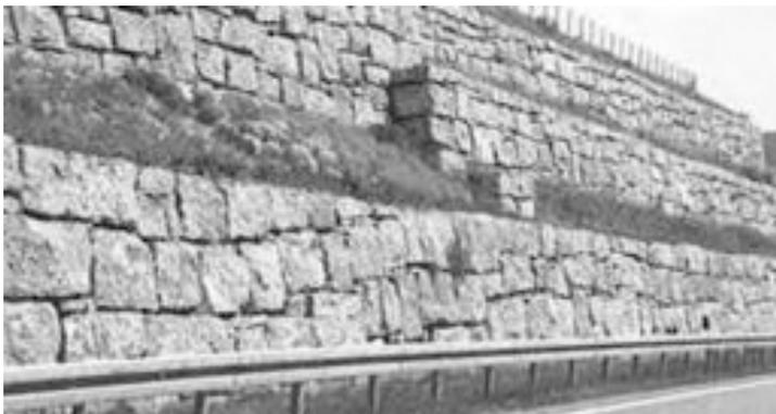
Abb. 7: Trockenmauer als Hangsicherung im Straßenbau (Jäger, 2014)
