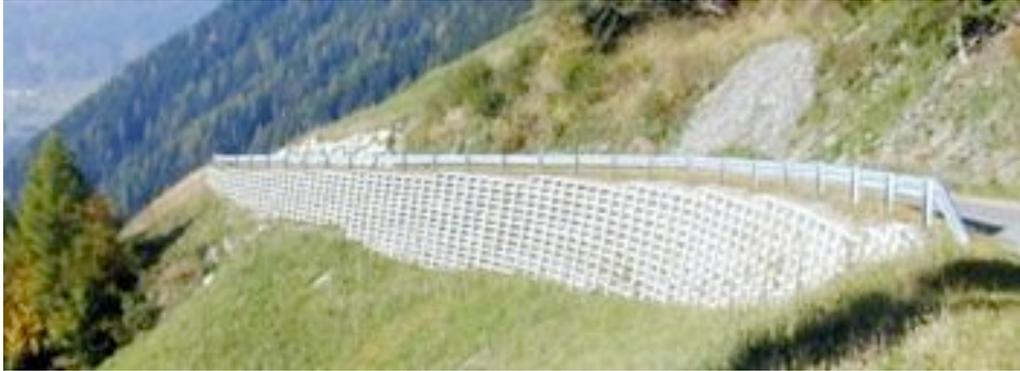
Abb. 35: Kraierwand aus Beton zur Böschungssicherung (VÖB, 2016)
