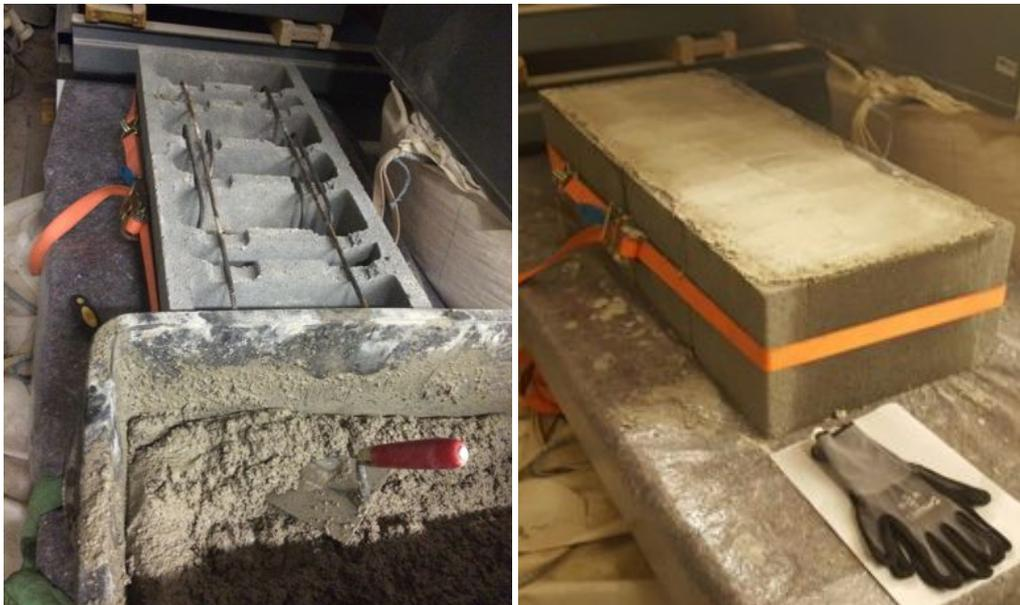
Abb. 118: Links: eingelegte Bewehrung; Rechts: fertige erste Reihe – ohne Glättung der Oberfläche
