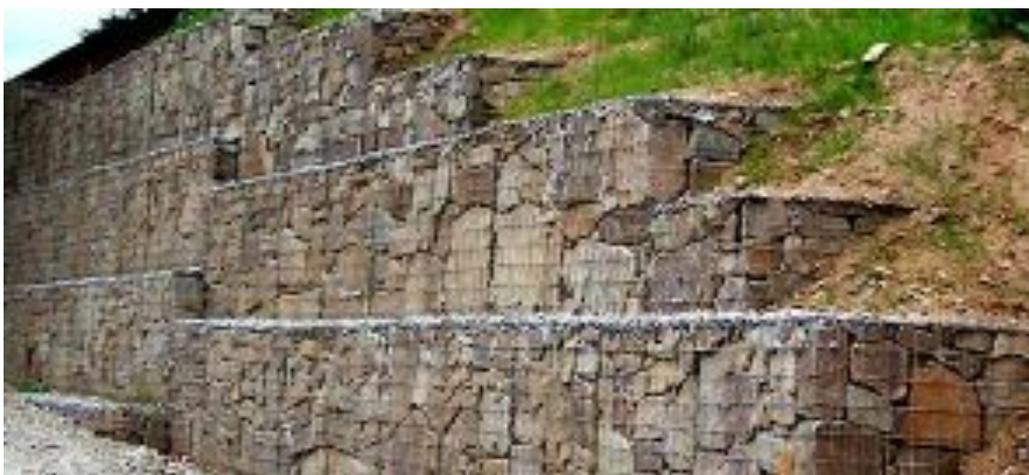
Abb. 51: abgetrepte Stützmauer aus Gabionen (Aquasol, 2016)
