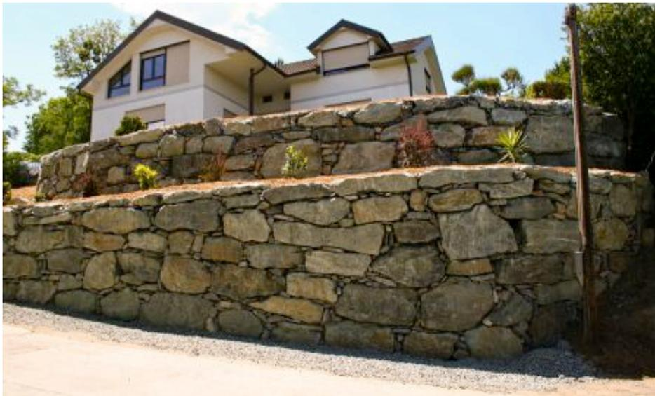
Abb. 26: Trockenmauer zur Terrassierung (Bieler, 2016)
