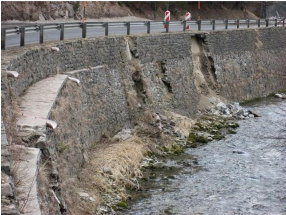
Abb. 60: Schadensfall Steinmauer (Land Steiermark, 2016)
