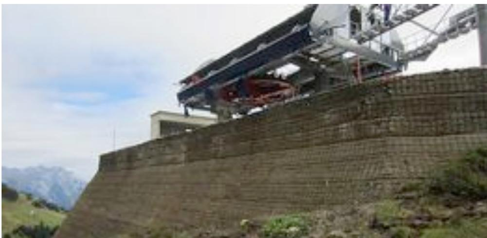
Abb. 44: Böschungssicherung (Geotechnik Team GmbH, 2016)
