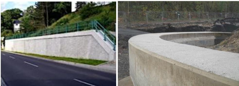
Abb. 19: Links: Gewichtsmauer als Hangsicherung neben einer Straße (Baugeo, 2016); Rechts: Betonmauer bewehrt in Sichtbetonqualität (Willi Prangenberg GmbH, 2016)
