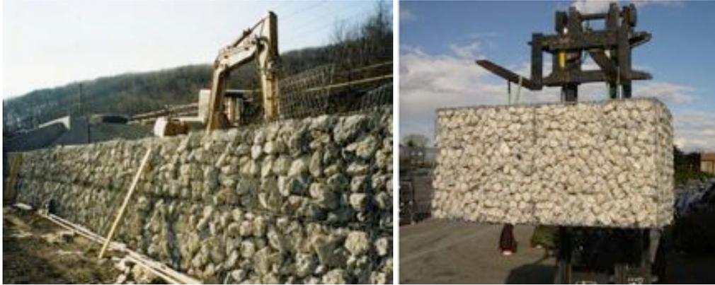
Abb. 47: Links: Herstellung von Gabionen vor Ort; Rechts: Vorgefertigte Gabione (Krismer, 2007)
