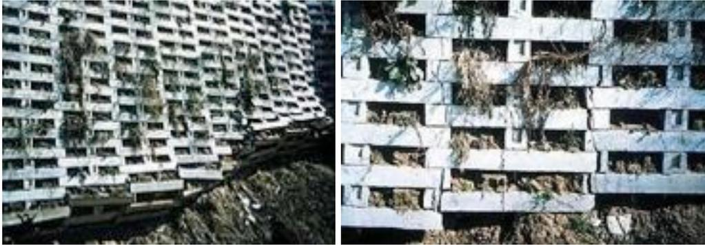
Abb. 58: Schadensfall Raumgitterkonstruktion (Ruhnau, 2004)
