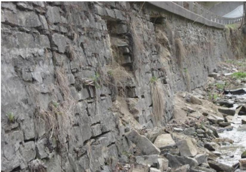
Abb. 59: Schadensfall Steinmauer (Land Steiermark, 2012)
