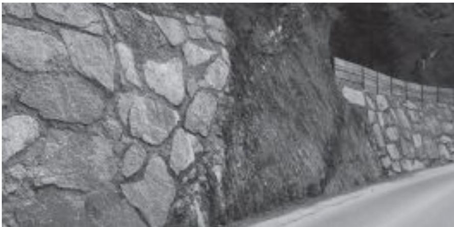
Abb. 29: Gemörtelte Steinmauer angebunden an eine Felsböschung (Wietek, 2011)
