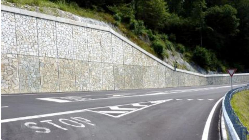
Abb. 20: Gewichtsmauer aus Betonfertigteilen (Steinbach-Starwalls, 2016)
