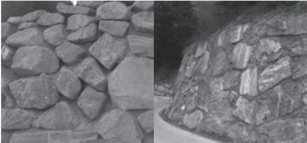
Abb. 28: Links: Steinmauer mit tief gesetztem Mörtelbett; Rechts: Gemörtelte Steinmauer (Wietek, 2011)
