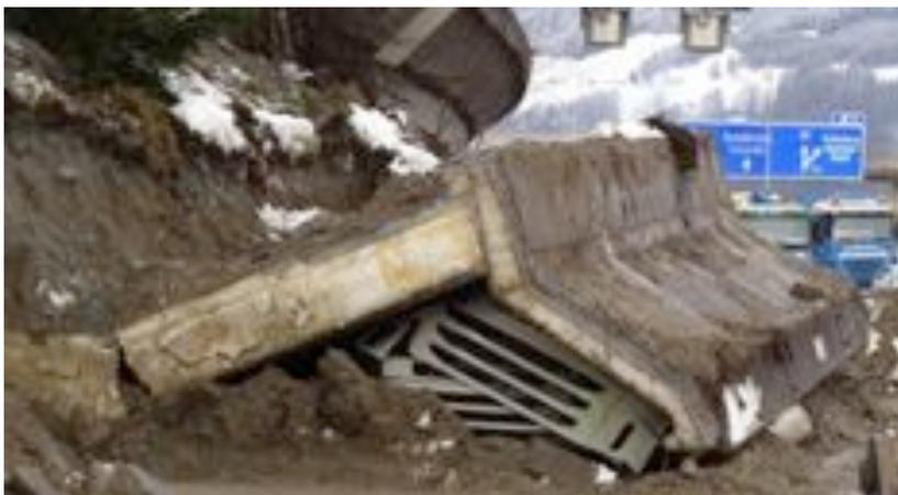
Abb. 1: Schadensbild des Wandverbruches, Mautstation Schönberg, Brennerautobahn (Marte et. al., 2013)
