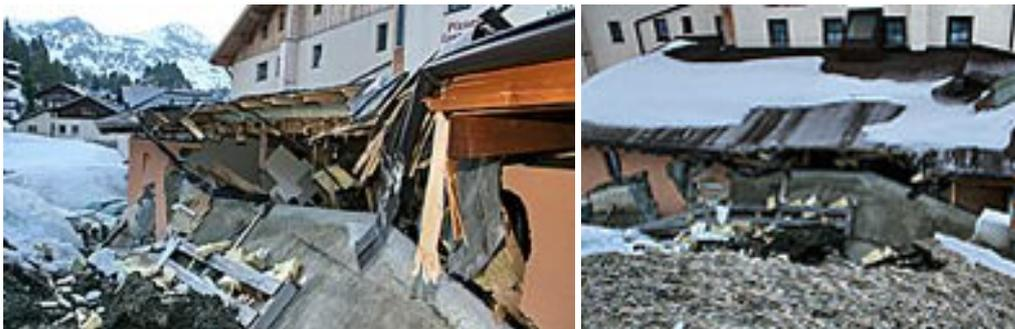
Abb. 55: Versagensfall Stützmauer Obertauern (salzburg.orf.at, 2007)
