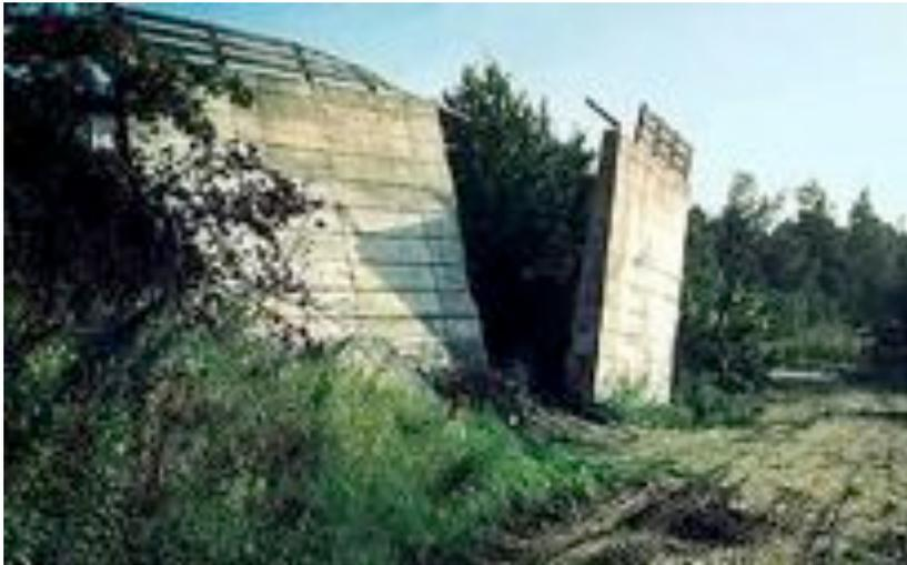
Abb. 61: Schadensfall Geländebruch (Ruhnau, 2004)
