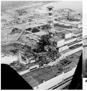
Abbildung 8:Tschernobyl - Explodierter Block 4 (Spiegel T. expl. Block, 2016)
