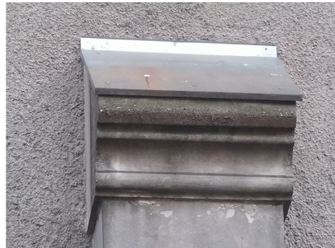
Abbildung 54: Feuchteschäden
