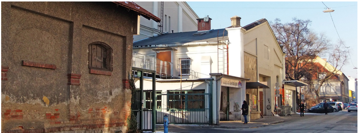
Abbildung 27: Blick auf die Ostfassade
