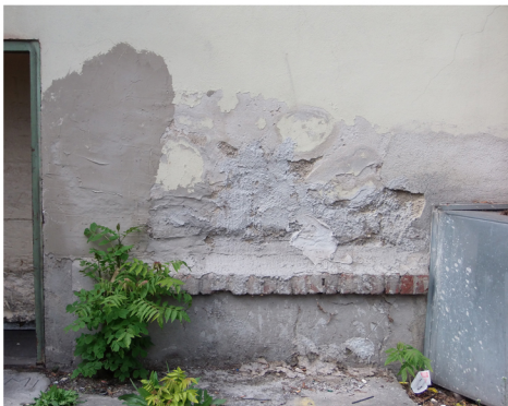
Abbildung 61: Zementhaltige Ausbesserungsarbeiten
