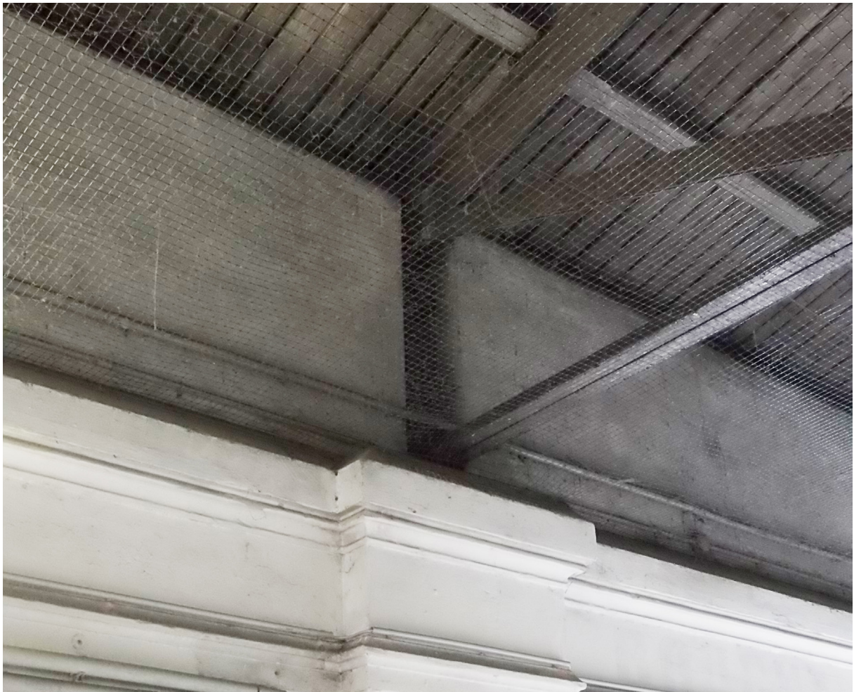
Abbildung 29: Detail der Dachkonstruktion der Halle
