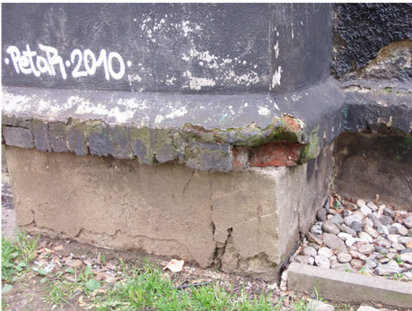
Abbildung 53: Fehlende Bausubstanz
