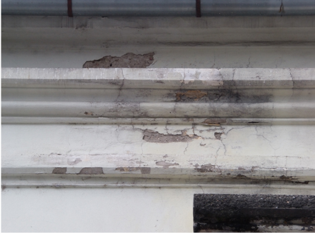
Abbildung 51: Abbröckelnder Putz
