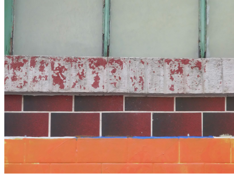
Abbildung 52: Abbröckelnde Farbe
