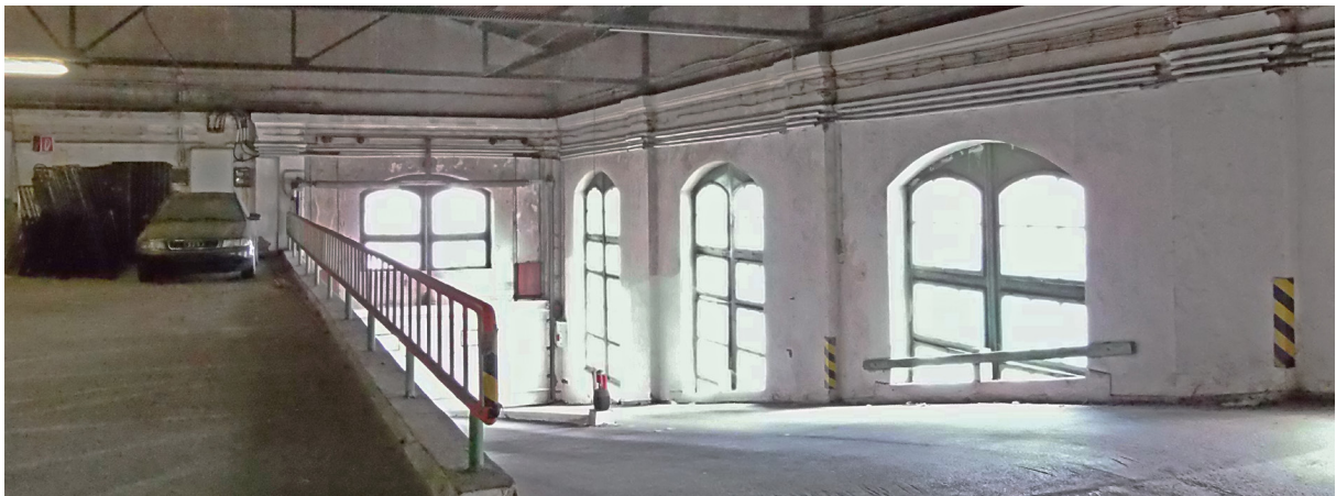
Abbildung 30: Blick auf die Auffahrtsrampe zur Garage
