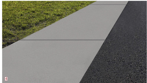
Abbildung 75: Übergang zwischen dem Asphalt und Gras
