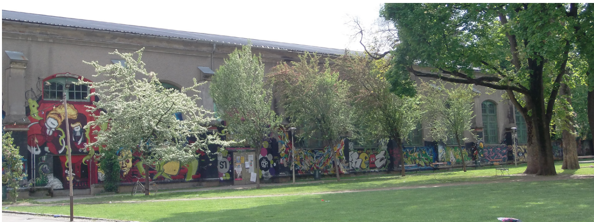
Abbildung 21: Nordfassade der Postgarage
