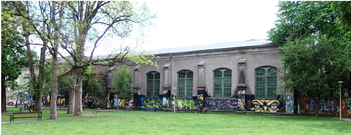
Abbildung 20: Blick auf die Postgarage von der Rösselmühlgasse
