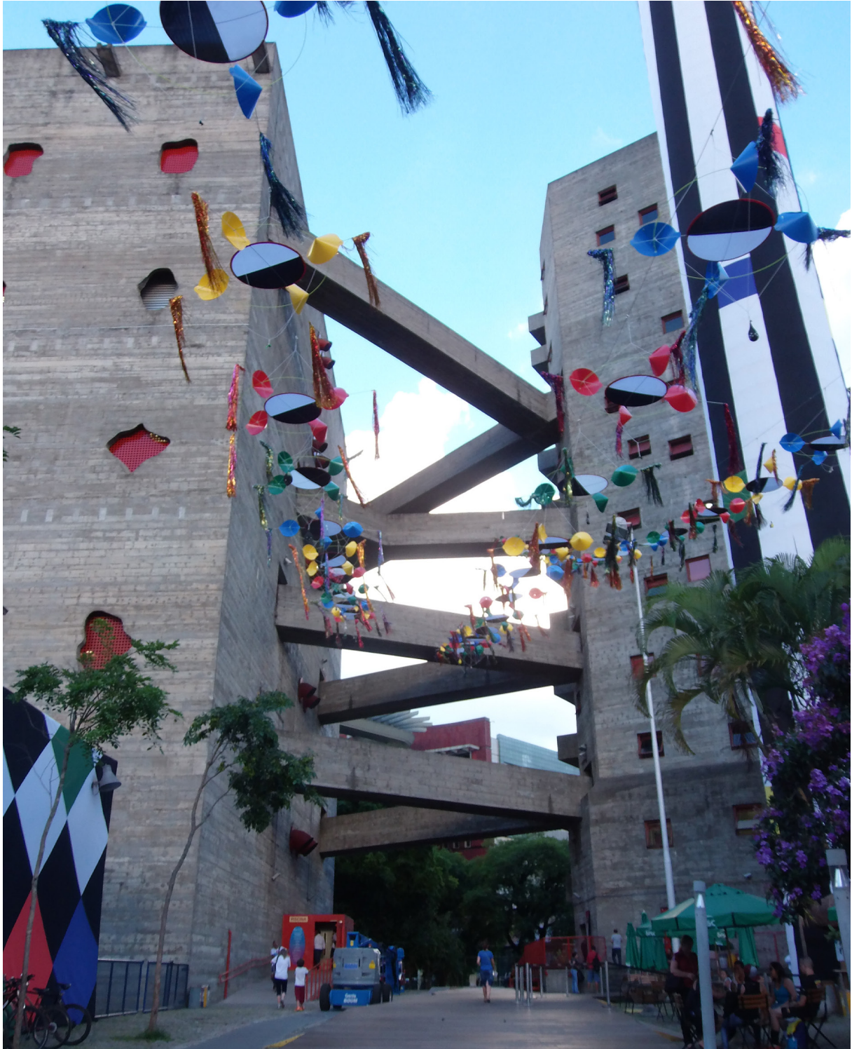
Abbildung 41: Blick auf die Türme
