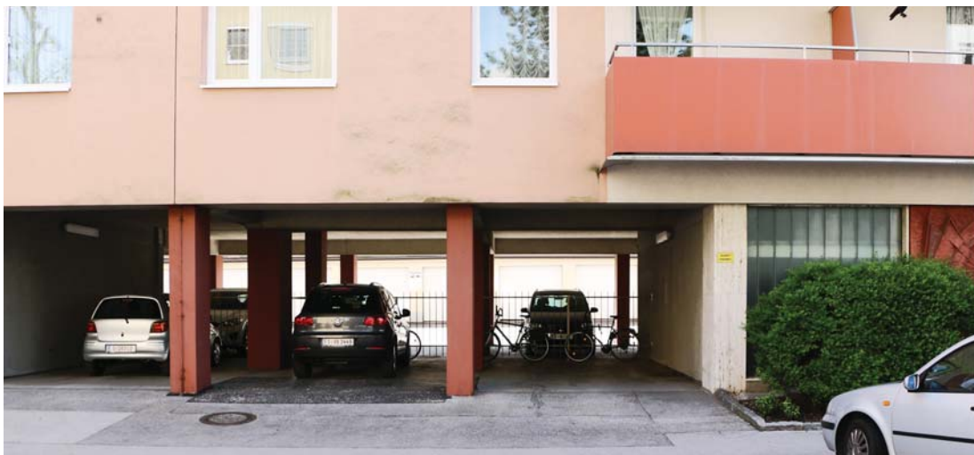
021. Abbildung , Bauwerk Hüttenbergstraße 2-8
