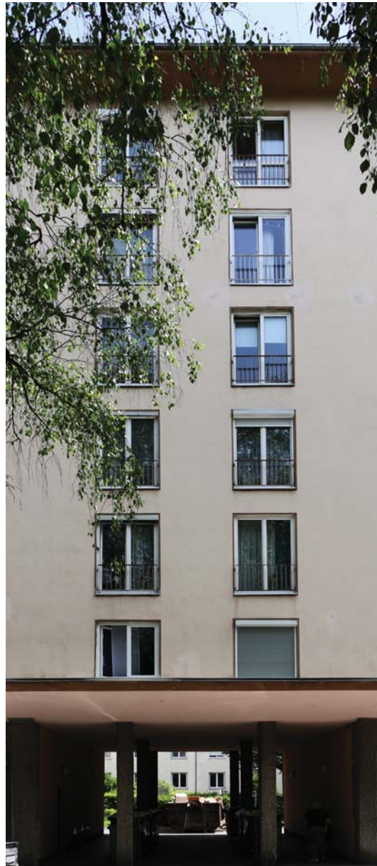
beide: Wohnblock Hans-Sachs-Gasse, Roseggerstraße, Ignaz- Harrer-Straße
