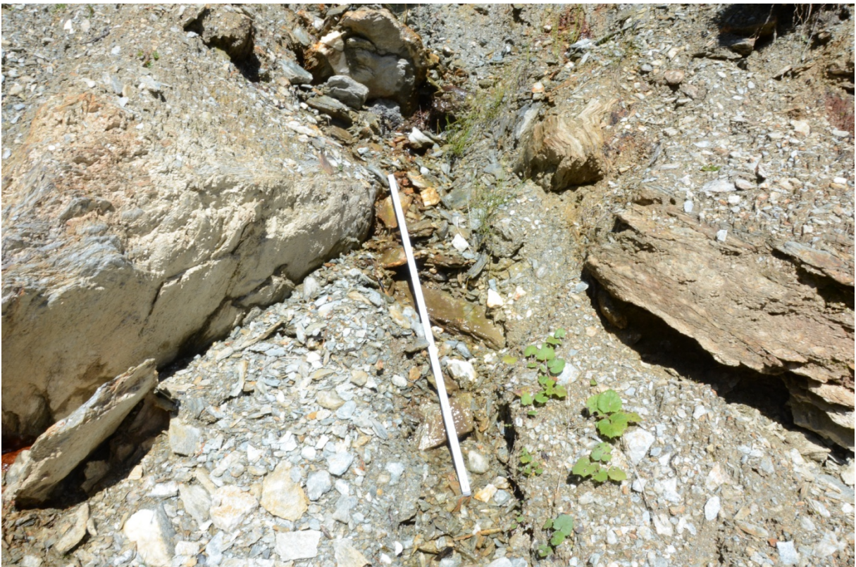
Abbildung 12: Grundwasseraustritt im Abrissbereich oberhalb der Schönmoos-Alm.
