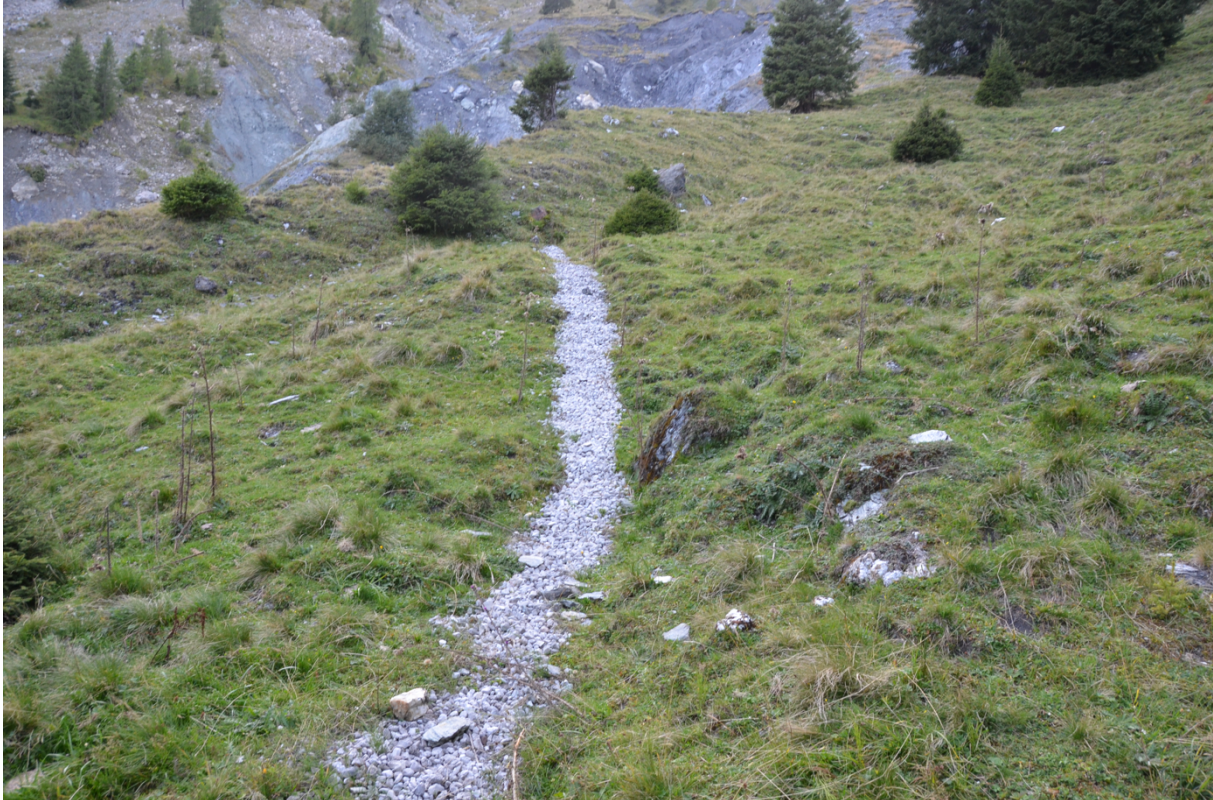
Abbildung 23: Bereich eines Drainagesystems im Blaubachgraben in Krimml (Salzburg) zur langfristigen Hangstabilisierung. Foto: privat
