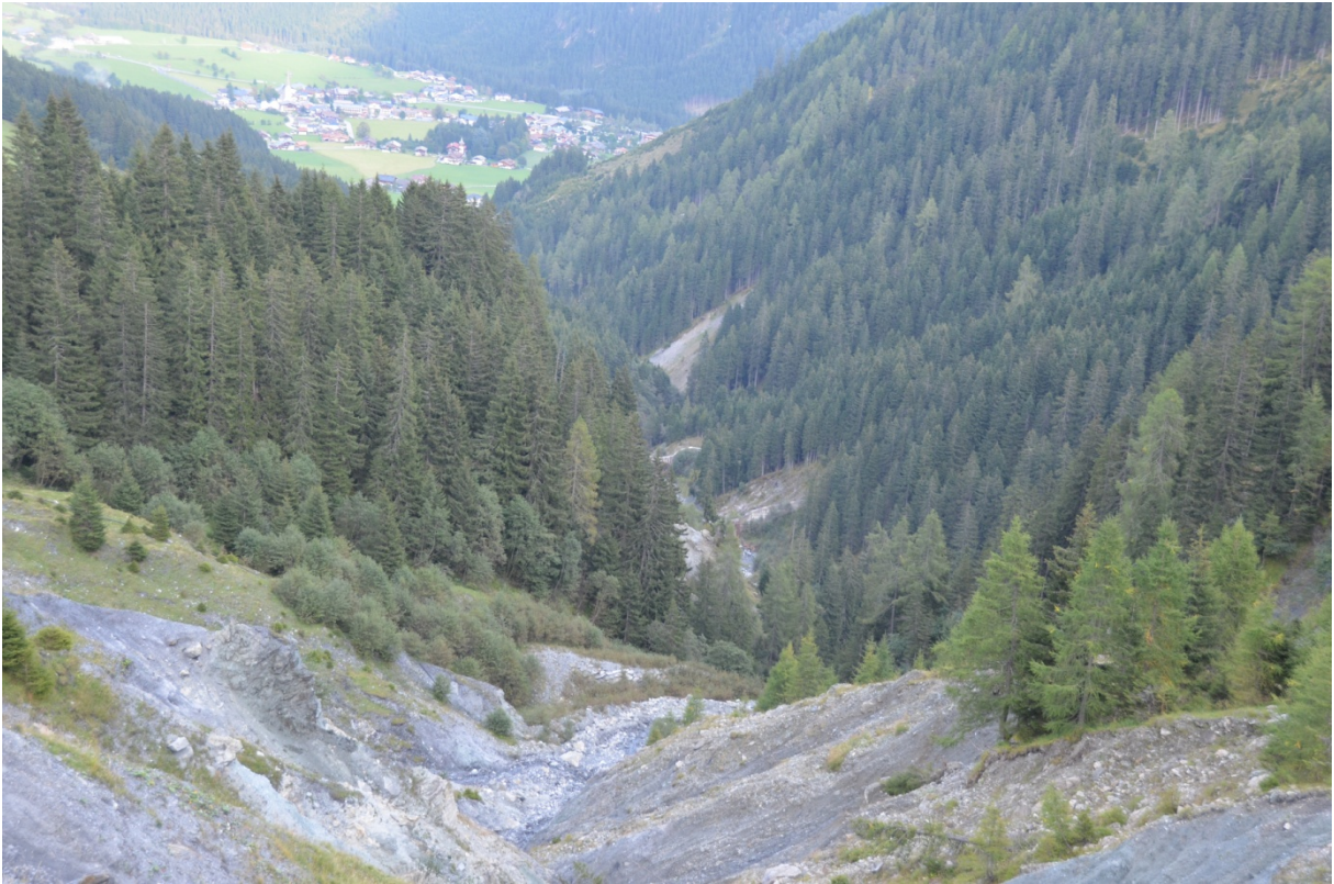
Abbildung 28: Blick in den stark erodierten Bereich unterhalb des Schönmoos-Hochalm.
