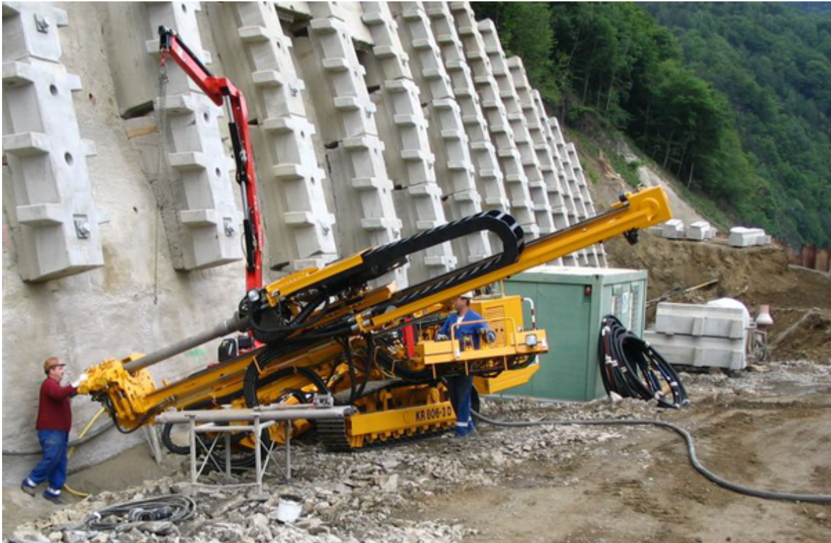
Abbildung 24: Installation einer Ankerwand zum Schutz von Infrastruktur. Foto: PORR AG ( www.porr.at )
