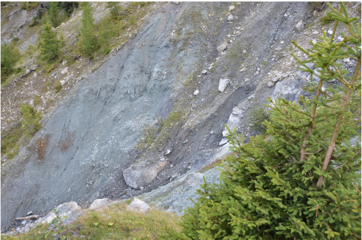
Abbildung 39: Nachbrechen sowie Steinschlag im übersteilten Bereich des Ablagerungsraumes.
