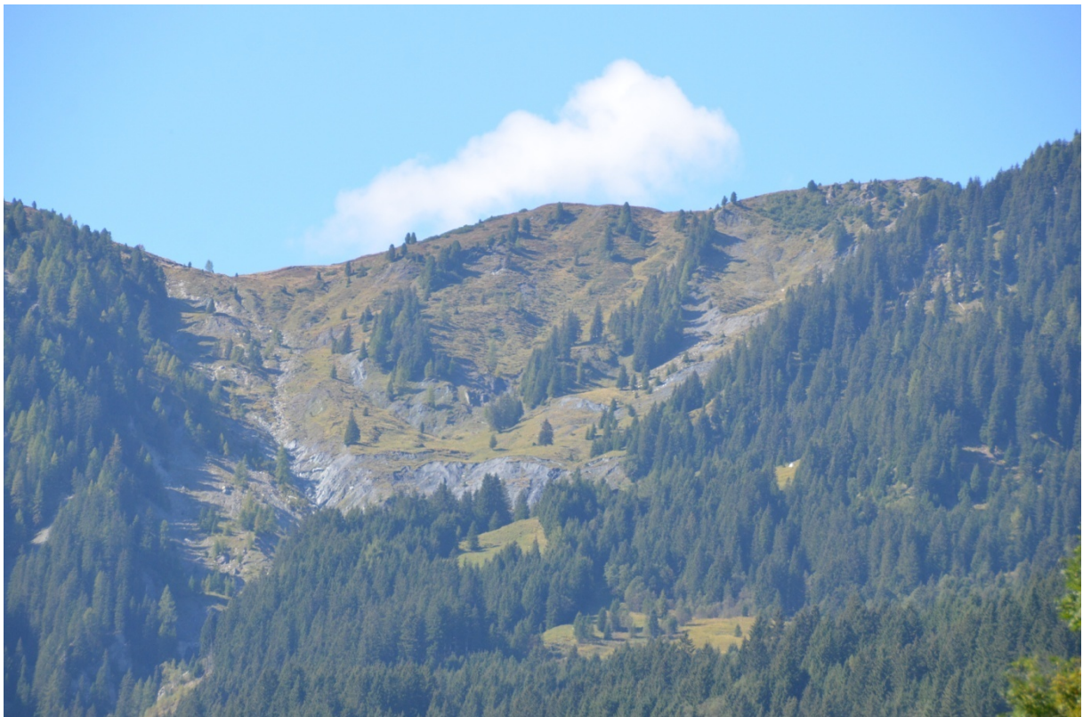
Abbildung 25: Rutschkörper im Blaubachgraben vom Ortszentrum von Krimml aus gesehen. Foto: privat
