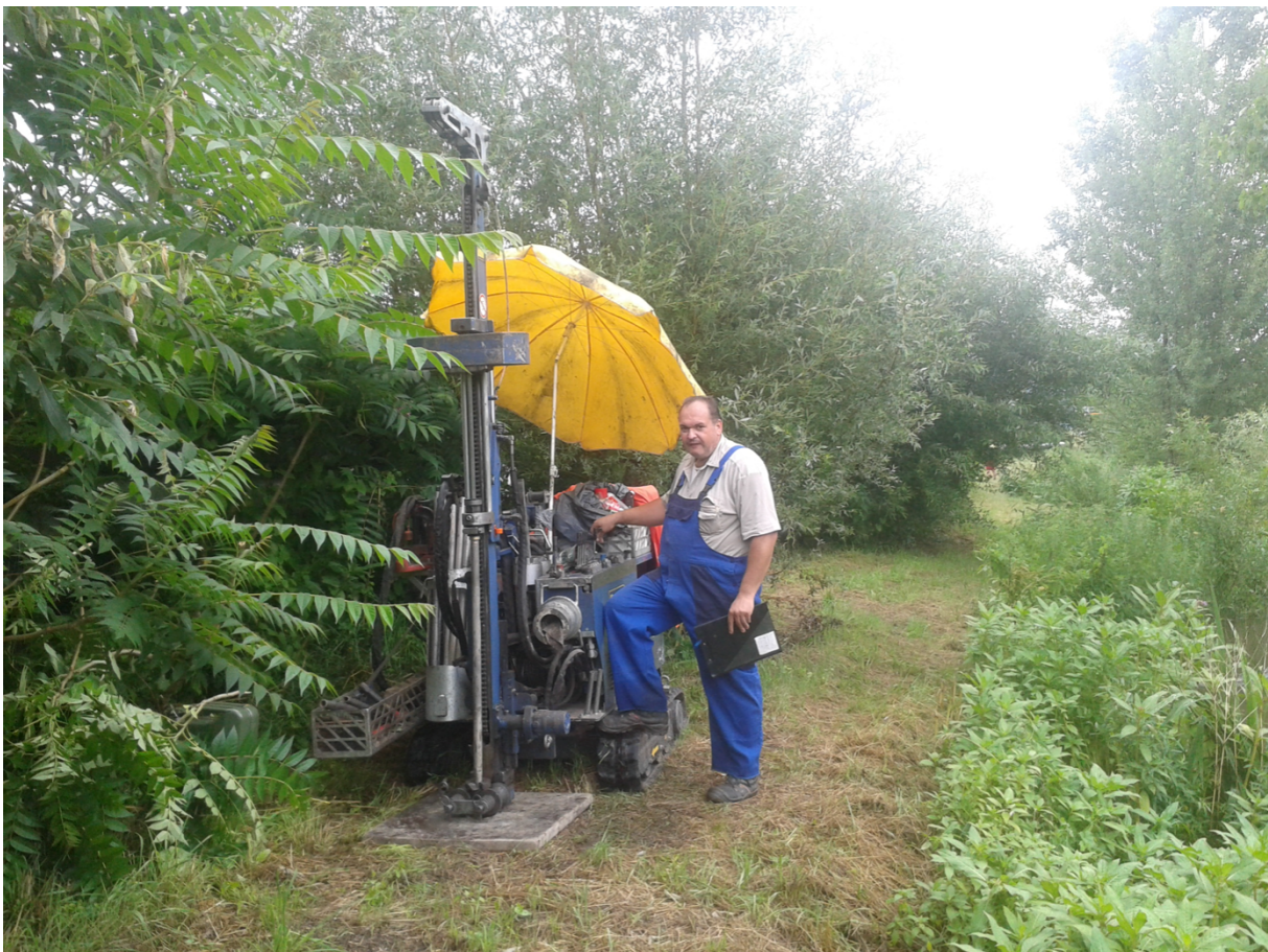
Abbildung 18: Abteufen einer Rammsondierung im Zuge einer geologischen Baugrunderkundung. Foto: Ziviltechnik Geologie | Mag. Oliver Montag)
