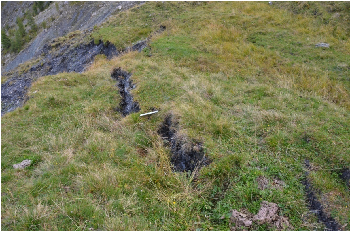
Abbildung 50: Translationsrisse deuten auf neue Ausbildungen von Rotationsgleitflächen hin. Die Abbildung wurde nahe der Abbruchkante in die Erosionsmulde aufgenommen, ähnliche Szenarien wurden öfter im Alm- und Wiesenbereich angetroffen. Foto: privat
