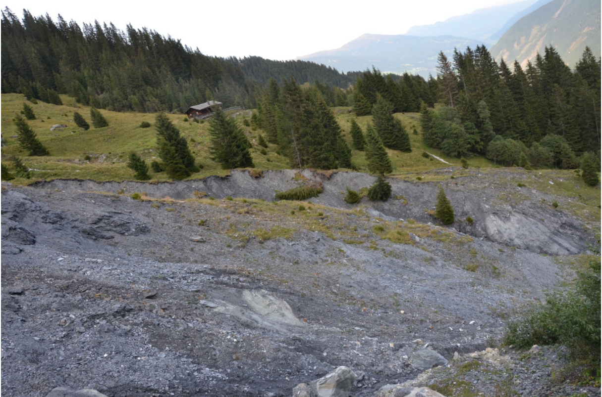
Abbildung 34: Unterhalb der Schönmoos-Hochalm wurden Drainage-Vorrichtungen errichtet um das Oberflächenwasser gezielt abzuleiten und die Hangbewegungen zu entschärfen.
