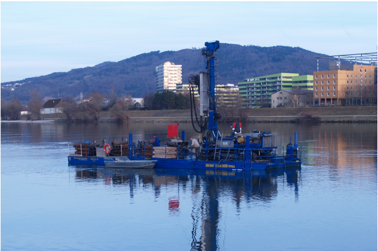
Abbildung 17: Abteufen einer Kernbohrung von einem Ponton in der Donau bei Linz. Um einen Kernverlust zu vermeiden, musste hier das Material in einem Liner erbohrt werden. (Foto: Ziviltechnik Geologie | Mag. Oliver Montag)
