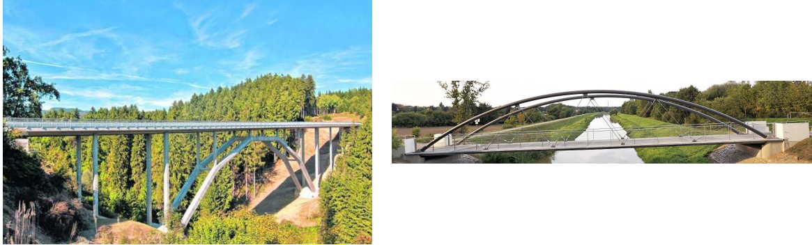
Abbildung 11 Wildbrücke mit Polygonbogen aus UHPC [24] (links) und Radwegbrücke mit einer Fahrbahnplatte aus UHPC [25] (rechts)
