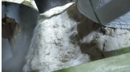
Zugabe der „Stahlfaser-Grobkorn-Premix“
