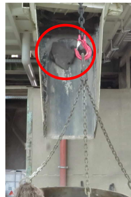
„Klumpenweise“ Entleerung des nicht fertigmischten Frischbetons
