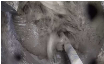
Maximale Leistungsaufnahme des Wirblers – Beginn der Verflüssigung
