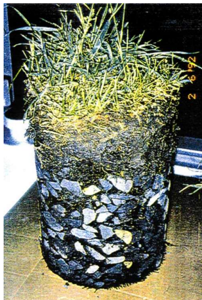
Abbildung 10 Bohrkern aus einem Mastix-Schotter Deckwerk als Überströmsicherung (Elskens, 1995)
