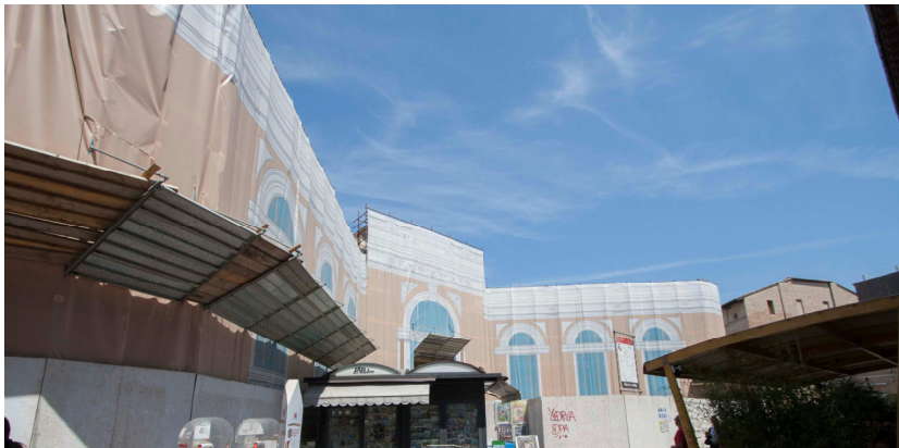
Bild 3.13 Folienabhängung mit Druck von Fassade und Schutzdach 213
