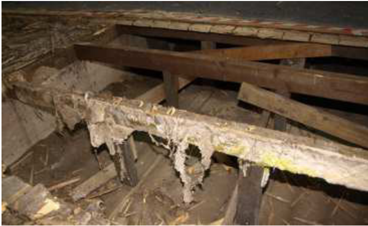
Bild 4.5 Echten Hausschwamms unter einem Sportboden 360
