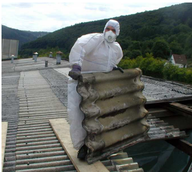
Bild 4.15 Asbestsanierung 428
