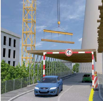
Bild 3.11 Schutzdach im Schwenkbereich der Krane 211
