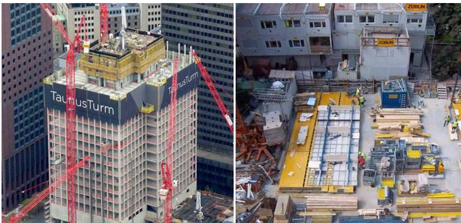
Bild 5.5 TaunusTurm in Frankfurt – Selbstkletterschalung und Lagerflächen 474
