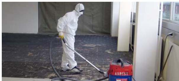
Bild 4.17 Asbestsanierung in Innenräumen 430
