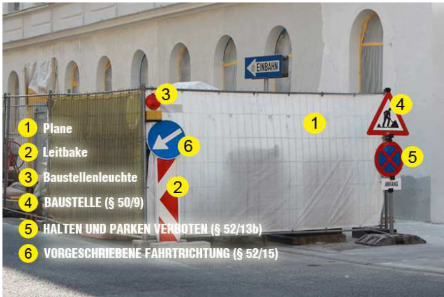
Bild 5.16 Verkehrssicherung an Baustellen 543
