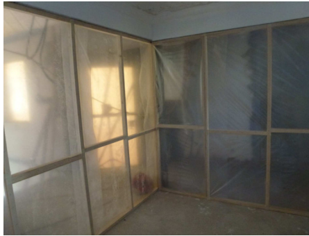
Bild 3.15 Staubwände bei Teilsanierungen 215
