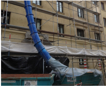
Bild 3.14 Einhausung von Container und Schuttrutsche 214
