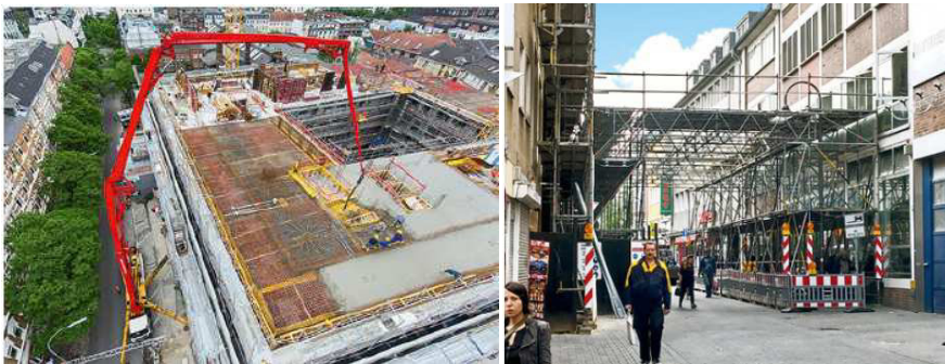
Bild 5.6 Schwerlastgerüst über öffentliche Verkehrsfläche als Lagerfläche und Autobetonpumpe mit 58 m Ausleger 477
