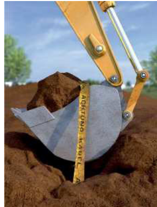
Bild 6.1 Markierung von Kabel im Erdreich 547
