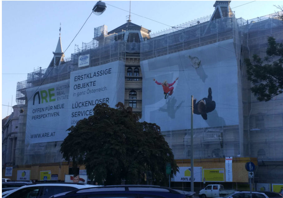
Bild 5.15 Fassadengerüst mit Staubnetz und Fußgängertunnel 540
