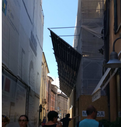
Bild 3.12 Folienabhängung und Schutzdach in Fußgängerzone 212
