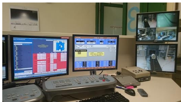
Abbildung 10: Steuerungskonsole und Überwachungsbildschirme der verwendeten Bestrahlungseinheit.
