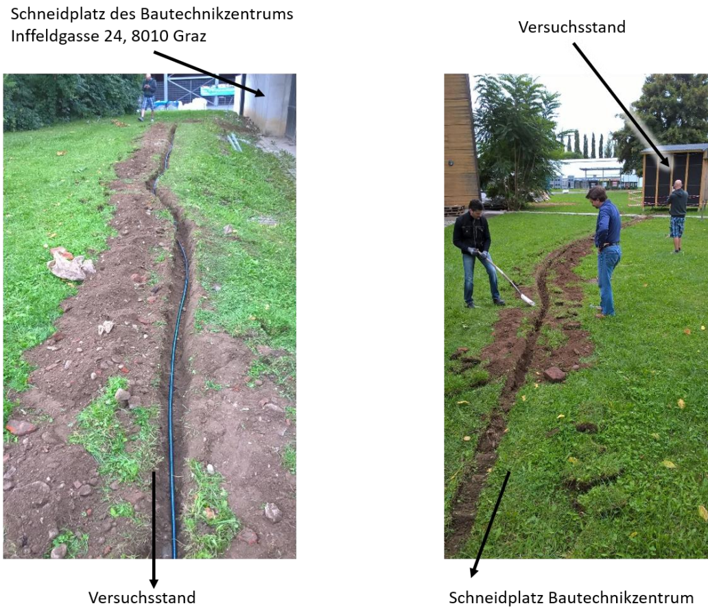
Abbildung 4-3: Eingraben der Zuleitung
