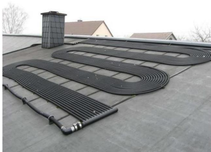
Abbildung 2-7: Schwimmbadabsorber mit Rippenrohr [9]
