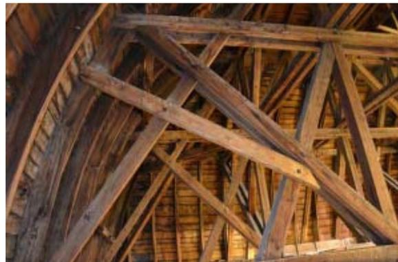
*Abb. 5.116: Sinnlos eingebaute, einseitige Diagonalverstrebung am Vollgespärre VG-3*
