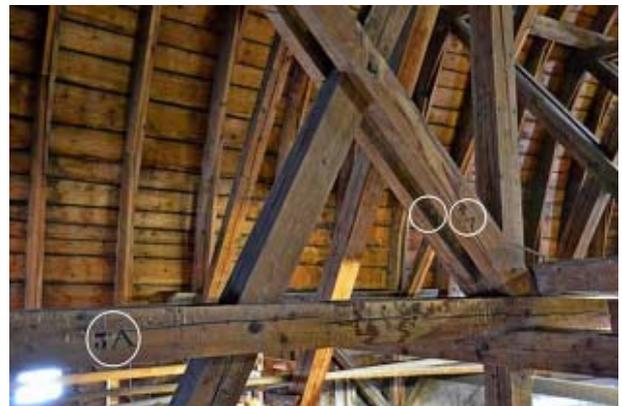
**Abb. 5.17:** *Aufgestempelte Kennzeichnungen an den Konstruktionshölzern der Hauptkuppel*
