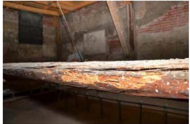
*Abb. 5.112: Abgeklungener Insektenbefall am Lagerbalken der Wartungstreppe*
