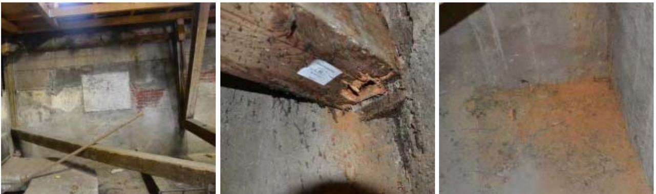
**Abb. 5.108: vollständig zerstörtes Bundtramauflager**
