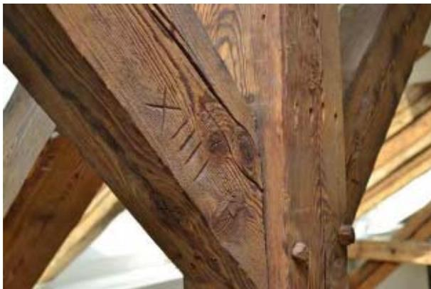
**Abb. 5.16:** *Eingeschlagene Abbundzeichen an einem Kopfband im Westtrakt*
