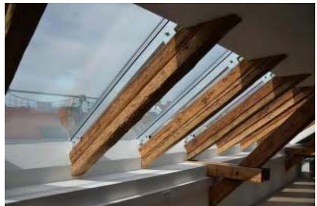
**Abb. 5.10:** Große Dachfenster mit auf den Sparren verschraubten stählernen Halteprofilen
