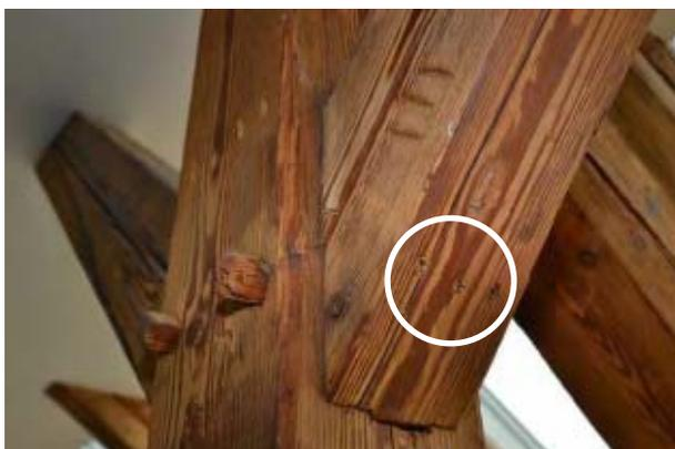
**Abb. 5.11:** Fragwürdige Verschraubung eines mit Holznagel gesicherten Kopfbandes
