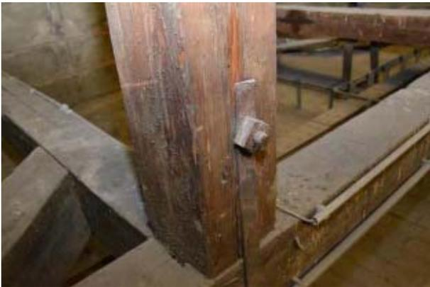
Abb. 5.109: Durchsteckbolzen einer Eisenaufhängung durch die Hängestuhlsäule
