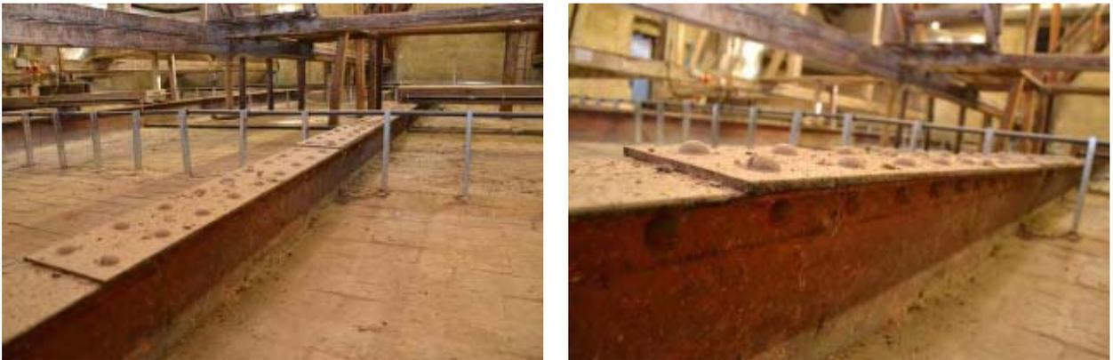
**Abb. 5.22: Mit Pflasterklinker bekleidete Dippelbaum-Eisentraversendecke über dem Aulafestsaal**
