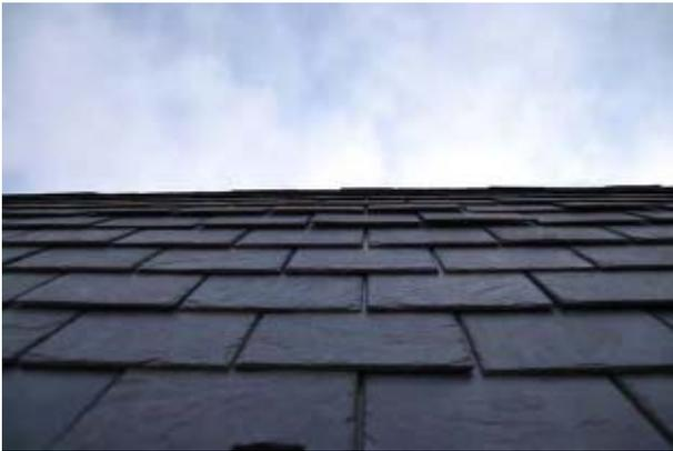
**Abb. 5.39:** Schieferplattendeckung der Hauptkuppel
