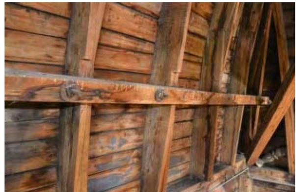
**Abb. 5.28:** Rückverankerung der Zierstatuen an einen quer zu den Sparren liegenden Ankerbalken innen
