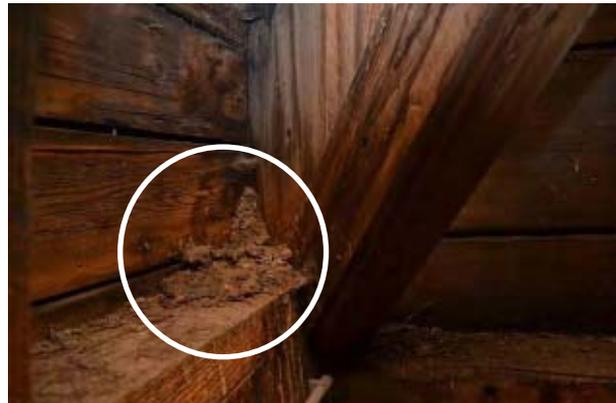
*Abb. 5.118: Verschmutzungen und tierische Exkremente im Hauptkuppeltragwerk der „Alten Technik“*
