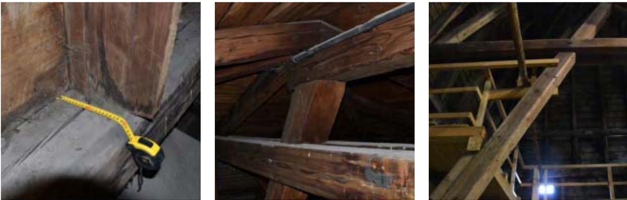
**Abb. 5.34: Auswahl von Kuppelbauteilen, an denen Baumkanten aufgefunden wurden**
