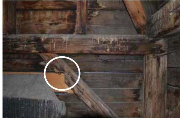
*Abb. 5.115: Wiederverwerteter Sparrenverschnitt als Kopfbandkonstruktion der Hauptkuppel*
