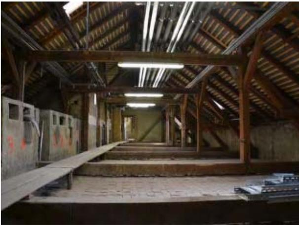
**Abb. 5.3: Doppeltes Hängewerk (Seitentrakt)**
