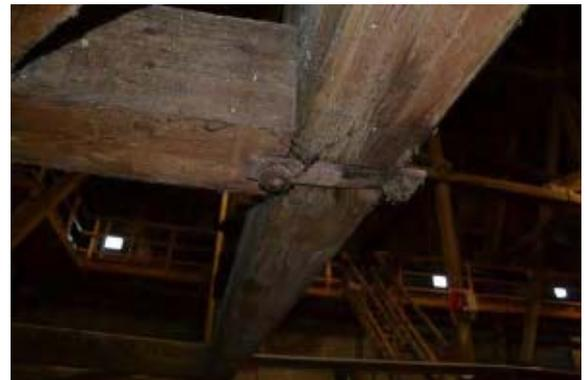
**Abb. 5.38:** *Eiserne Aufhängung eines Bundtrams an eine Stuhlsäule. Vollgespärre VG-2 An der rechten Bundtramskante sind leichte Holzquetschungen erkennbar.*
