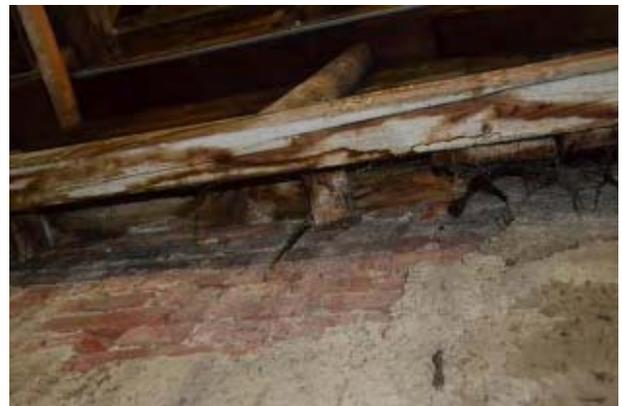
*Abb. 5.114: Untersicht der Rinnenkonstruktion. Die liegenden Bretter sind bereits weitestgehend durchgemorscht.*
