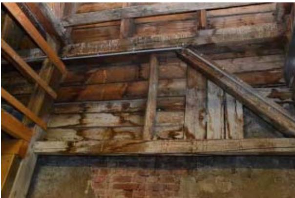
*Abb. 5.113: Erkennbarer Wasserschaden am Brettverschlag im östlichen Traufenbereich der Hauptkuppel*
