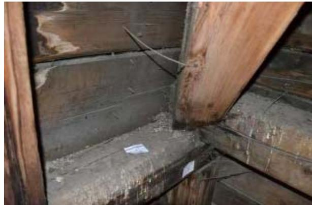
Abb. 5.106: Draufsicht auf Fußpfette der Kuppel mit Blickrichtung entlang des Strebenholzes
