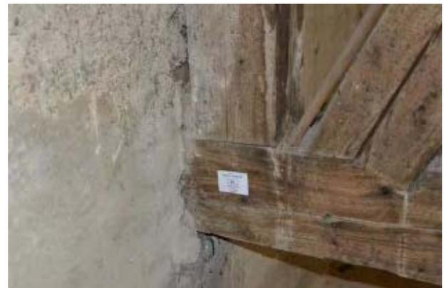
**Abb. 5.103: Lage der Messung RES 04 zur Ermittlung der Zapfenlochbreite des Stuhlsäulenanschlusses**
