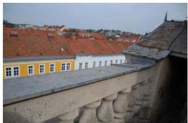
**Abb. 5.30:** Zierbalustrade mit Abdeckung an der kleineren nordwestlichen Zierkuppel
