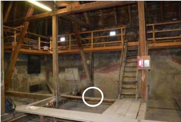
*Abb. 5.111: Wartungstreppe zum Aufstieg auf die neuere, nördliche Wartungsgalerie*
