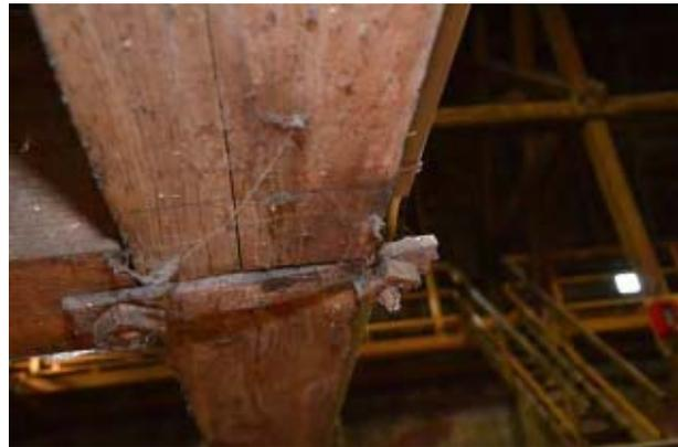
Abb. 5.110: Deutlich erkennbare Kantenpressung am hochgehängten Bundtram
