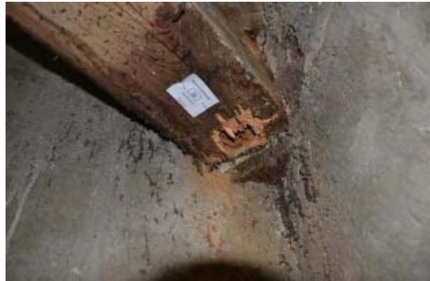
Abb. 5.98: Vollständig zerstörter Auflagerbereich des Bundtrams
