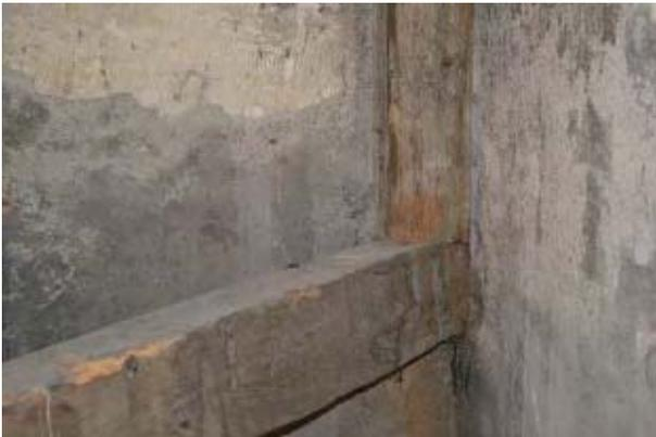
Abb. 5.97: Vermutlich intakter Bundtram im Achskreuzungspunkt (A-1)
