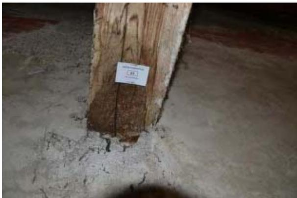
**Abb. 5.102: Lage der Messung RES 03 zur Ermittlung der Zapfenlochtiefe des Stuhlsäulenanschlusses**
