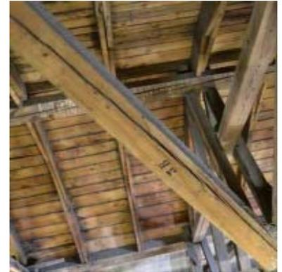
**Abb. 5.36:** *Faserneigung der Strebe, erkennbar am Schwindriss*
