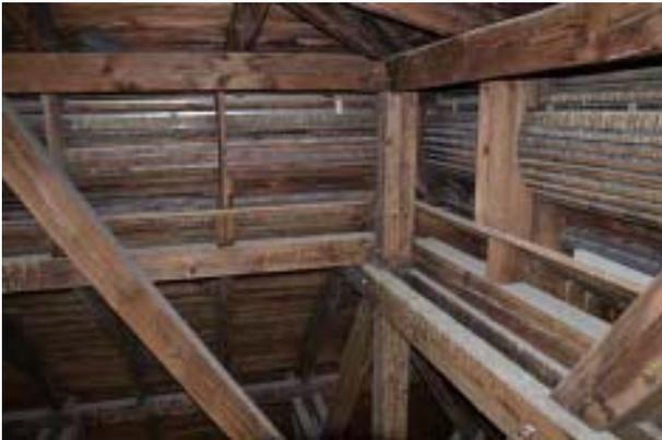
**Abb. 5.41:** Trägerleistenkonstruktion für den verblechten Übergangsbereich Kuppel-Laterne
