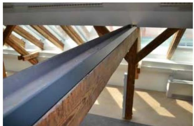
**Abb. 5.12:** Notwendige Verstärkung des hölzernen Hängewerkdruckgurtes mittels U-Profil
