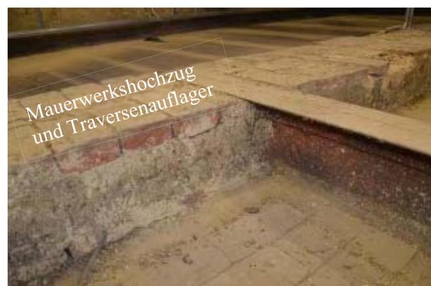
**Abb. 5.26:** Mauerwerkshochzug unterhalb des Vollgespärre VG-D
