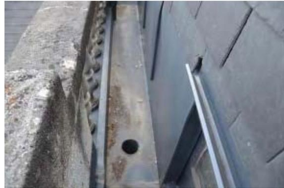
**Abb. 5.32:** Rinnenausbildung mit angelötetem Abfallrohr an der Ostseite der Hauptkuppel
