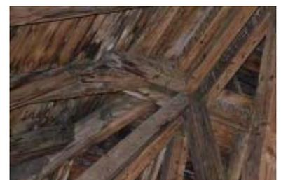
**Abb. 5.37:** *Feuchteschlieren an der Dacheinschalung und an horizontal liegenden Bauteilen*
