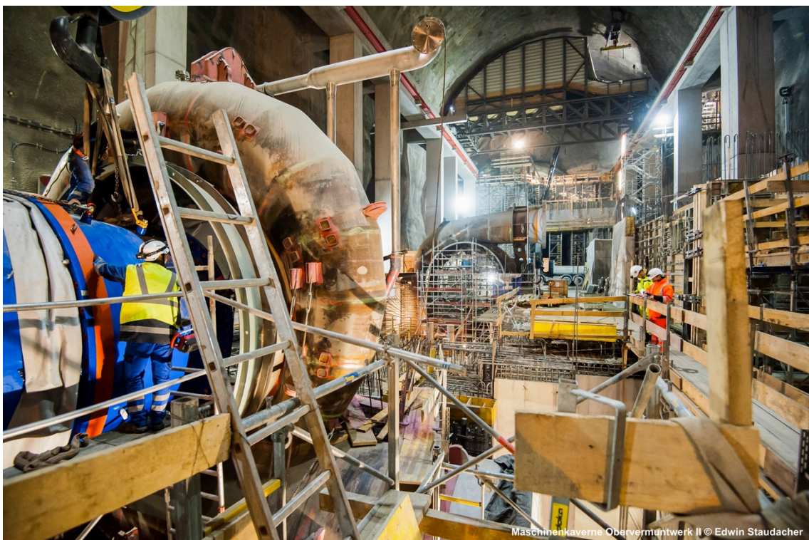
Abbildung 68: Maschinenkaverne des Obervermuntwerks II der Vorarlberger Illwerke AG während des Einbaus der Turbinen- und Pumpenspirale im Oktober 2016
