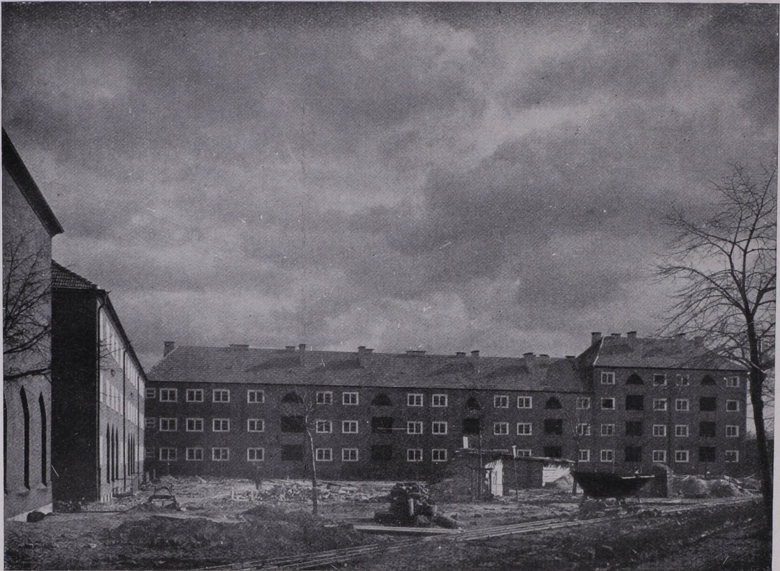
Siedlung Mauenheim („Grüner Hof“)
