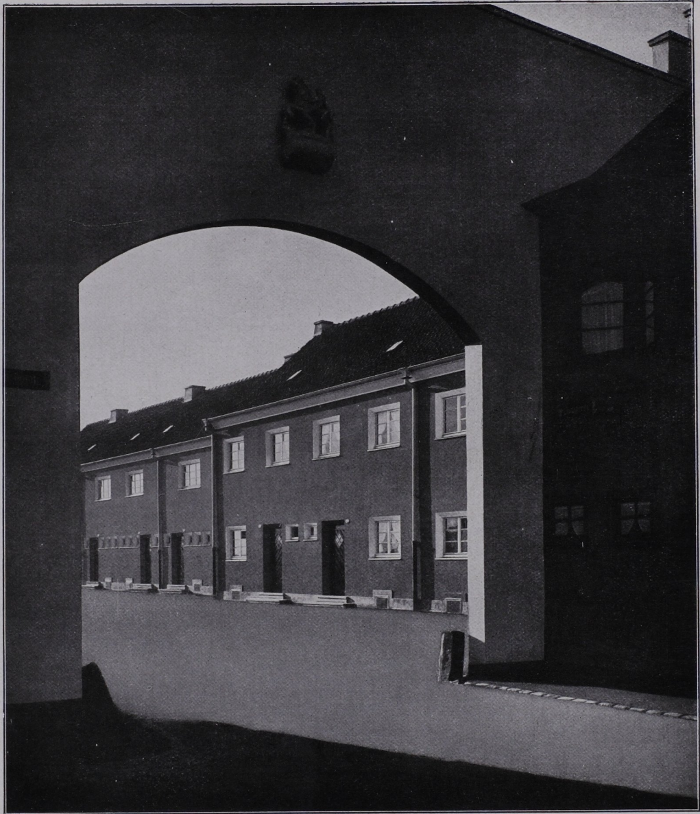
Siedlung Mauenheim Torbogen Guntherstraße
