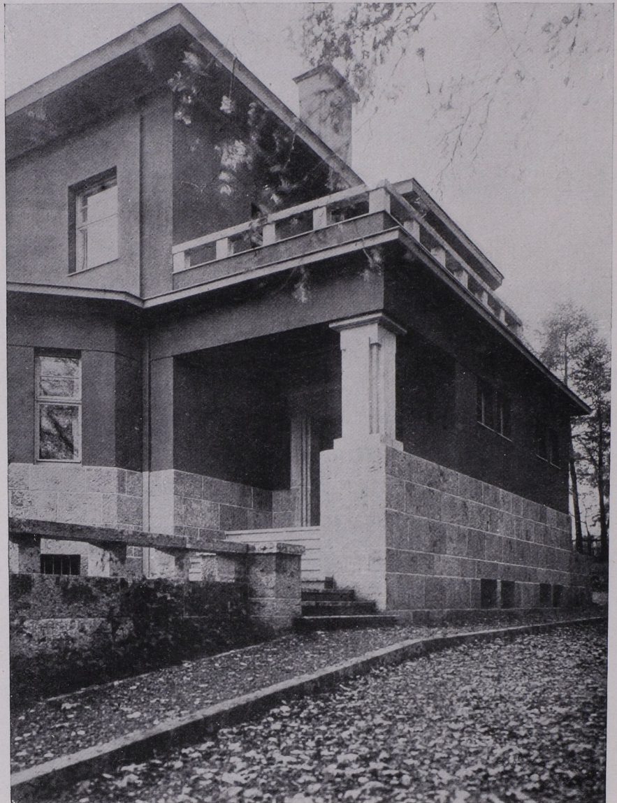
Haus Lessner, Weimar, Haupteingang Architekt Thilo Schoder, Gera
