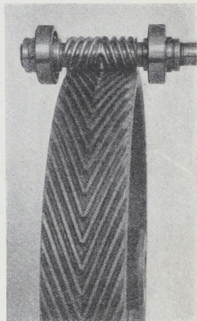
Abb. 1926. Pfeilradgetriebe der Zahnradfabrik Augsburg, vorm. Joh. Renk.
