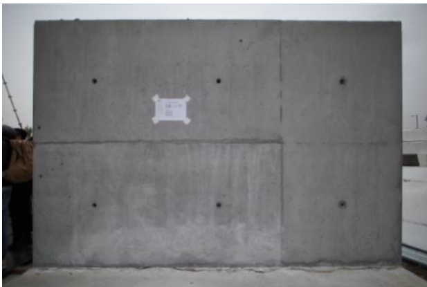
Abbildung 7.31: F5 Musterfläche, Plan und Ausführung 402
