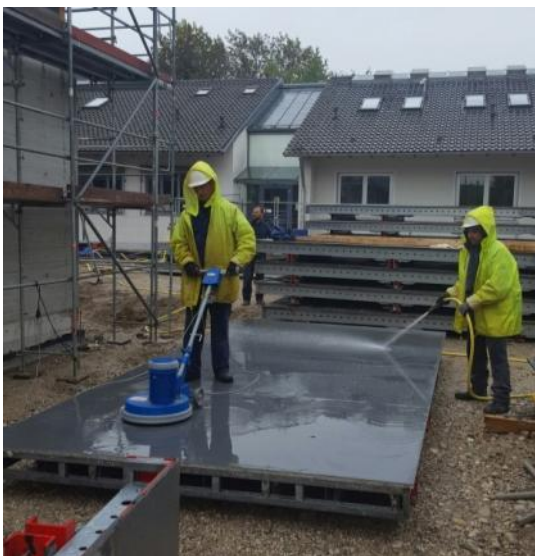
Abbildung 7.1: fachgerechte Reinigung der Schalung [Schmid]
