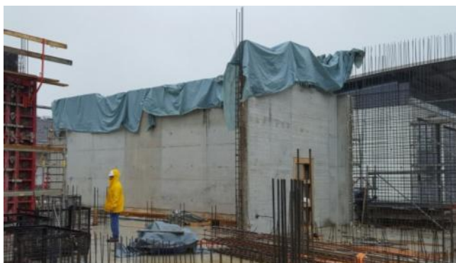
Abbildung 7.10: Schutz der Anschlussbewehrung mit Folie [Schmid]
