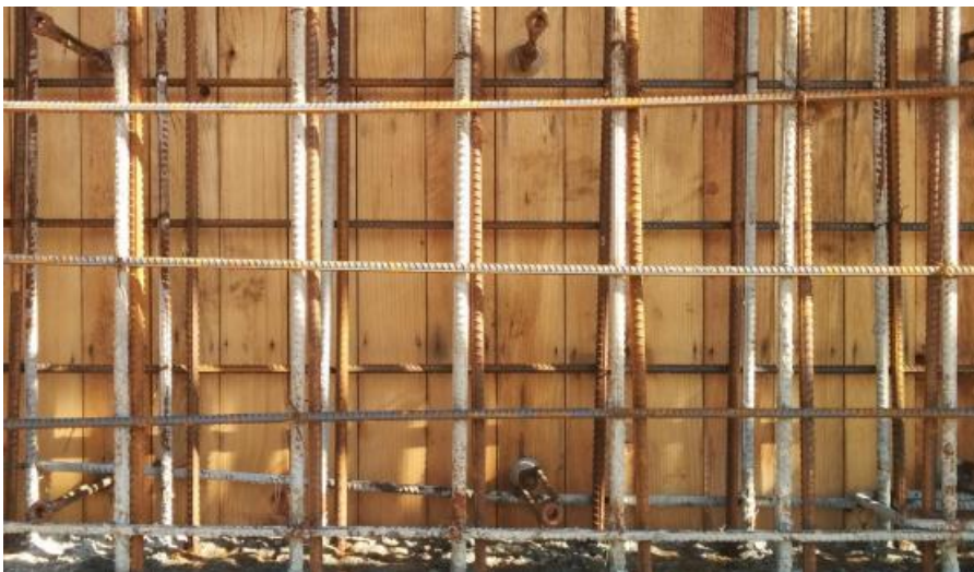
Abbildung 6.35: Ankerkonen mit Schalungsanker 324
