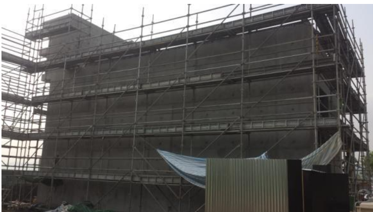
Abbildung 7.26: Ost Ansicht eingerüstet [Schmid]
