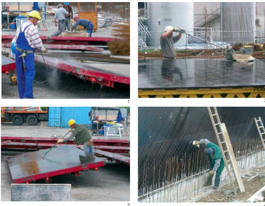
1 Auftrag mit Spritzdüse 2 verteilen mit Poliermaschine
