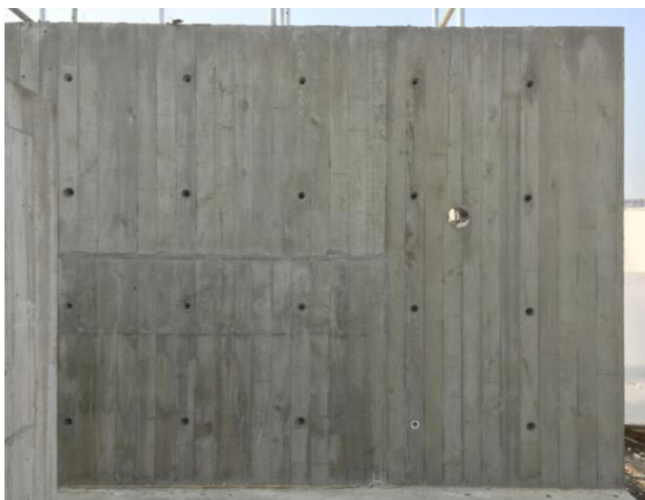
Abbildung 7.30: F3+ Musterfläche, Plan und Ausführung 401
