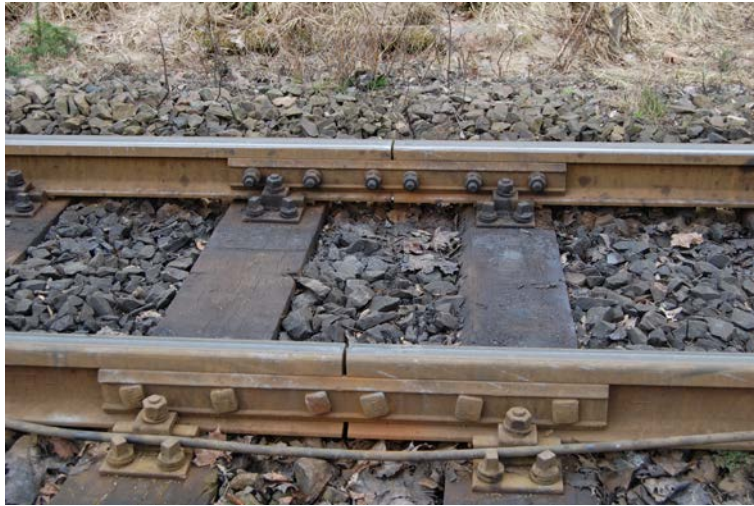
Abbildung 4.26: Unverschweißter Schienenstoß
