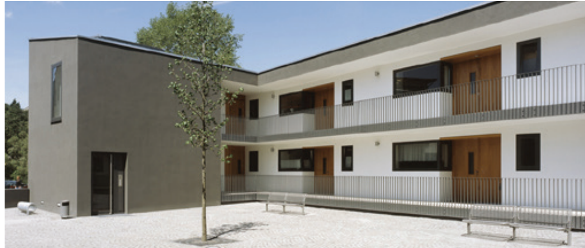
Abb 66 | Geriatriezentrum Santa Rita
