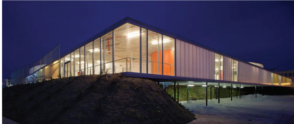
Abb 80 | Geriatriezentrum Santa Rita
