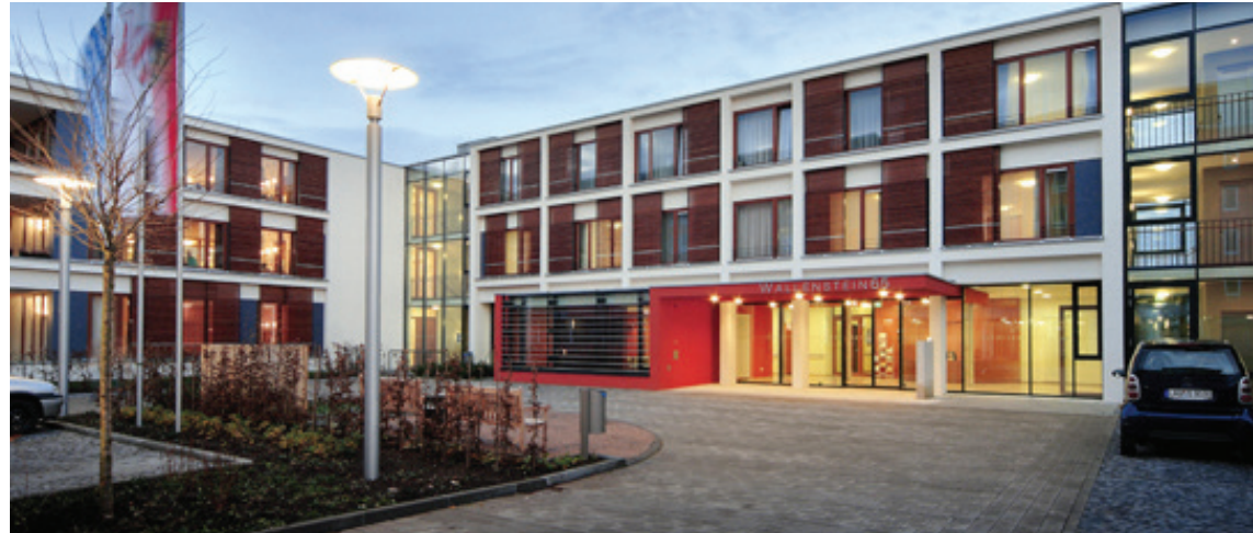
Abb 73 | Geriatriezentrum Santa Rita
