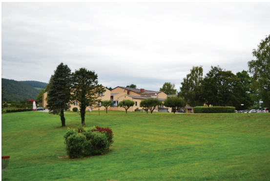
WEG 07| Bauteil Josefhof - Abbruch
