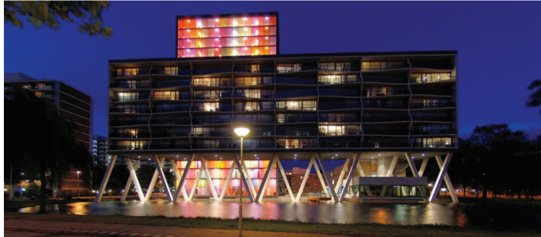
Abb 56 | Geriatriezentrum Santa Rita
