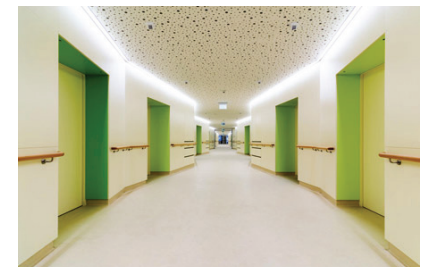
Abb 94 | schallabsorbierende Decke - Landespensionisten- & Pflegeheim Hainburg
