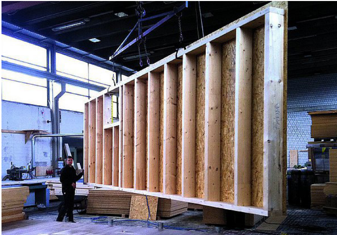
Abb. 07 Vorfertigung einer Holzrahmen-Wand im Werk
