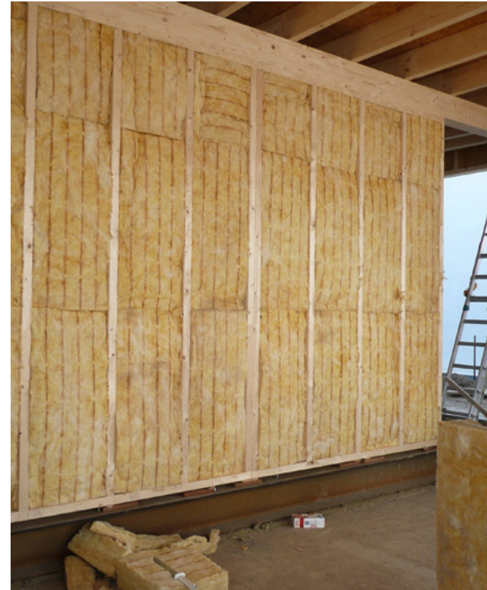
Abb. 08 Ausgedämmte Holzrahmenwand
