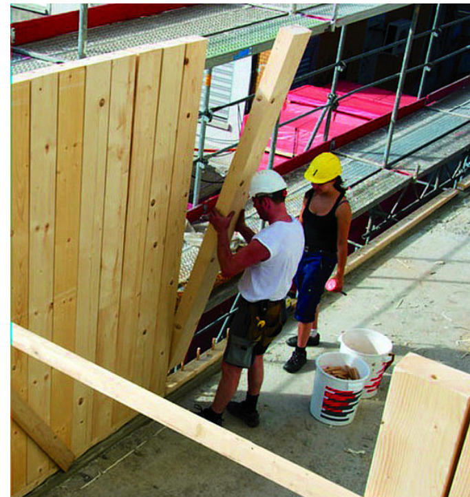
Abb. 12 Montage einer Wand im TopWall-System
