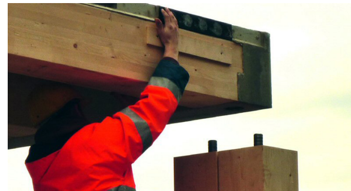
Abb. 11 Montage Deckenelement (Dorne in Stützenköpfen)
