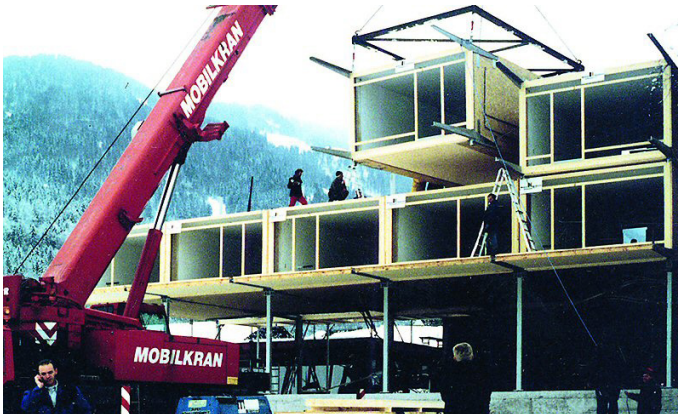
Abb. 19 Errichtung eines Gebäudes in Zellenbauweise
