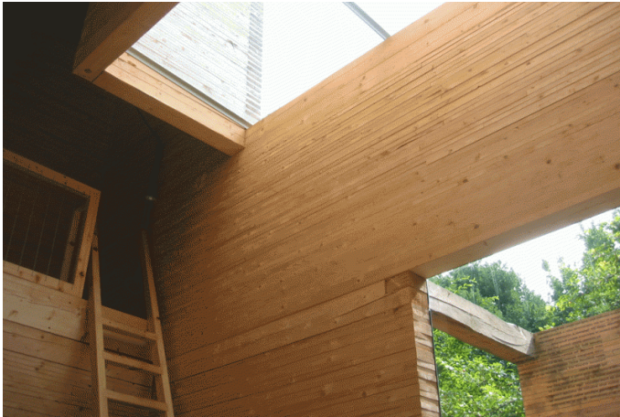
Abb. 15 Brettstapelholzwand
