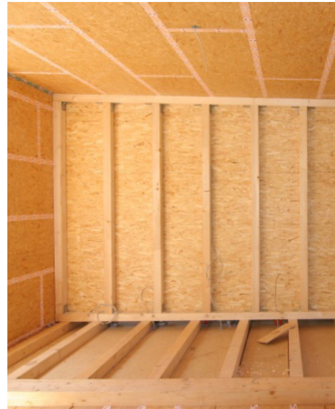
Abb. 22 OSB-Platten mit verklebten Stößen als dampfsperrende Schicht
