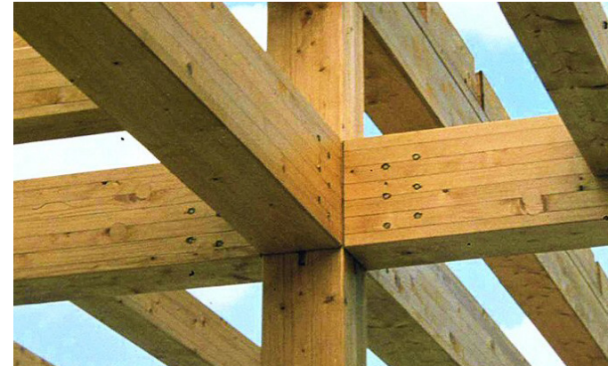
Abb. 10 Knotenpunkt im Skelettbau
