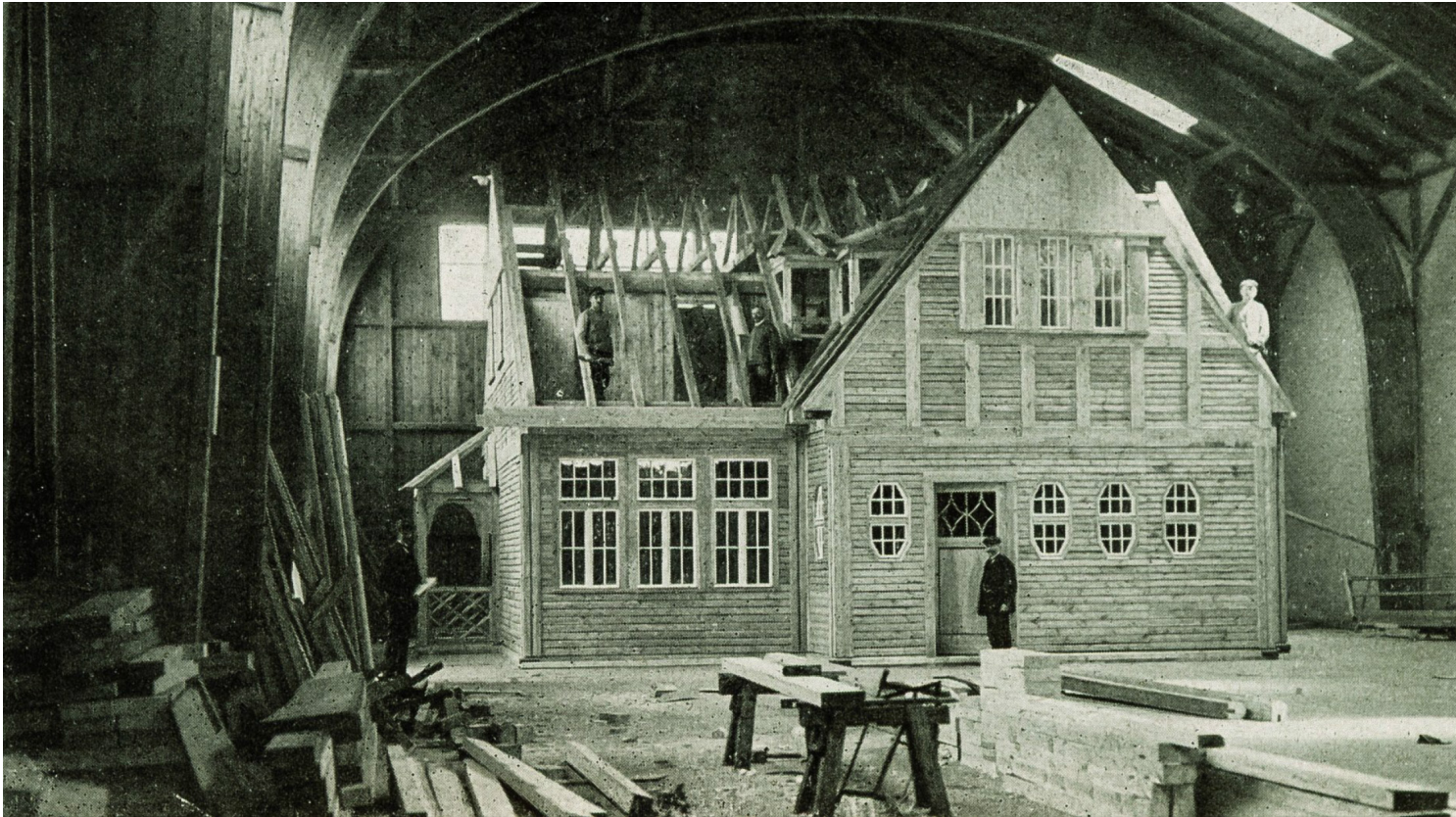
Abb. 04 Vorfertigung und Aufbau der Häuser in der Werkshalle
