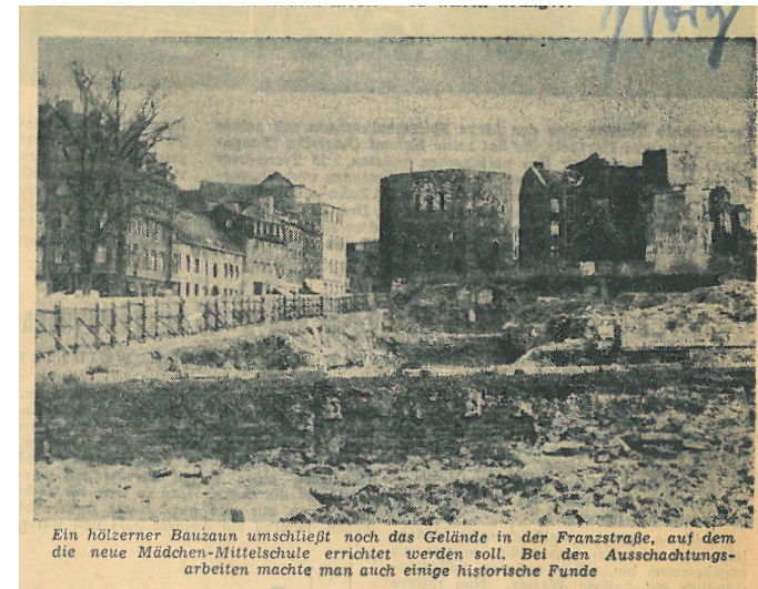
Abb. 53 Bauplatz im Jahr 1951
