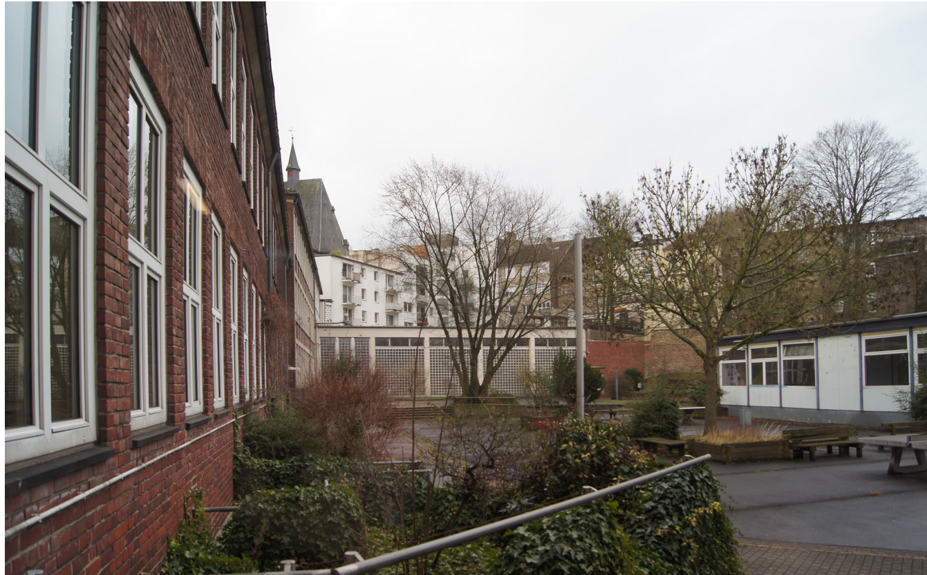
Abb. 61 Block Franzstraße hofseitig und Turnsaal
