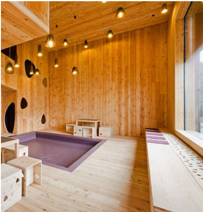
Abb. 17 Brettsperrholzsichtoberflächen in einem Kindergarten in Augsburg
