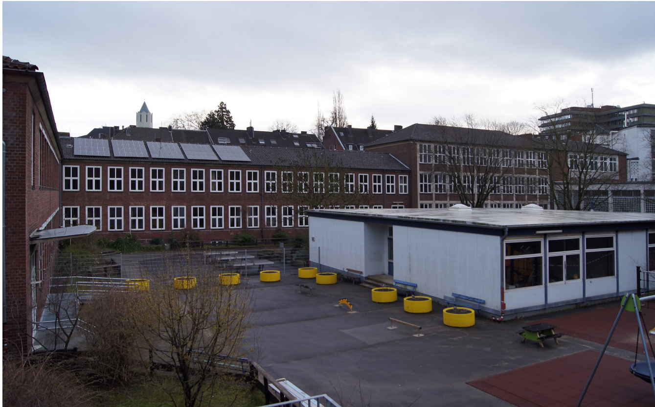
Abb. 62 Block Franzstraße hofseitig und Container-Pavillon
