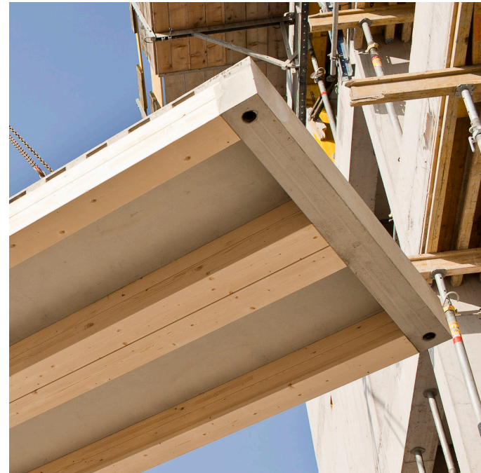
Abb. 21 Holz-Beton-Verbunddecke
