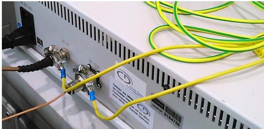
Abbildung 10: Zusätzliche Erdung der Anschlüsse der Sensortelemetrie
