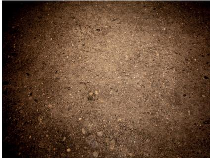
**Bodenbelag** Erdböden mit Mörtelzusatz als Fußboden
