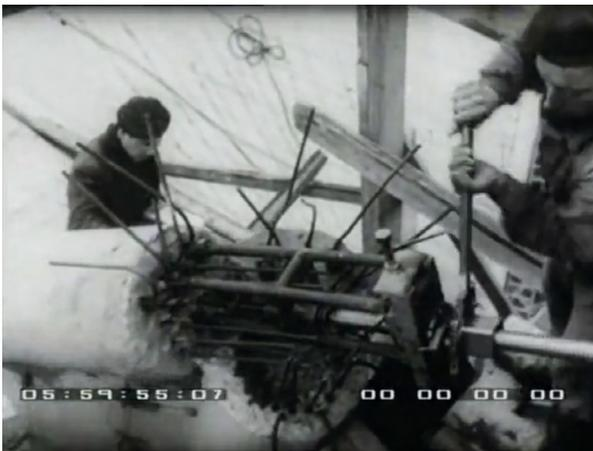
**15** Verbindung der Stahlbetonträger, an denen die Zugseile eingespannt wurden.
