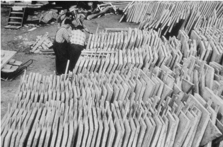
**8** Die gegossenen und nummerierten Module, bereit zur Anbringung auf das Lehrgerüst.
