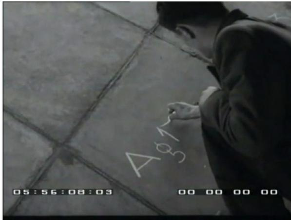
**11** Nummerierung der Position der einzelnen Platten, für einen exakten Wiederaufbau vor Ort.
