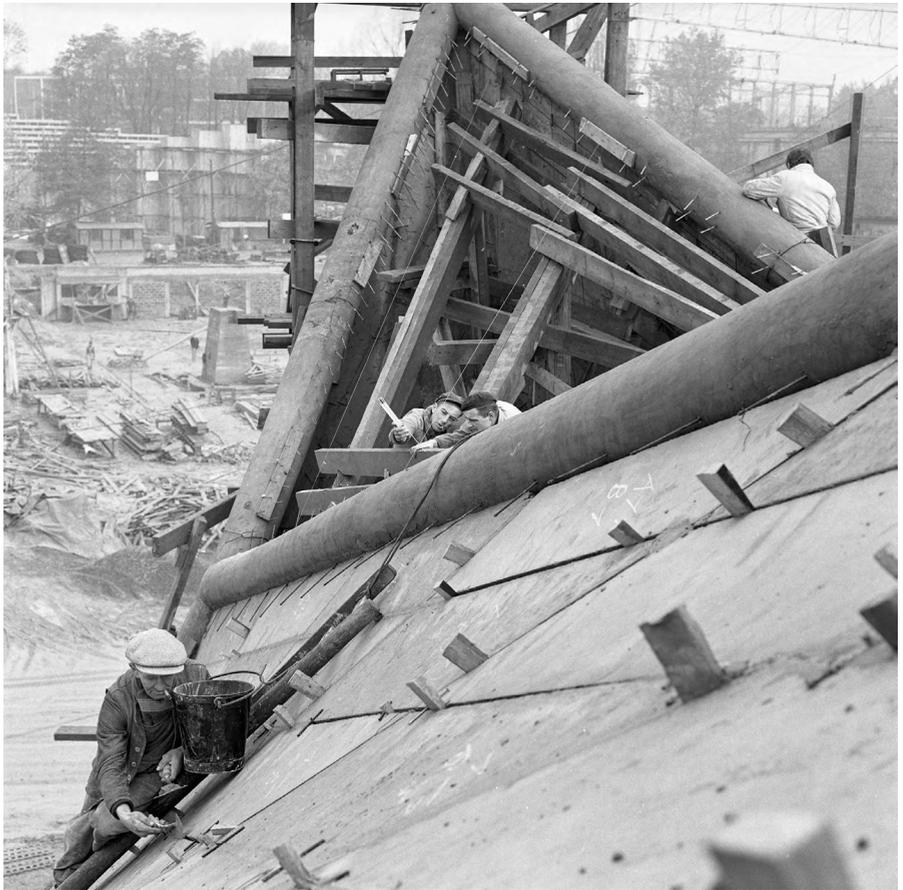
**44** Pavillon in der Bauphase. Module wurden auf das Lehrgerüst angebracht, durch Abstandhalter auf Distanz gehalten, um die Fugen mit einer Füllmasse zu versiegeln.
