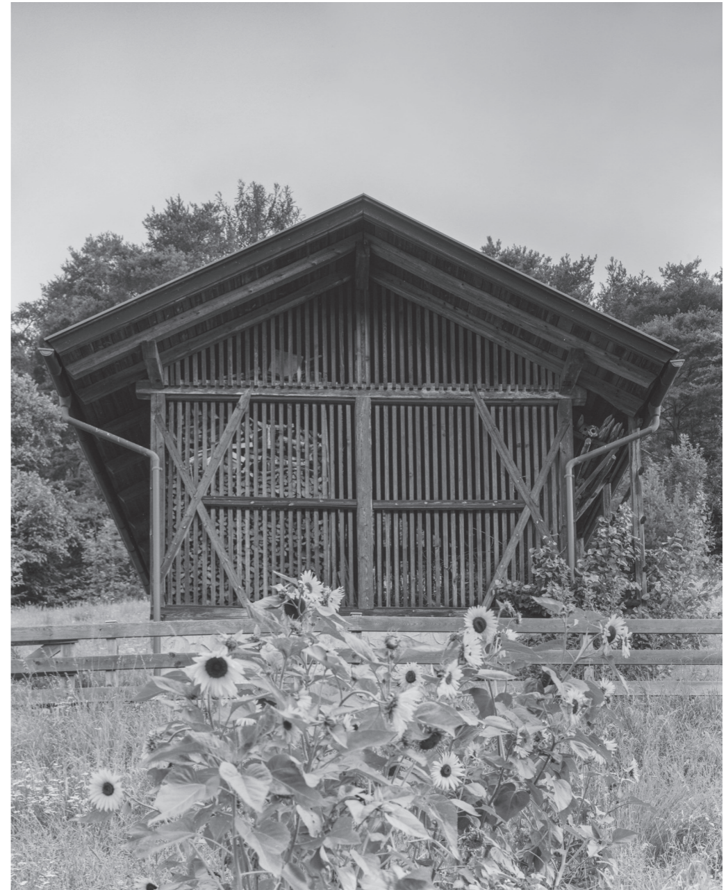
29. Architekturfotografie | Stall/Stadel | Ansicht Süd
