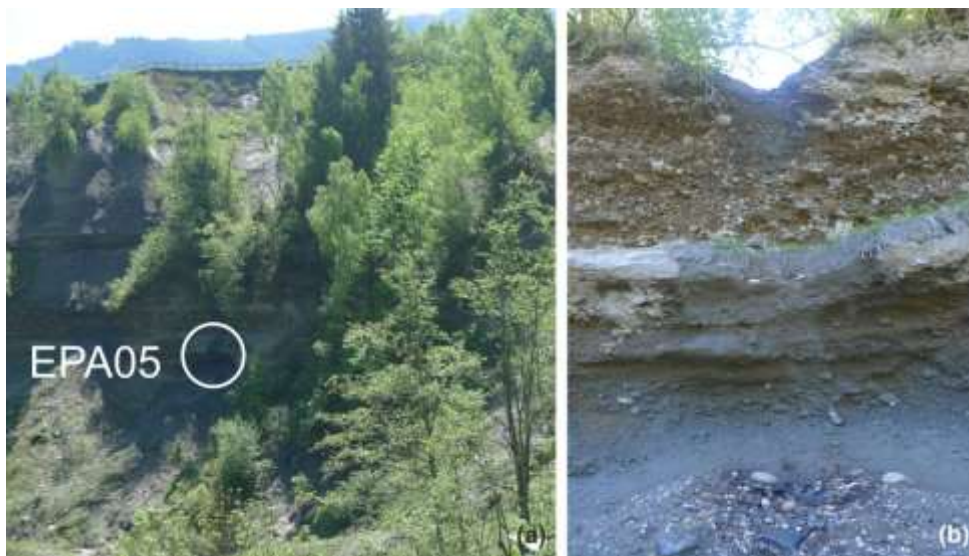
Abbildung 24 (a) Überblicksfoto der Quartären Ablagerung bei EPA05. (b) Detailaufnahme von EPA05.
