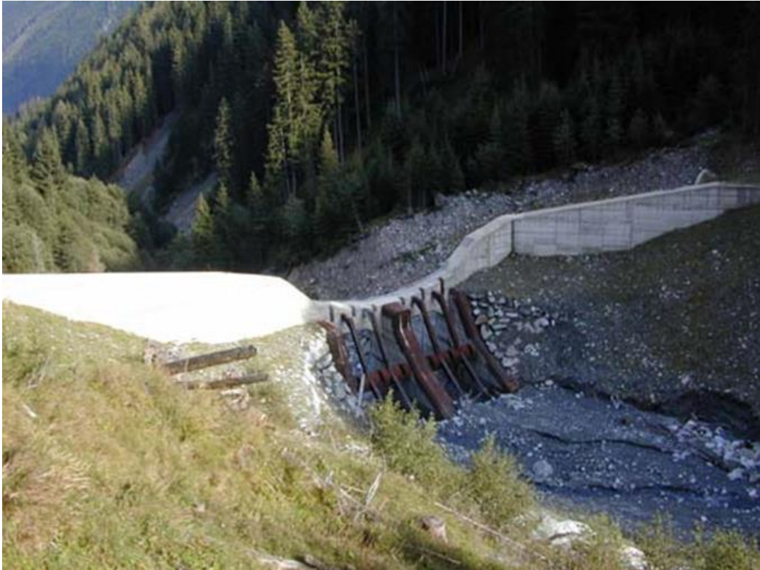
Abbildung 25: Sortierwerk hm 22,24, Mittellauf des Blaubaches, Foto Kaufmann 2005
