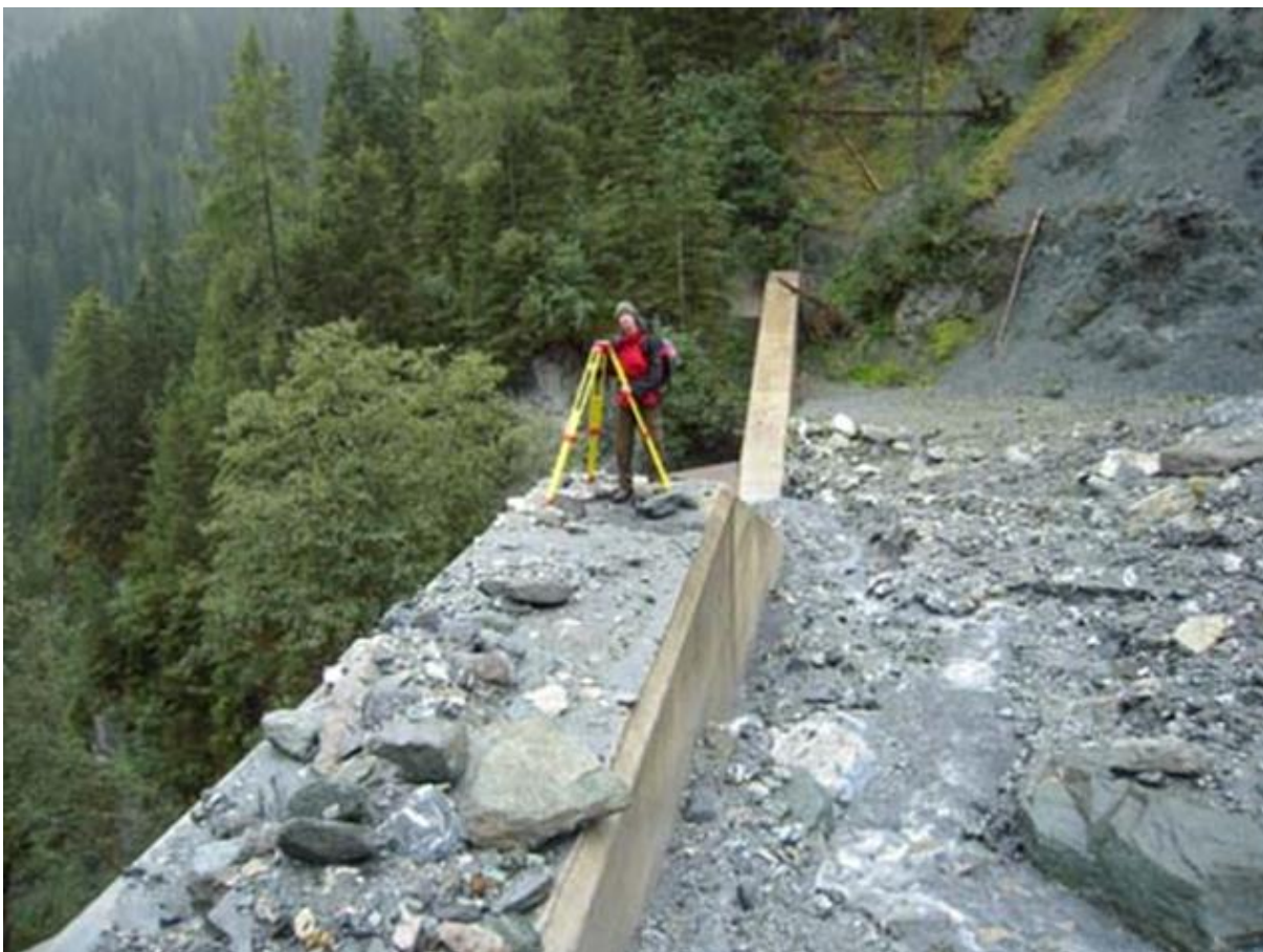
Abbildung 27: Konsolidierungssperre mit Material- Überschiebung, Foto Kaufmann 2010
